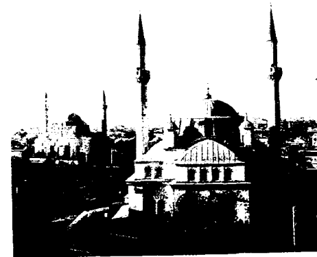
Muradiye Camii, Manisa güneyden görünüş
