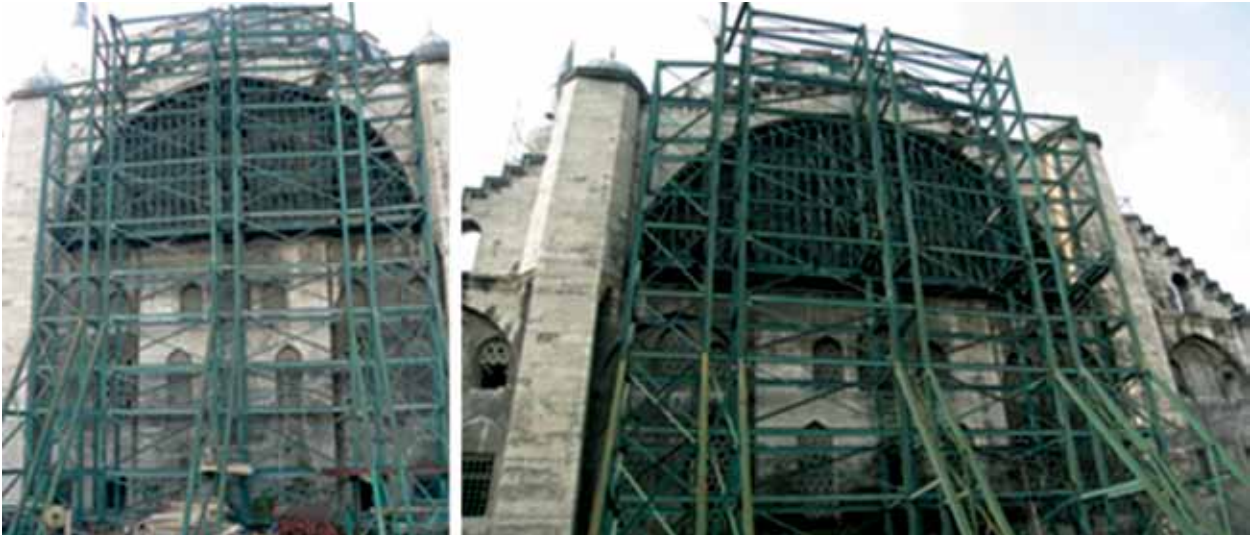
Fotoğraf 6-7. Mihrap cephesi ana kemerinde yapılan çelik askı sistemi.
