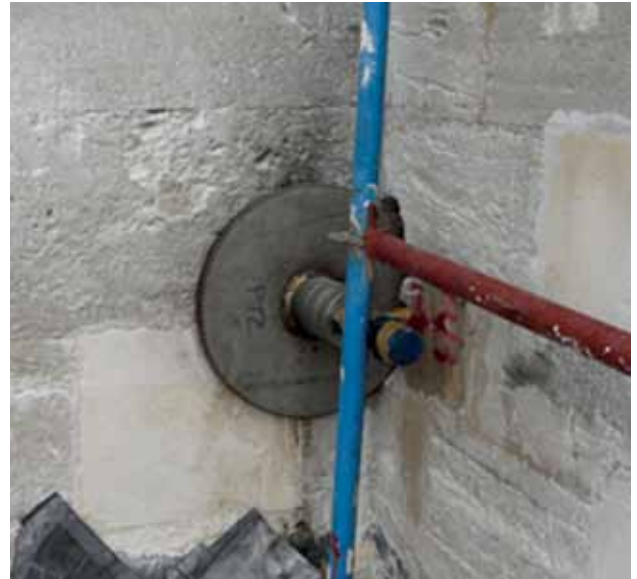
Fotograf 12-13. Mihrap cephesi ana kemerinde düzenlenen gergi ve ankraj detayı.
