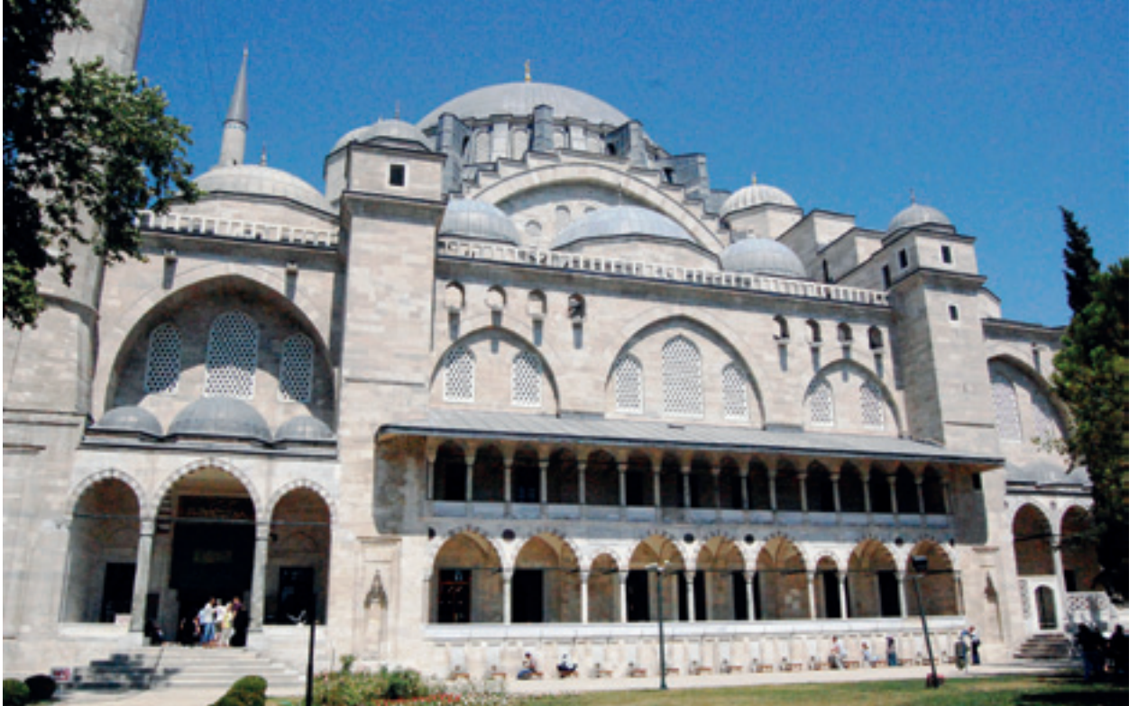
Fotoğraf 3 Restorasyon sonrası caminin batı cephesi
