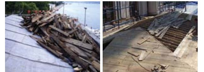
Resim, 36 ve 37- Hünkar Mahfili eski karkas ve yeni kaplama tahtaları
