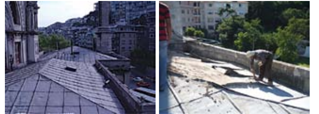
Resim, 32 ve 33- Hünkar Mahfili eski çatısı ve kurşun sökülümü
