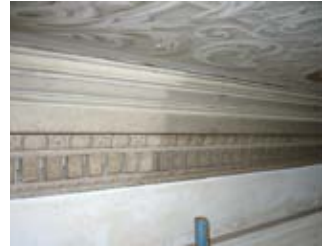
Resim, 53 ve 54- Non-iyonik deterjanla kalemişi yüzeylerde temizlik yapılması
