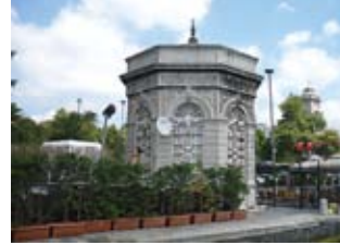
Resim, 43- Muvakkithane cephe temizliği öncesi
