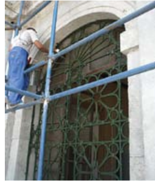
Resim, 45- Raspa edilmiş demir korkuluklara antipas sürülmesi
