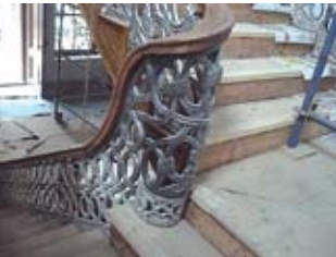
Resim, 74- Merdiven korkuluğu (yeni imal edilen eksik parça)
