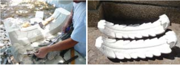
Resim, 26 ve 27- Minare Şerefe altı taş yapraklarının yeniden imalatı
