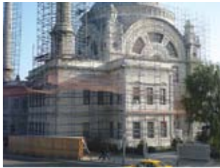
Resim, 41- Batı cephesi temizlik sonrası
