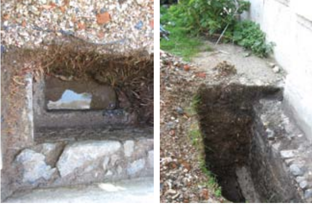
Resim, 83 ve 84- Araştırma kazıları sonrasında ulaşılan ampatman temel
