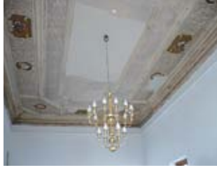
Resim, 58-Non-iyonik deterjanla kalem işi yüzeylerde temizlik yapılmış
