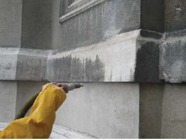
Resim, 39- Kumlama ile cephe temizliği yapılması
