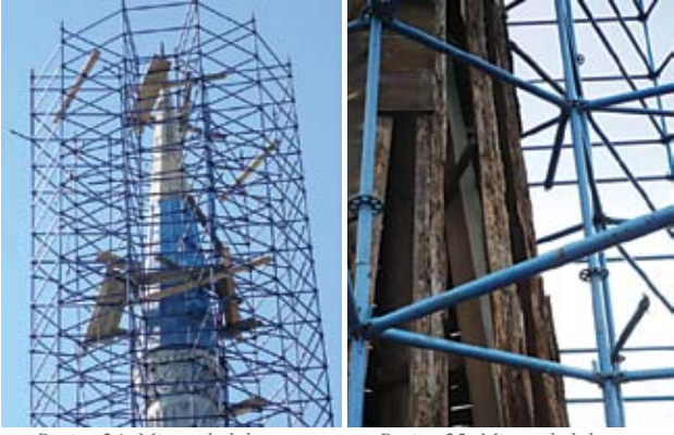
Resim, 24- Minare külahının sökülümü
