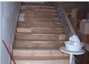
Resim, 75- Merdiven (raspa sonrası)
