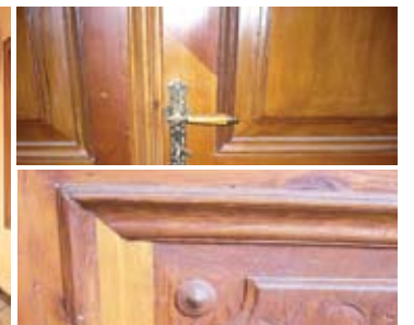
Resim, 68 ve 69- Yeni imal edilmiş kapı kolu ve itinalı raspa edilerek ortaya çıkarılmış dış kapı göbeği
