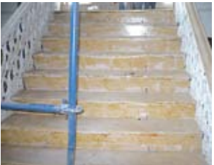
Resim, 73- Merdiven(üzerindeki halı kaldırıldıktan sonra)
