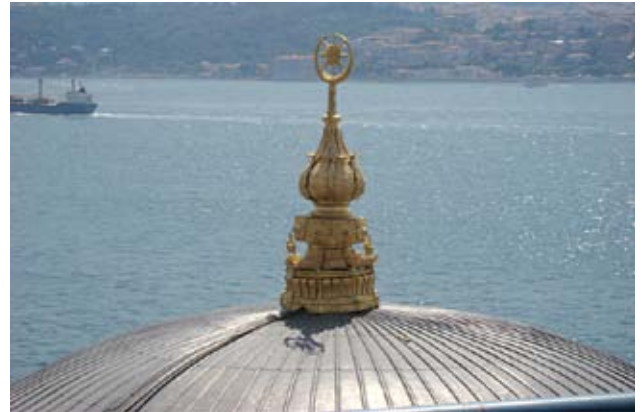
Resim, 23- Kubbe alemi - Onarım sonrası
