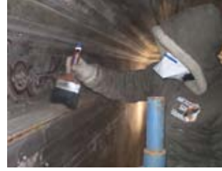
Resim, 51- Kuru temizlik yapılması
