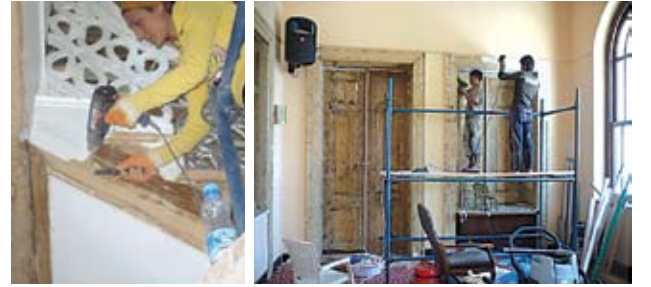
Resim, 63 ve 64- Elektrikli pürmüz yardımı ile ahşap yüzeylerdeki özgün olmayan boyanın raspa edilmesi
