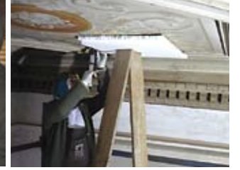
Resim 52-Harç ve sıva tabakasındaki boşluklara özgün harca yakın harç ile müdahale
