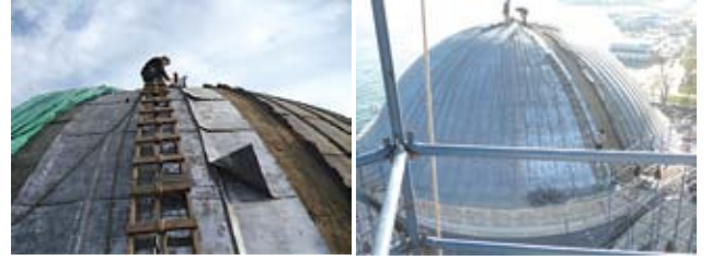
Resim, 30 ve 31- Kubbe eski kurşunlarının sökülülerek yenilerinin takılması
