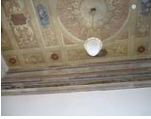
Resim, 57- Non-iyonik deterjanla kalem işi yüzeylerde temizlik yapılmış
