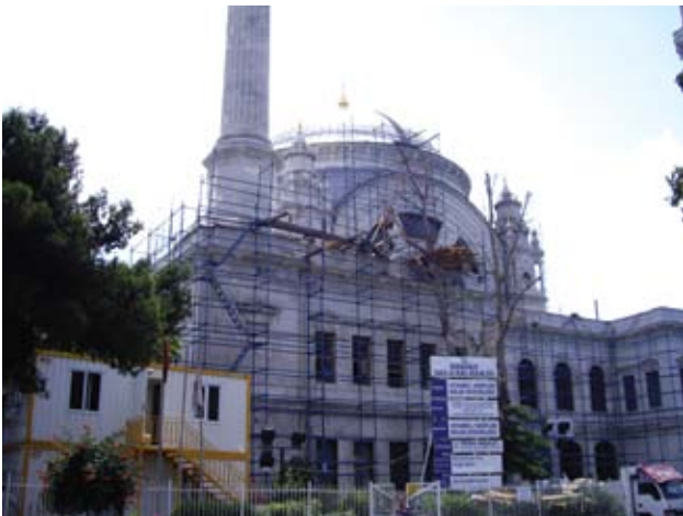
Resim, 15- Şantiye binası, cami kuzey cephesi
