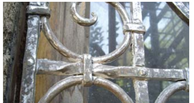
Resim, 47- Raspa edilmiş ferforje korkuluklar
