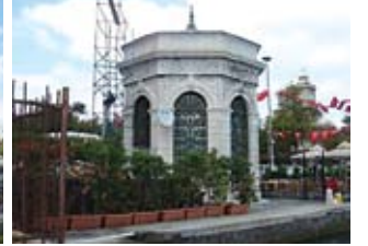
Resim, 44- Muvakkithane cephe temizliği sonrası
