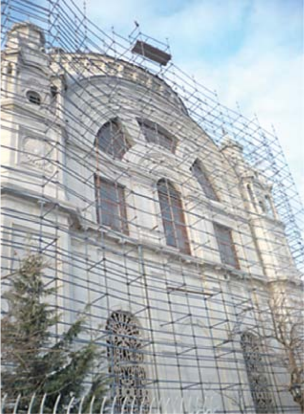
Resim, 19- Güney Cephesi İskelesi
