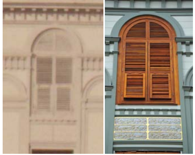
Resim,32- Arşiv fotoğrafına uygun olarak dış cephede ahşap panjurlar yapıldı
