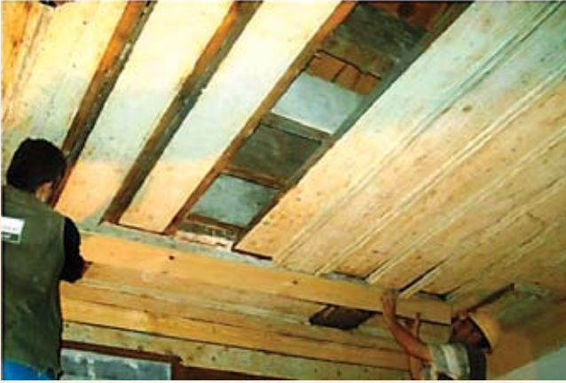
Resim,35- Zemin Kat Harim Tavanlarının Onarılması
