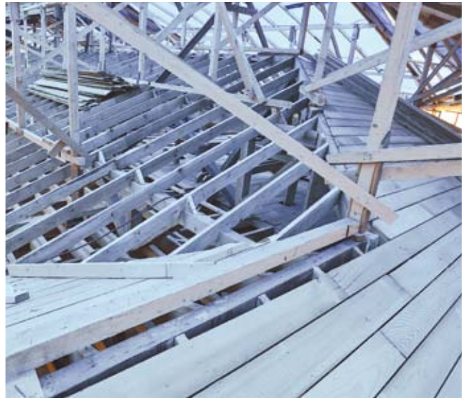
Resim,29- Çatı mertek ve aşık onarımı
