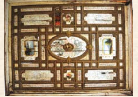
Resim,48- Özgün Hünkâr Tavanına Kimyasal Temizlik Yapıldıktan Sonra
