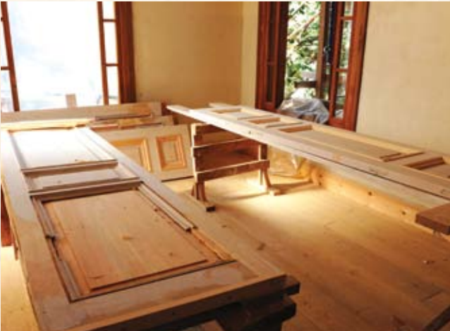
Resim,39- Mevcut kapuların onarılması
