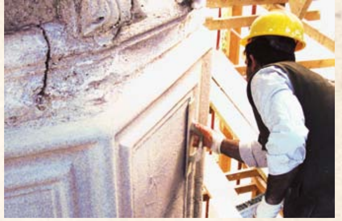
Resim,34- Minarede Hidrolik Kireçli Profilli Sıva Yapılması
