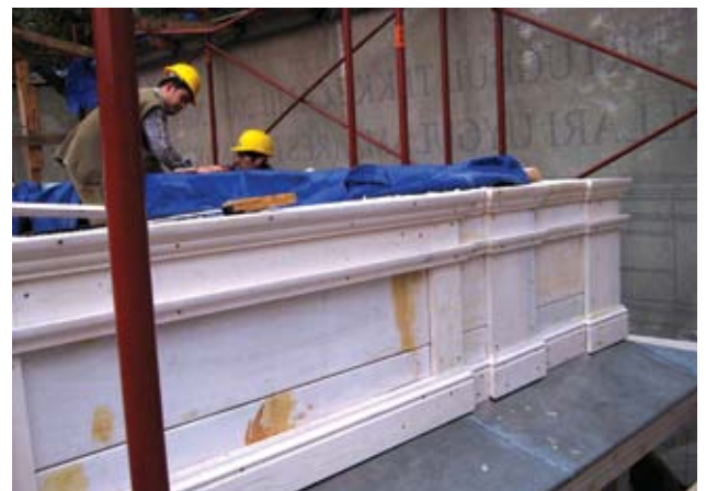
Resim,31- Cephe Profillerinin ve Çinkoların Kaplanması
