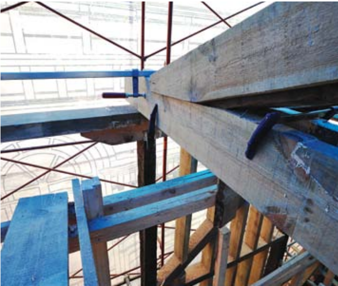
Resim,28- Çatı makas onarımı
