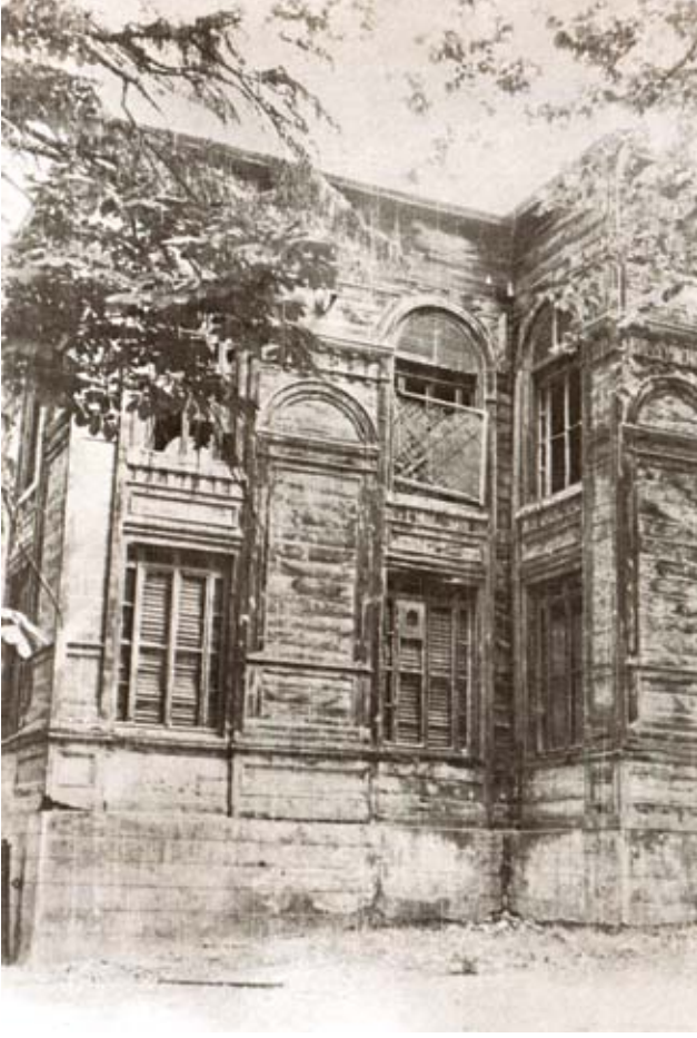
Resim,16–Hünkâr Mahfili Cephesi (1969)
