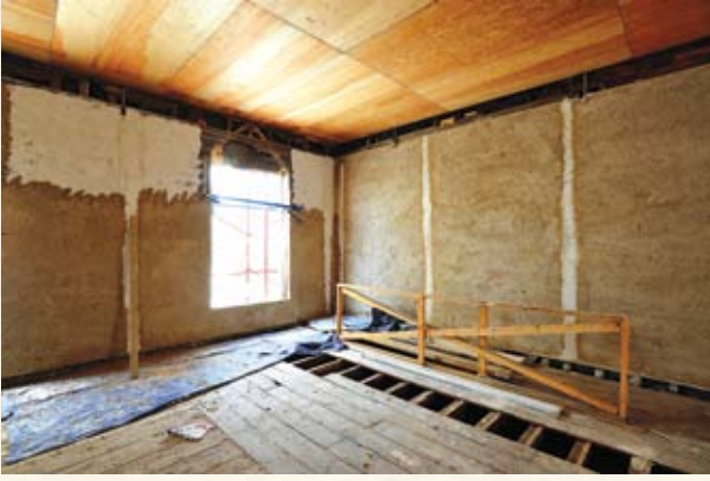
Resim,33- İç mekânlarda Kireçli Kıtıklı Sıva Yapılması
