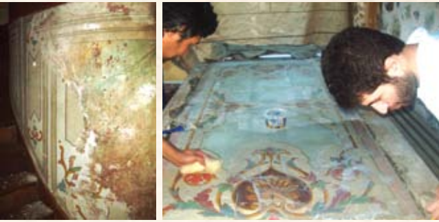
Resim,44-Özgün tavan bezlerinin kimyasal yöntemle temizlenmesi
