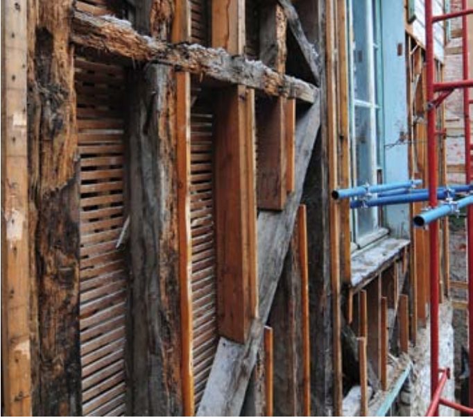
Resim,18- Çatı ve Yapı Karkasında Oluşan Hasarlar
