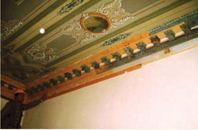
Resim,37- Geometrik Tavanların Onarılması
