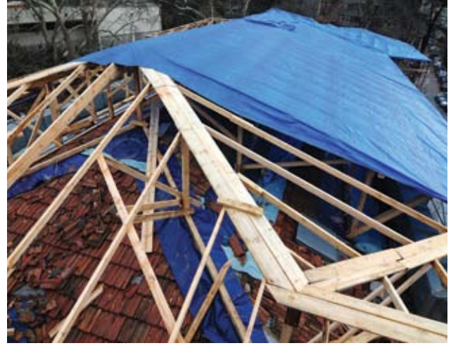
Resim,25- Tüm yapı üzerine yapılan geçici çatı
