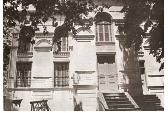
Resim,7- 1972 Onarımı Sonrası Hünkâr Mahfili Cephesi (V.İ.İ.B.M.A.)
