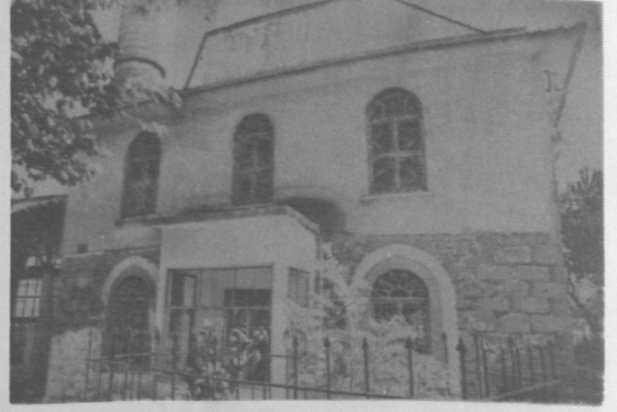
FOTO. 10- Şadırvanlı Camii kuzey cephesi
