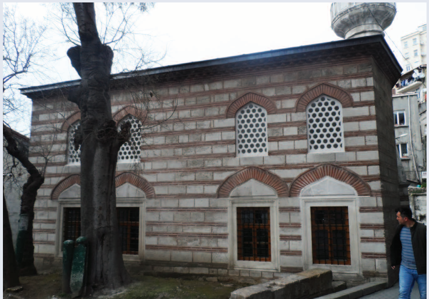
Restorasyon (tamamlama) sonrası cami
