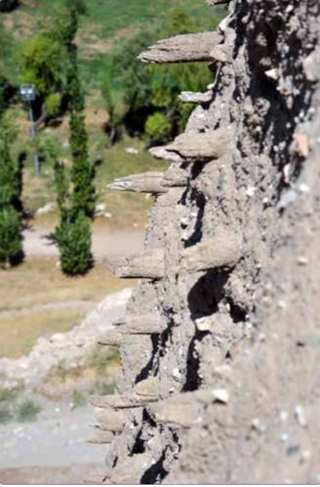
Şekil 5. B Burcu'ndaki kerpiç duvar örgüsüne dik olarak kurgulanmış ahşap hatılardan detay.
