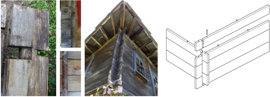
Resim 5. Duvar kalas elemanlarının köşe birleşimleri
