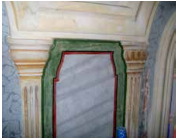
Fotoğraf 8b. Merkezi kubbe geçiş bölgesi yüzeylerde taş taklidi bezeme onarım sonrası.
