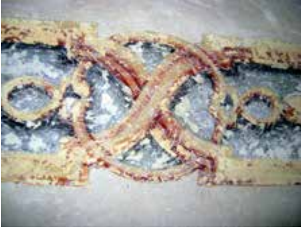
Fotoğraf 1b. KK1' de kalemişi geçme bordür raspa sonrası.
