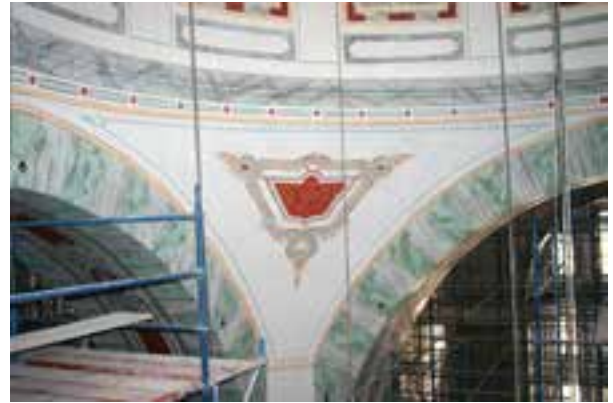
Fotoğraf 4b. Köşe kubbelerine geçiş pandantif yüzeylerde bezeme, onarım sonrası.
