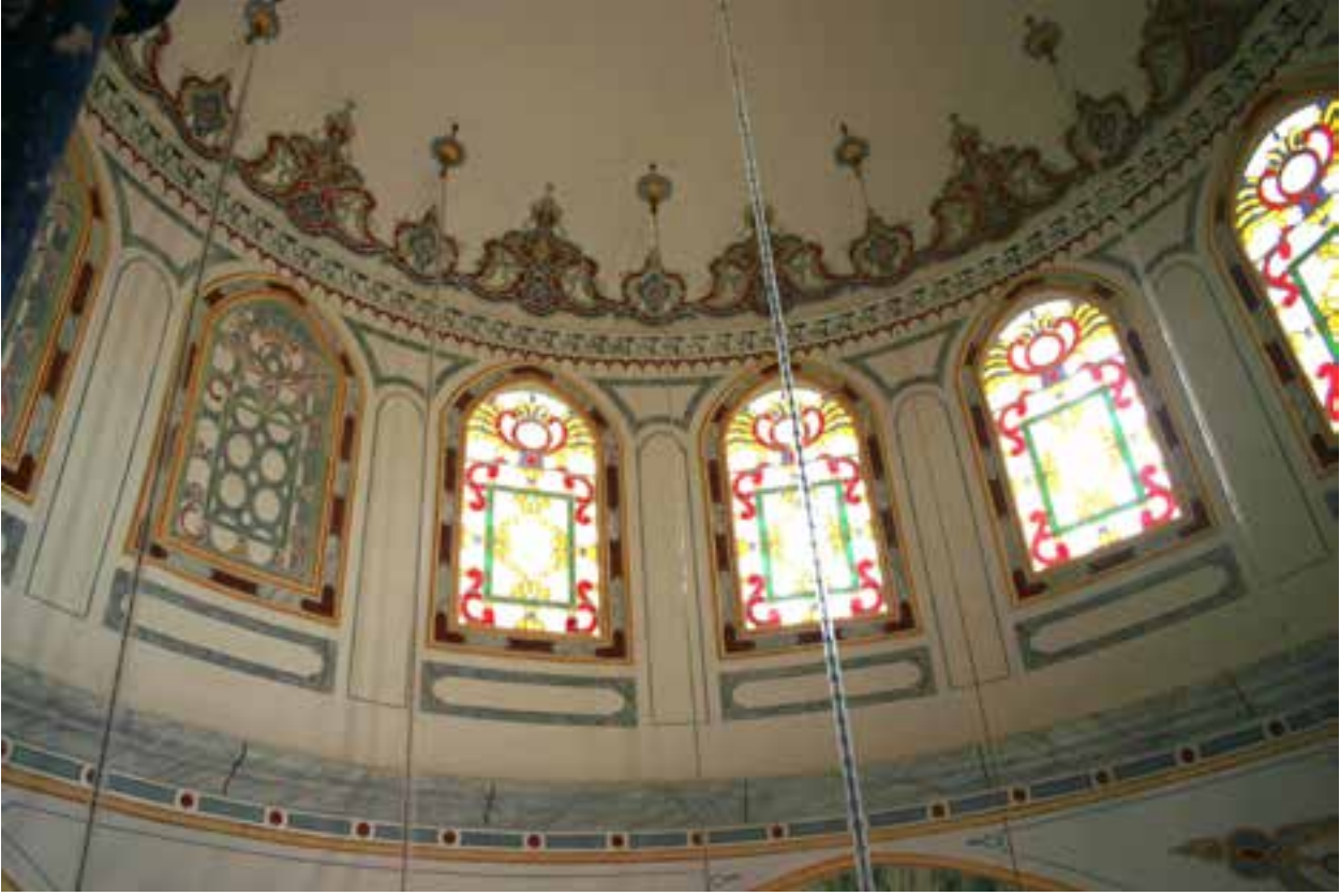
Fotoğraf 1a. F.C.Köşe kubbe (KK1) den kalemişi bezeme örneğinin onarım sonrası.
