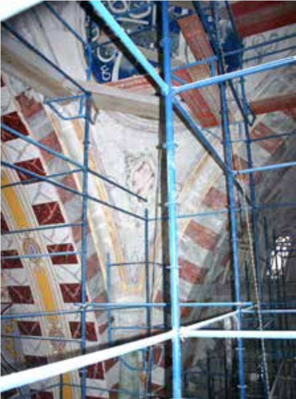
Fotoğraf 7b. Pandantiflerde madalyon dışındaki üçgen yüzeylerde bezeme raspası
