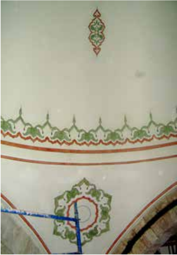
Fotoğraf 10c. Revak kubbelerinde buluntuya uygun uygulama.
