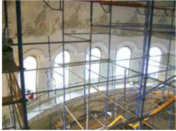
Fotoğraf 5d. Merkezi kubbeye kubbe eteği-pencere tepeliği bezemesi raspa sonrası.
