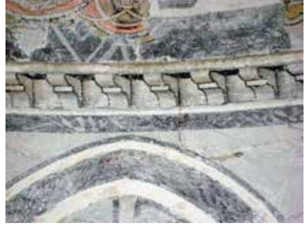
Fotoğraf 1c. KK1'de kubbeye geçiş bölgesi raspa sonucu kalemişi konsol dizini.
