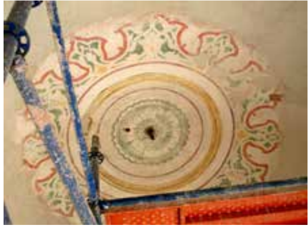
Fotoğraf 10b. Son cemaat yeri kubbelerinde raspa sonucu özgün bezeme.
