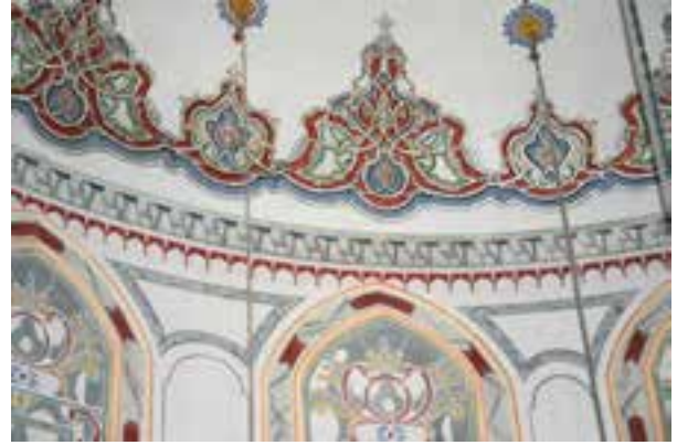
Fotoğraf 4a. F.C.Köşe kubbelerinde kubbe eteği bezemeleri onarım sonrası.
