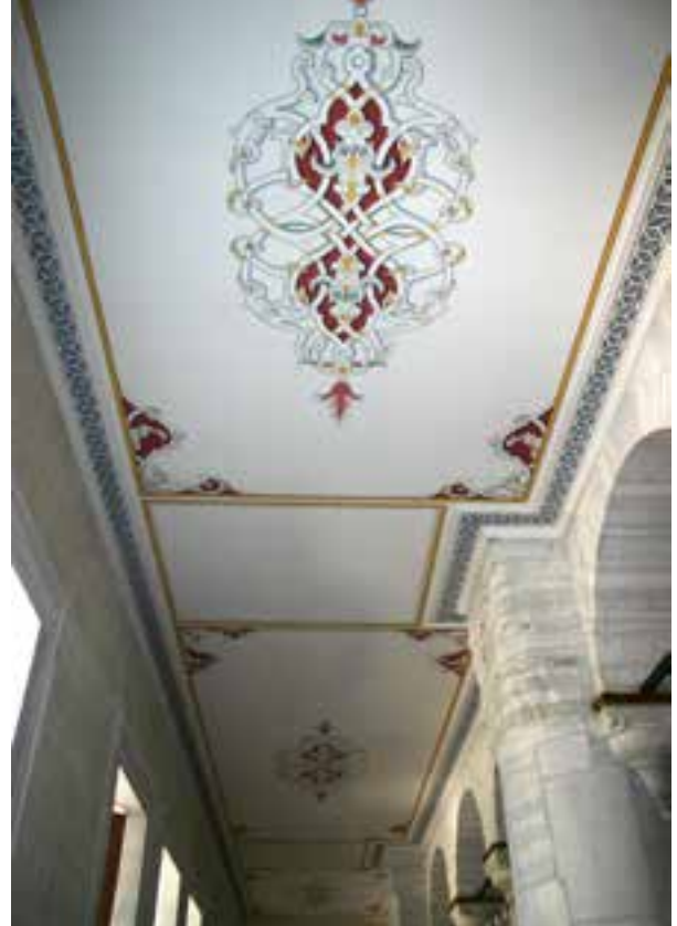
Fotograf 13b. Hünkâr köşkü rampa mekânı tavan bezemesi, uygulama sonrası.
