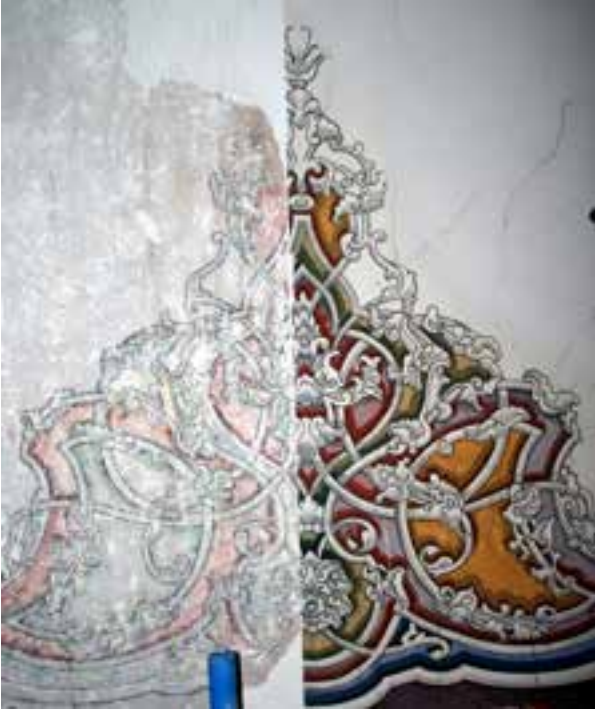
Fotoğraf 1d. Merkezi kubbe eteğinde yer alan mevcut ve raspa sonucu bezeme örneği.
