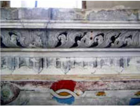
Fotoğraf 5e. Merkezi kubbeye geçiş bölgesi-dolaşmalık altı raspa sonuçları.
