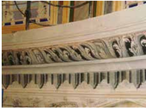
Fotoğraf 5f. Merkezi kubbeye geçiş bölgesi-dolaşmalık altı bezemesi onarım sonrası.
