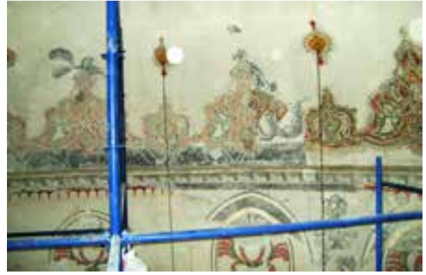
Fotoğraf 3. F.C. diğer köşe kubbelerinde yapılan raspa sonucu bezeme benzerliği.
