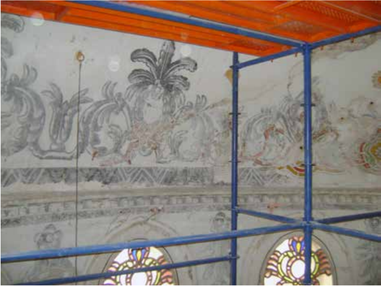
Fotoğraf 6 KK1 Kubbe Eteği Bezemesi 1.Raspa
