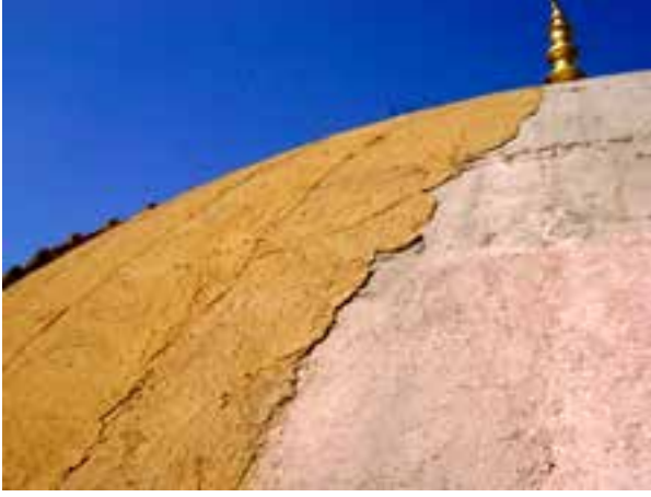
Fotoğraf 36-37. Merkezi kubbe üstünde horasan siva, çamur siva ve kurşun değişimi.
