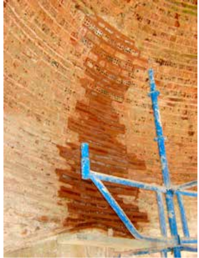
Fotoğraf 2-3. Revaklı avlu kubbesinde bulunan çatlağın tuğla dikiş ile onarılması
