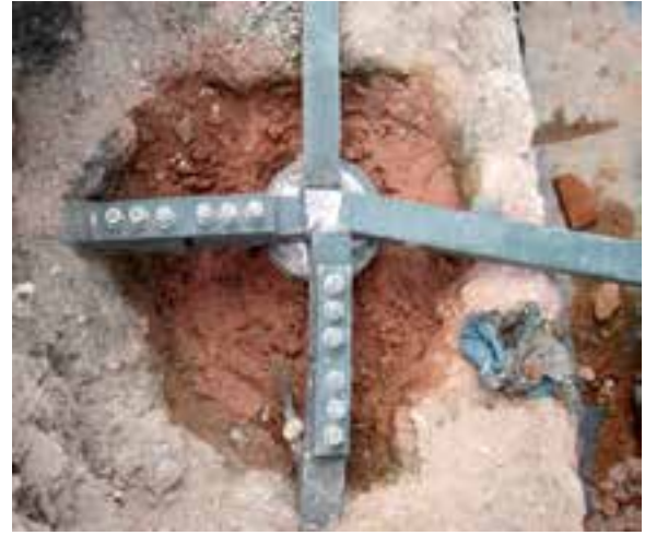
Fotoğraf 12-13-14-15. Özgün malzemesi ve kesitiyle ek yapılan demir hatıllar
