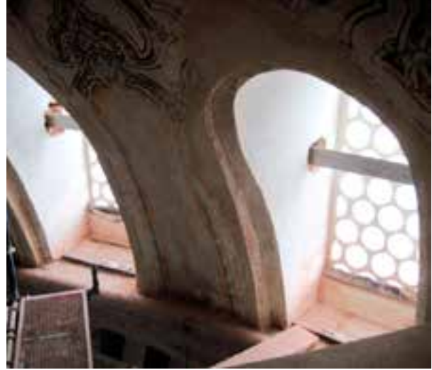
Fotoğraf 22-23-24-25. Pencere içlerinde kesilmiş bulunan ahşap hatıllar.
