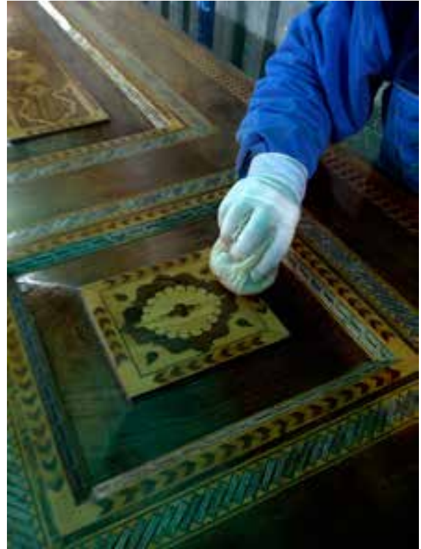
Fotoğraf 55,56. Ahşap kepenkler üzerinde gomalak cila uygulaması.
