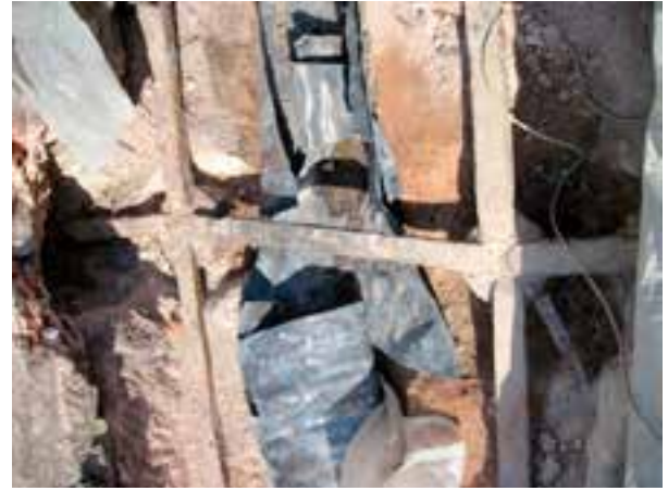
Fotoğraf 10-11. Korozyona uğramış demir hatıl ve hatıl bağlantıları
