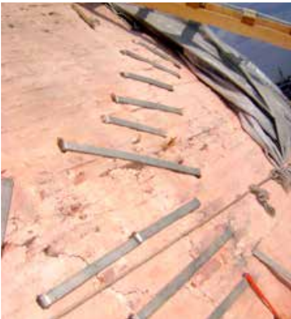
Fotoğraf 5-6-7-8. Merkezi kubbe üzerinde ortaya çıkan çatlaklara yapılan paslanmaz çelik kenet dikiş müdahalesinin aşamaları
