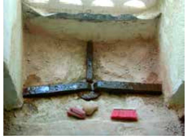
Çizim 4. Yarım kubbe pencere hizasında bulunan demir hatılların yerini gösteren kroki
