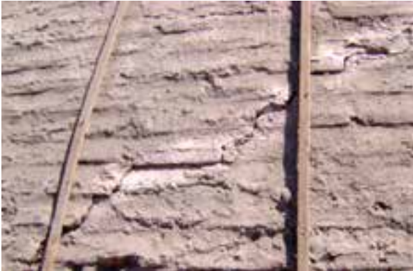
Çizim 2. Yarım kubbe üzerinde ortaya çıkan çatlağın paslanmaz çelik kenetlerle dikilmesi
