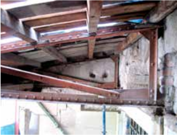
Fotoğraf 68-69. Ahşap çatı söküldükten sonra ortaya çıkan demir makaslar
