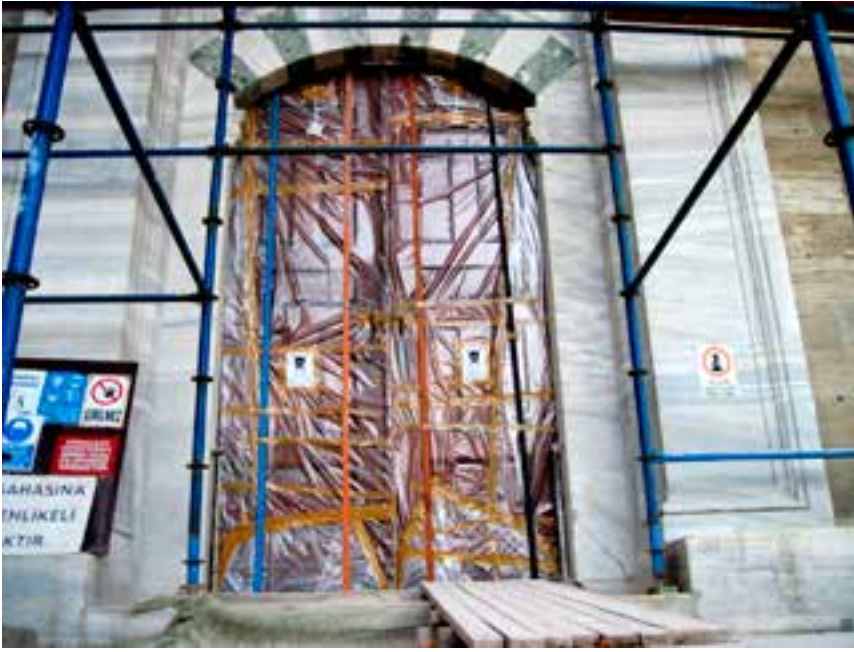
Fotoğraf 53,54. Ahşap kapıda fümigasyon uygulaması ve kapı üzerinde cila temizlenmesi
