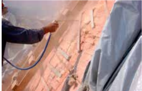
Çizim 2. Yarım kubbe üzerinde ortaya çıkan çatlağın paslanmaz çelik kenetlerle dikilmesi
