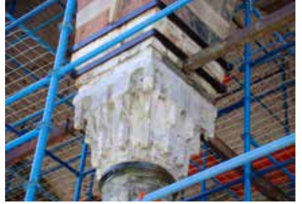
Fotoğraf 47-48-49. Revaklı avlu mermer sütun başlıklarında AB 57 ile temizlik öncesi ve sonrası.
