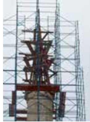
Fotoğraf 76-77. Kurşun kaplaması söküldükten sonra külah strüktürü.
