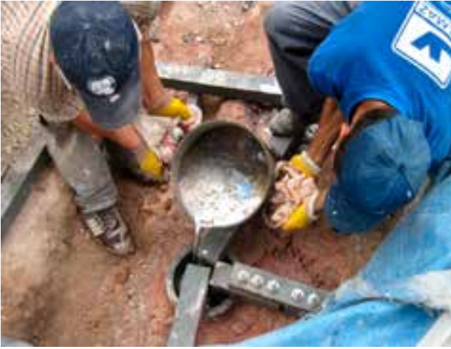
Fotoğraf 12-13-14-15. Özgün malzemesi ve kesitiyle ek yapılan demir hatıllar
