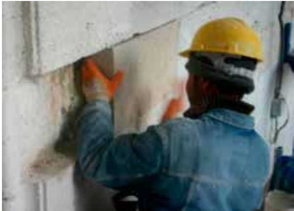
Fotoğraf 42-43-44. Revaklı avlu duvarlarında taş çürütülmesi, yeni taşın paslanmaz çelik zıvanalar ile yerine yerleştirilmesi.
