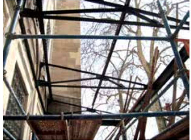
Fotoğraf 68-69. Ahşap çatı söküldükten sonra ortaya çıkan demir makaslar
