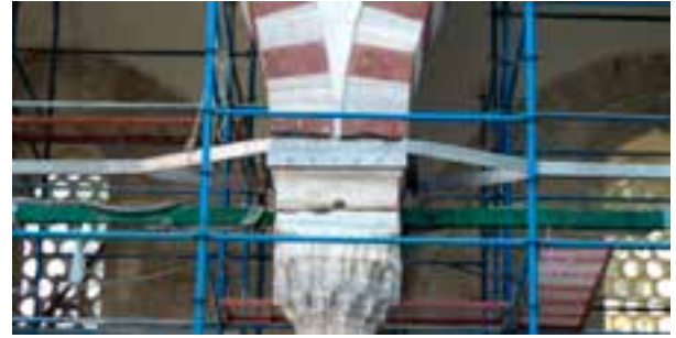
Fotoğraf 26-27-28. Revaklı avluda paslanmaz çelik gergi güçlendirmesi.
