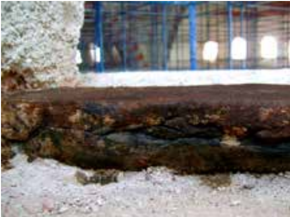
Fotoğraf 18-19-20-21. Pencere tabanlarındaki demir hatıllar
