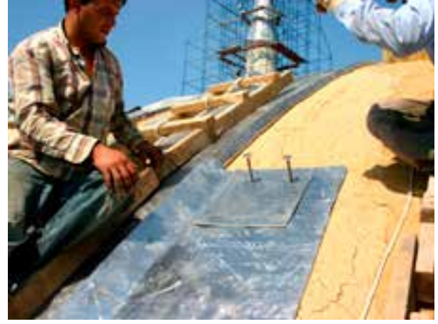
Fotoğraf 36-37. Merkezi kubbe üstünde horasan siva, çamur siva ve kurşun değişimi.
