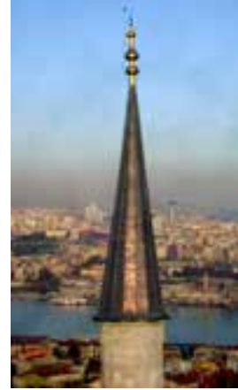
Fotoğraf 80-81. Kaplama tahtası, keçe ve kurşun kaplaması biten minare külahı.
