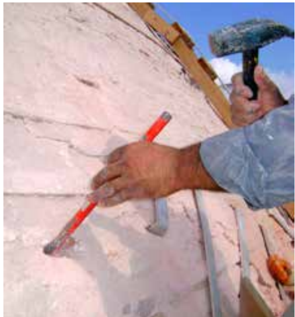
Fotoğraf 5-6-7-8. Merkezi kubbe üzerinde ortaya çıkan çatlaklara yapılan paslanmaz çelik kenet dikiş müdahalesinin aşamaları
