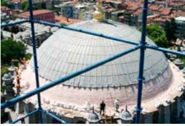
Fotoğraf 1- Çizim 1. Merkezî kubbede kısmî kurşun açılması ve çıkan çatlakların çizime aktarılması
