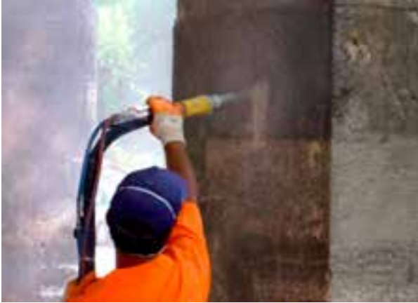
Fotoğraf 40-41. Kumlama çalışması.
