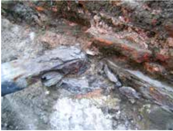
Fotoğraf 10-11. Korozyona uğramış demir hatıl ve hatıl bağlantıları
