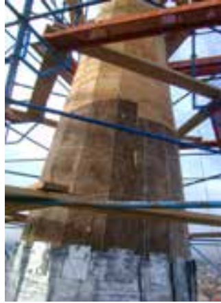
Fotoğraf 80-81. Kaplama tahtası, keçe ve kurşun kaplaması biten minare külahı.
