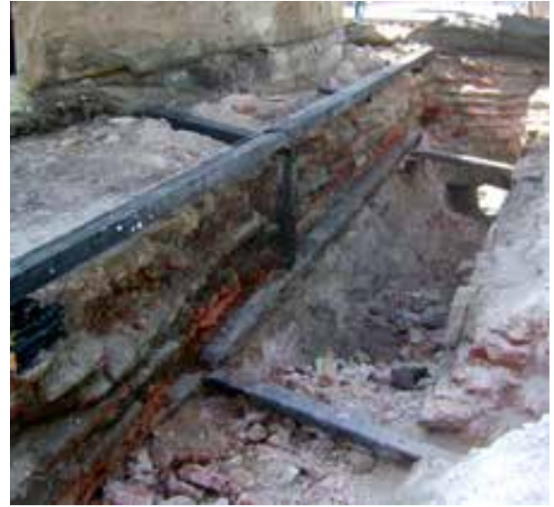
Fotoğraf 9. Su kanalı içinde demir hatıl sistemi
