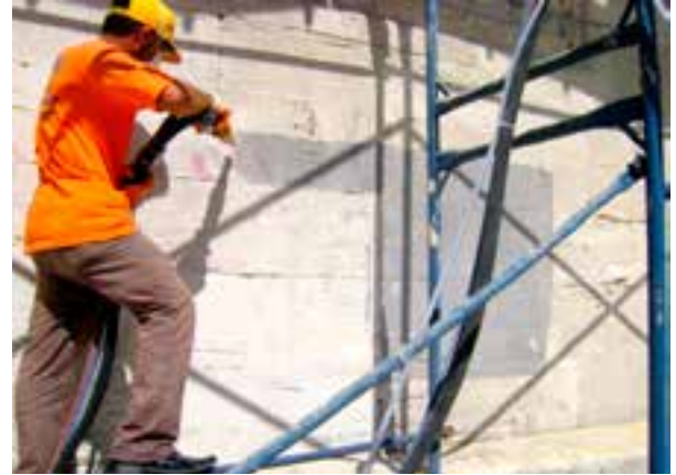
Fotoğraf 40-41. Kumlama çalışması.
