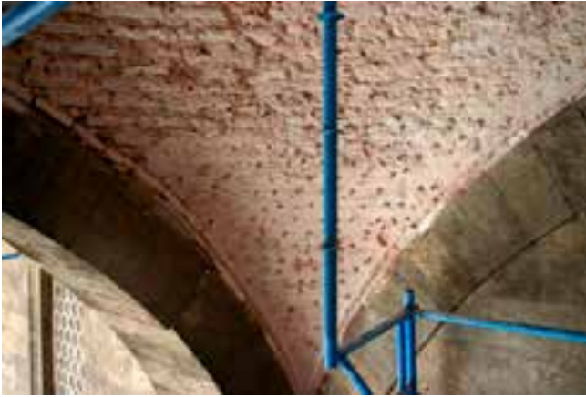
Fotoğraf 86-87. Çimento sıva sökülmesi sonrasında ortaya çıkan paslanmış çiviler ve horasan sıva yapılırken kullanılan paslanmaz çelik çiviler.
