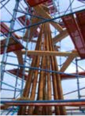
Fotoğraf 76-77. Kurşun kaplaması söküldükten sonra külah strüktürü.
