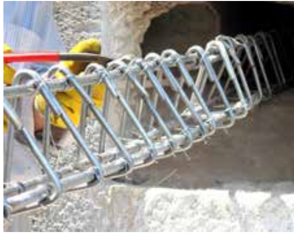
Fotoğraf 33-34. Cephe duvarlarında açılan boşluklar ve paslanmaz çelik gergi.
