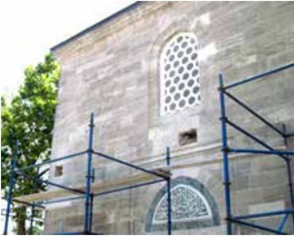
Fotoğraf 33-34. Cephe duvarlarında açılan boşluklar ve paslanmaz çelik gergi.
