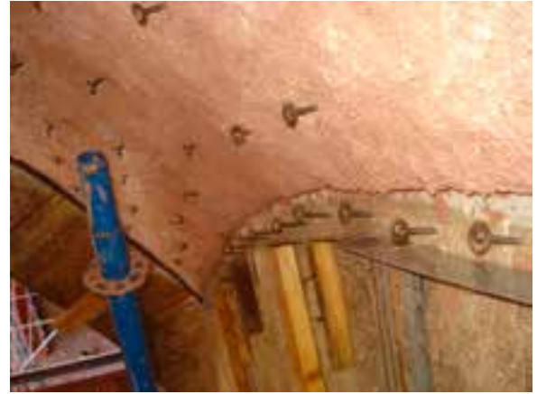
Fotoğraf 86-87. Çimento sıva sökülmesi sonrasında ortaya çıkan paslanmış çiviler ve horasan sıva yapılırken kullanılan paslanmaz çelik çiviler.
