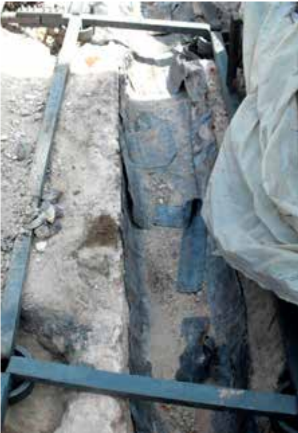
Fotoğraf 16-17. Demir hatlı sistemi güçlendirildikten sonra su kanalının tuğla ile yeniden örülmesi
