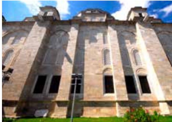
Fotoğraf 45-46. Güneydoğu cephesinin temizlikten önceki ve sonraki durumu.
