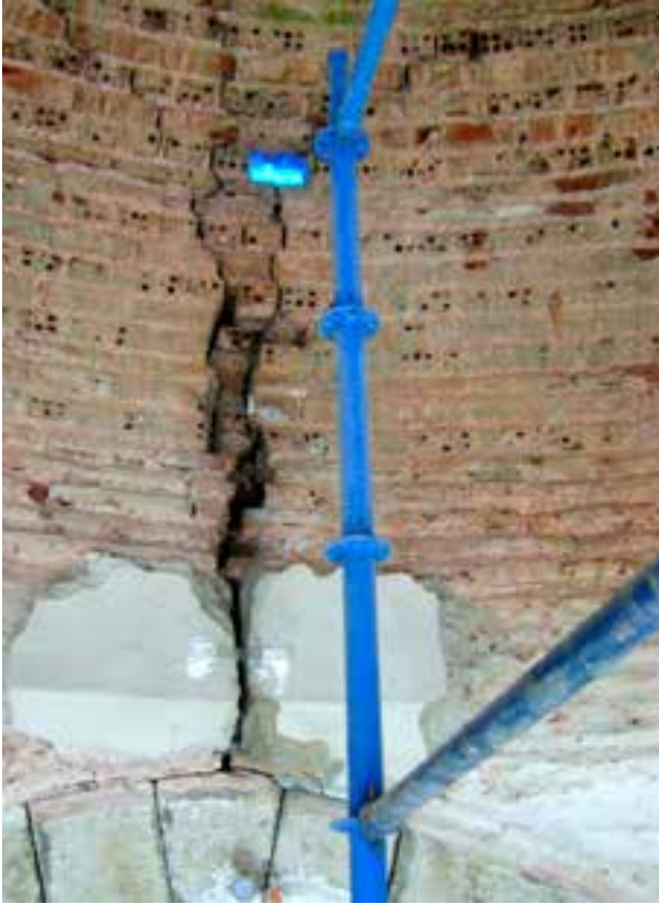
Fotoğraf 2-3. Revaklı avlu kubbesinde bulunan çatlağın tuğla dikiş ile onarılması
