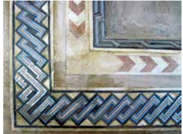
Fotoğraf 59,60. Marküteri tekniği ile yeniden imal edilen kepenk.
