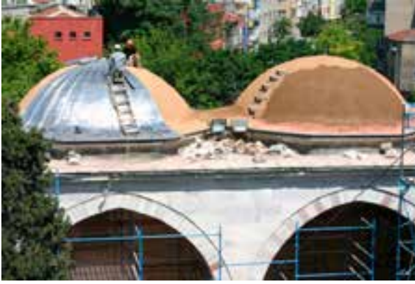
Fotoğraf 38-39. Revaklı avlu kubbelerinde kurşun örtü çalışmaları.
