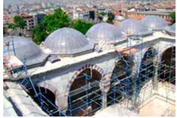
Fotoğraf 38-39. Revaklı avlu kubbelerinde kurşun örtü çalışmaları.
