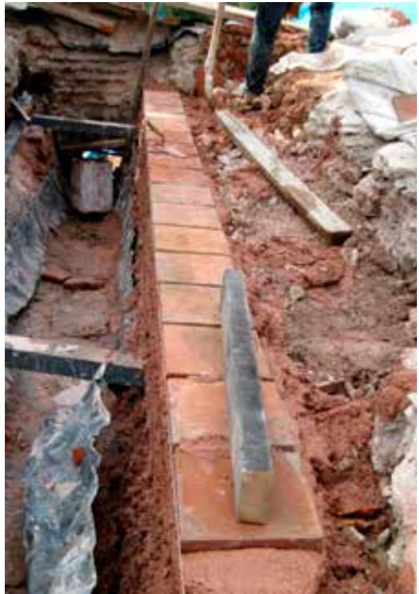
Fotoğraf 16-17. Demir hatlı sistemi güçlendirildikten sonra su kanalının tuğla ile yeniden örülmesi
