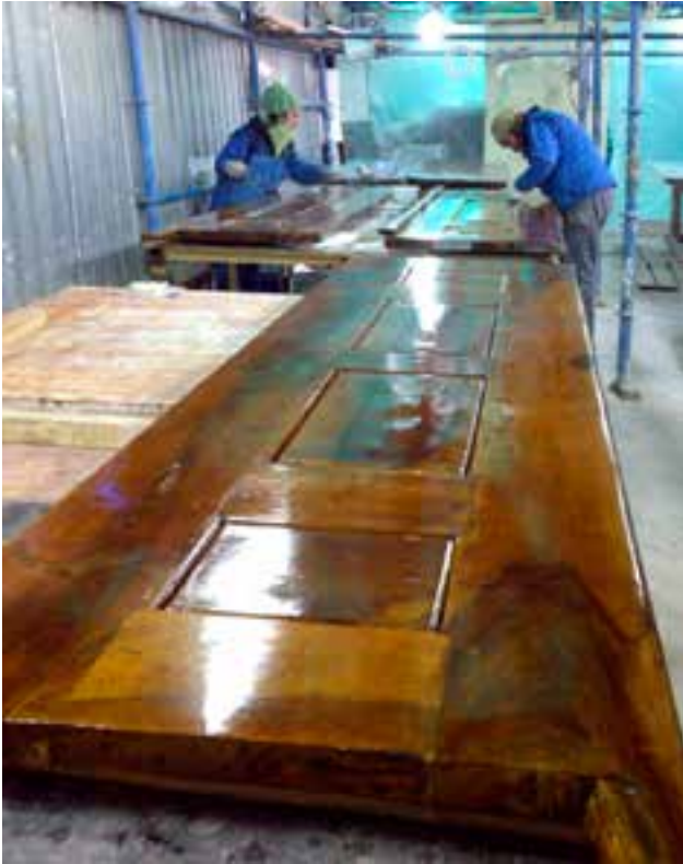
Fotoğraf 55,56. Ahşap kepenkler üzerinde gomalak cila uygulaması.
