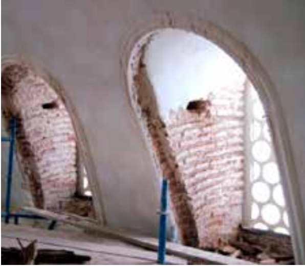
Fotoğraf 22-23-24-25. Pencere içlerinde kesilmiş bulunan ahşap hatıllar.
