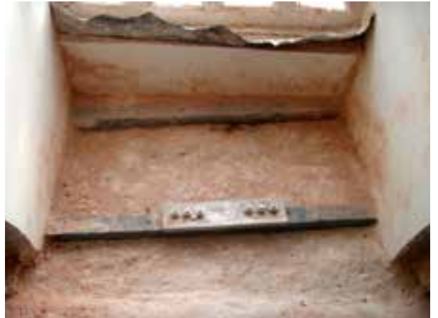
Fotoğraf 18-19-20-21. Pencere tabanlarındaki demir hatıllar
