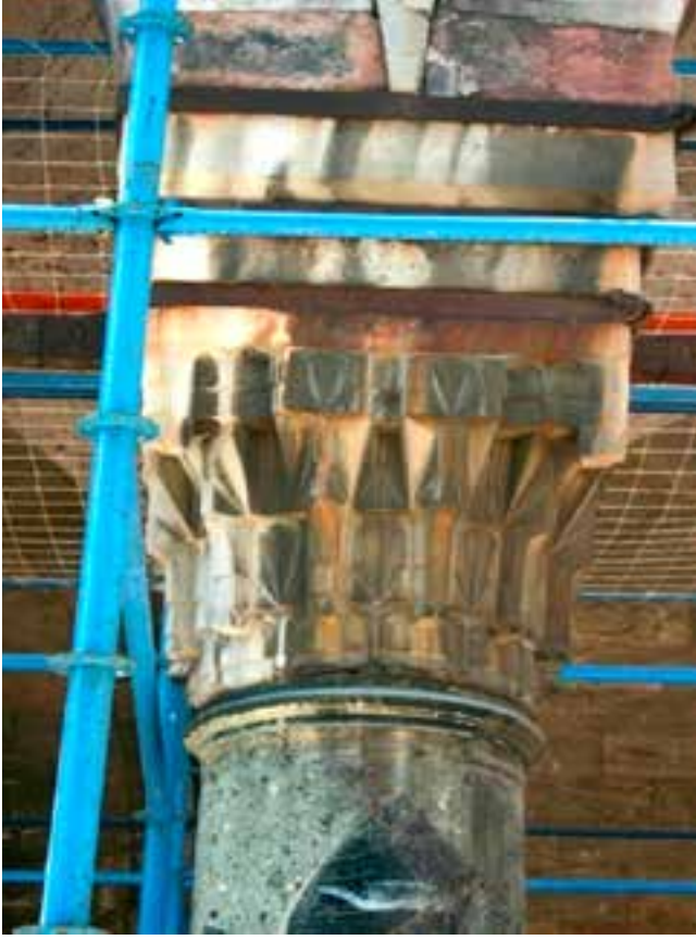
Fotoğraf 47-48-49. Revaklı avlu mermer sütun başlıklarında AB 57 ile temizlik öncesi ve sonrası.
