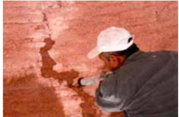
Fotoğraf 4. Kılcal çatlaklara enjeksiyon ile müdahale edilmesi
