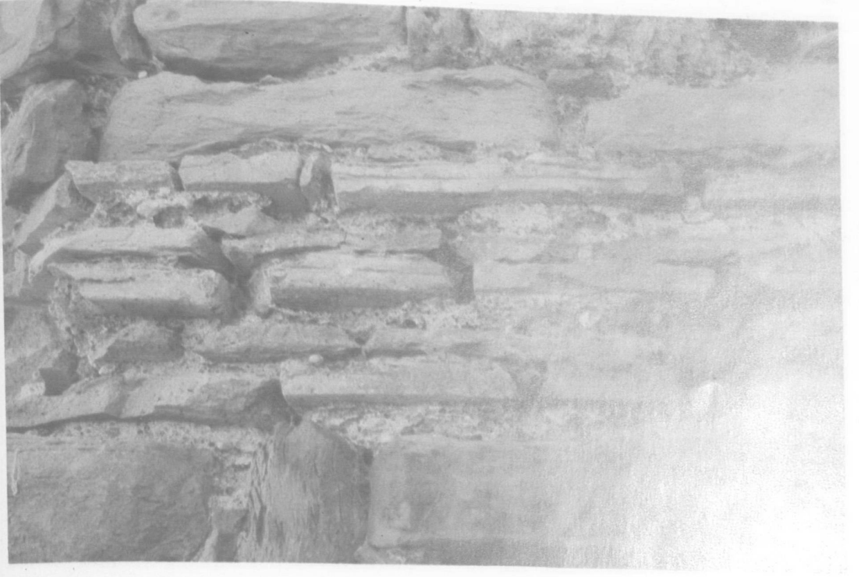
6. Altınyazı surları, güneydeki kule
