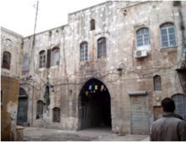
Şekil 16. Avlunun güney cephesinin genel görünümü, 2011 Fig 16. The southern internal façade, general view, 2011
