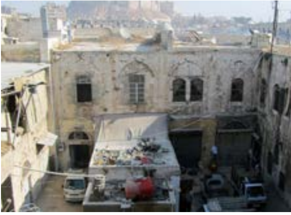
Şekil 5. Avlunun doğu cephesi; kapatılmış revakların izleri görülmektedir, 2011 Fig 5. The eastern internal façade, the traces of closed arcades, 2011
