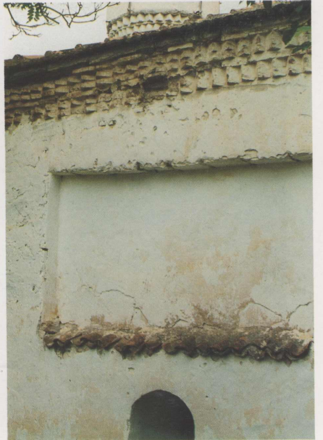
Resim 3: Camide uygulanan kirpi saçak sistemi.
