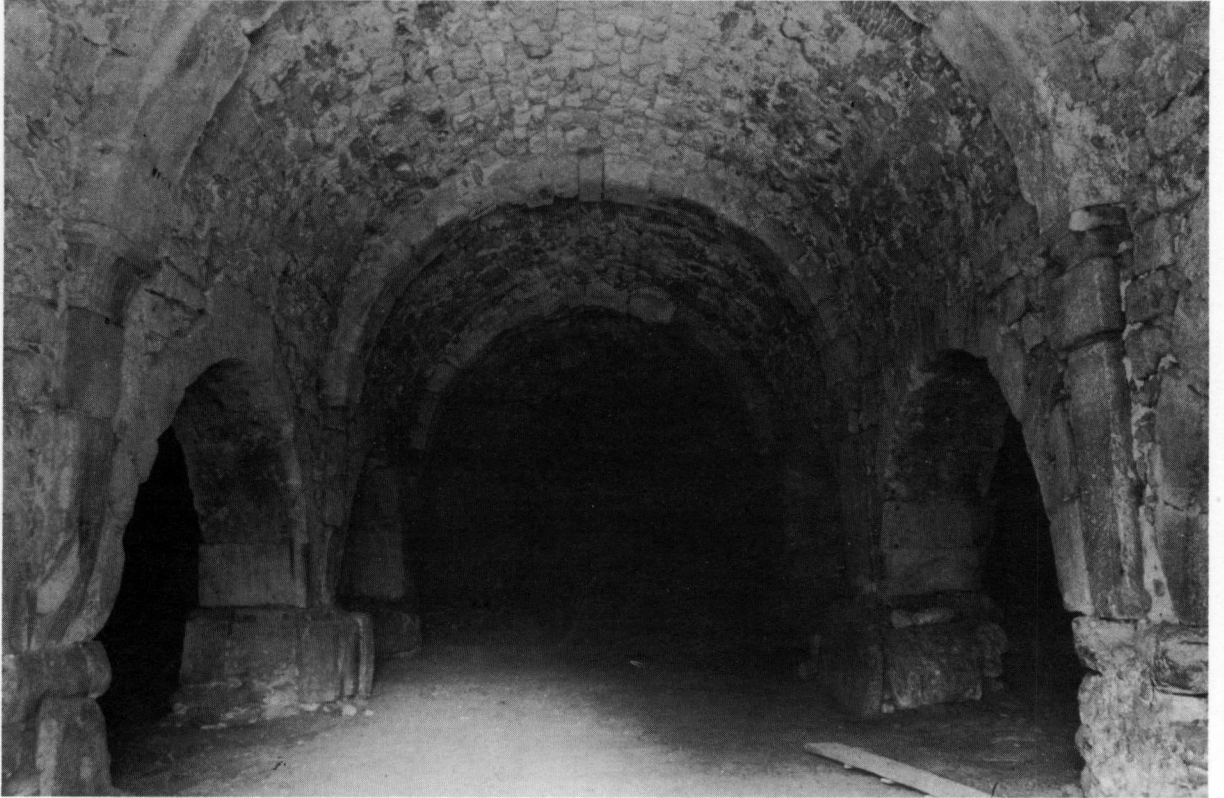
Resim 12: Kervansarayın içten görünüşü.
