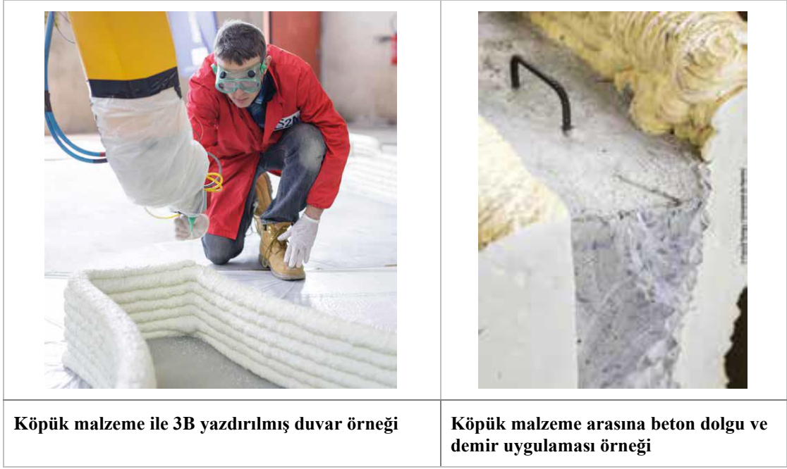
Şekil 2. 16 Köpük malzeme ile 3B yazdırılmış konut örneği (Laboux, Lineatte, Coiffier, & Toms, 2017) (BATIPRINT3D, 2021).
