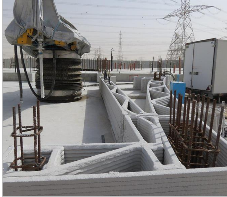
Şekil 2. 15 Betonarme karkas yapıda 3B yazdırılmış yapı örneği (Apis Cor, 2019)
