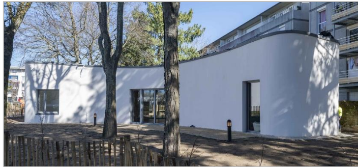
Şekil 2. 17 BATIPRINT 3D tarafından Nantes'te üretilen yapı (BATIPRINT3D, 2021).
