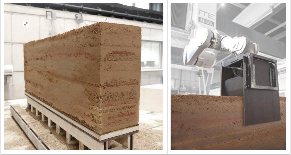
Şekil 2. 19 3B yazıcı ile sıkıştırılmış toprak üretimi (Kloft, Gosslar, Barba, & Pacillo, 2021)
