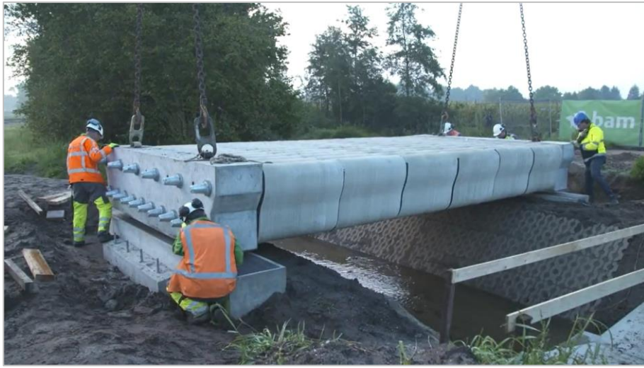
Şekil 2. 5 BAM 2019 3B yazıcıdan köprü üretimi çalışmaları (BAM, 2021).
