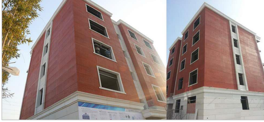
Şekil 2. 21 3B yazıcı ile üretilmiş beş katlı yapı (Winsun, 2015)
