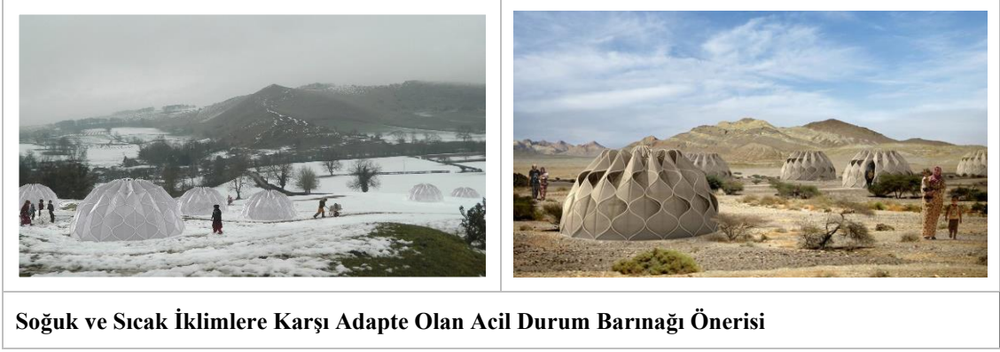
Şekil 1. 13 Seikaly'nin katlanabilir kumaştan üretilen yapı kabuğu önerisi (Seikaly, 2013).
