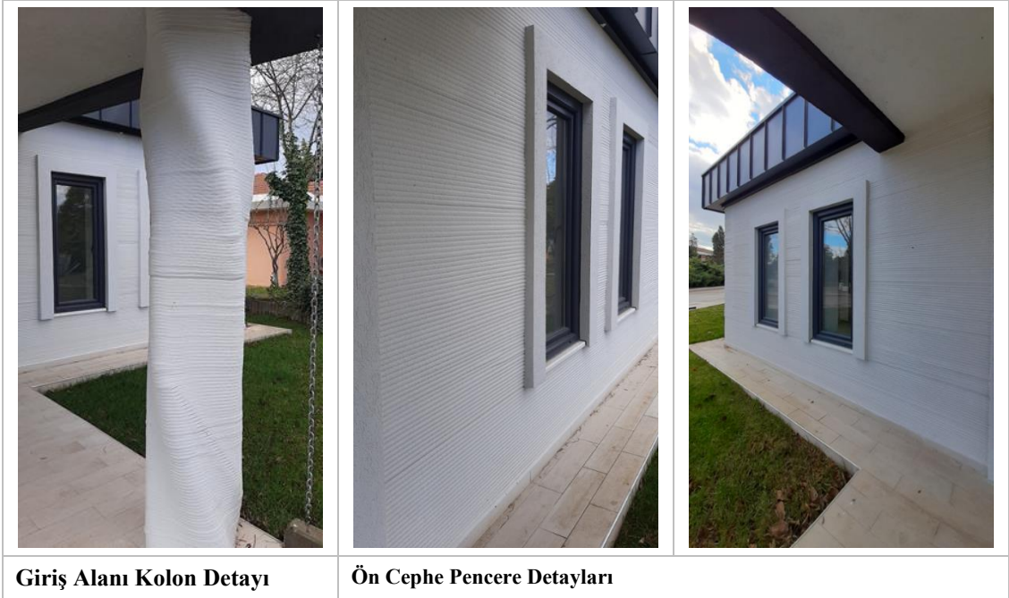
Şekil 3. 2 İSTON Tuzla fabrikasında üretilen yapının dış cephesinden fotoğraflar.
