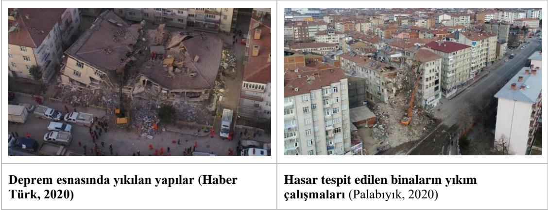
Şekil 1. 27 2020 Elazığ depremi sonrası yıkılan yapılar.
