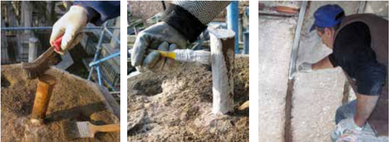
Fotoğraf 23-24-25 Korozyonun temizlenmesi ve koruyucu sürülmesi
