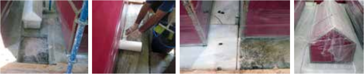
Fotoğraf 24-25-26-27 Mermer döşemenin ab57 ile temizlenmesi
