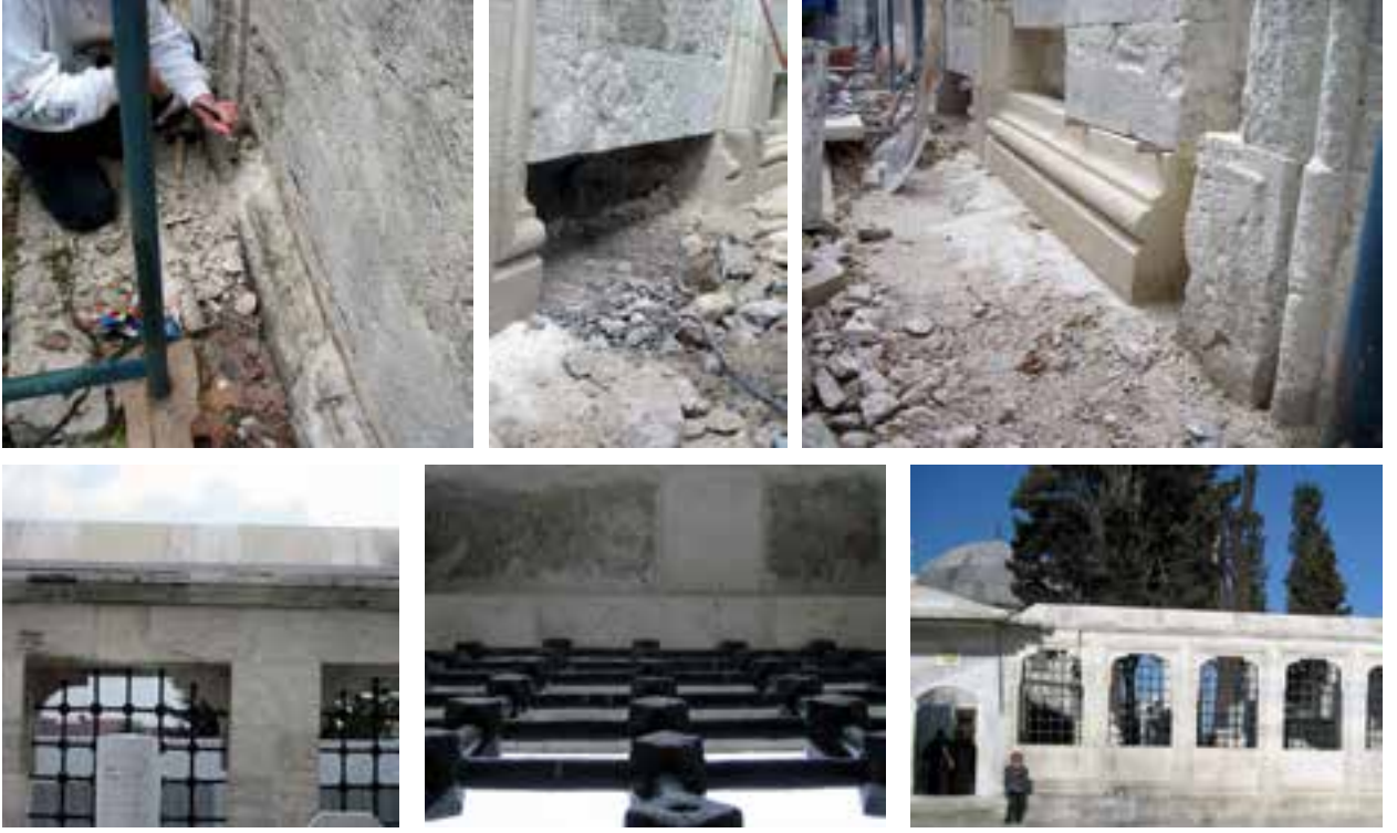
Fotoğraf 24-25-26-27-28-29 Taş yüzeylerde yapılan onarım çalışmaları
