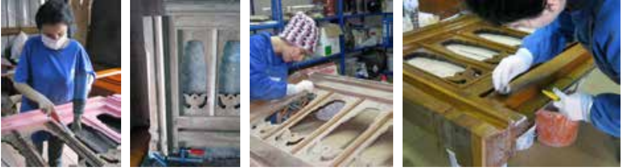
Fotoğraf 34-35-36-37 Korkuluklarda boya sökümü, parça değişimi ve gomalak cila yapılması
