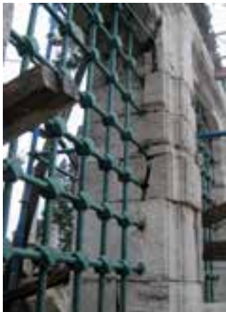
Fotoğraf 15-16 Taşı patlatarak duvar dokusuna zarar veren korozyona uğramış lokma demir parmaklıklar
