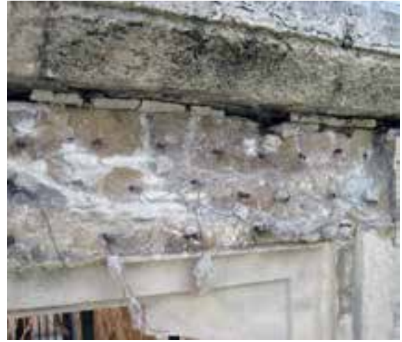
Fotoğraf 19-20 Kenet ve zivanalarda meydana gelen korozyon
