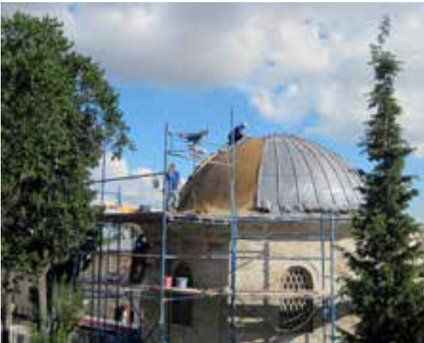
Fotoğraf 6 Kurşun örtü değiştirilirken
