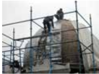
Fotoğraf 9-10-11-12 Hasarlı kurşun örtü sistemi, çalışma esnası ve restorasyon sonrası
