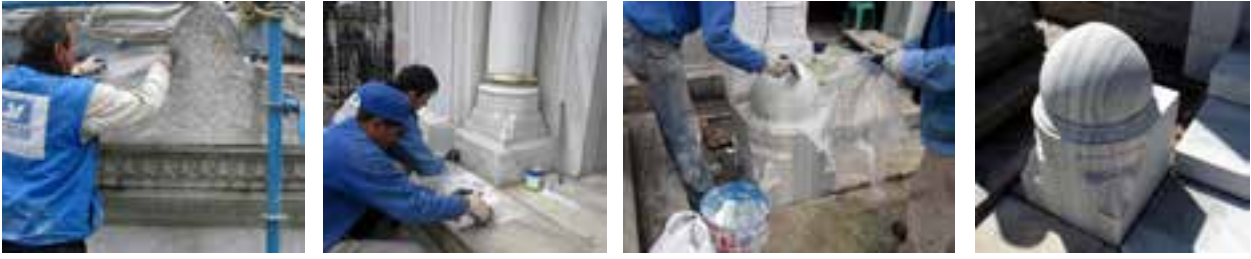
Fotoğraf 16-17-18-19 Mermer yüzeylerde AB57 ile temizlik yapılması
