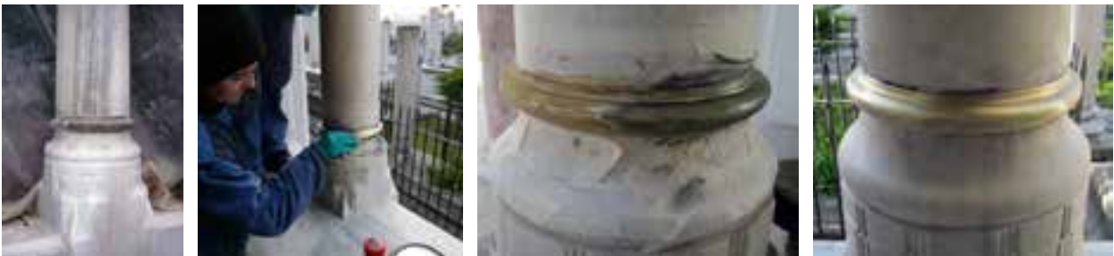
Fotoğraf 26-27-28-29 Pirinç bileziklerin temizlenmesi
