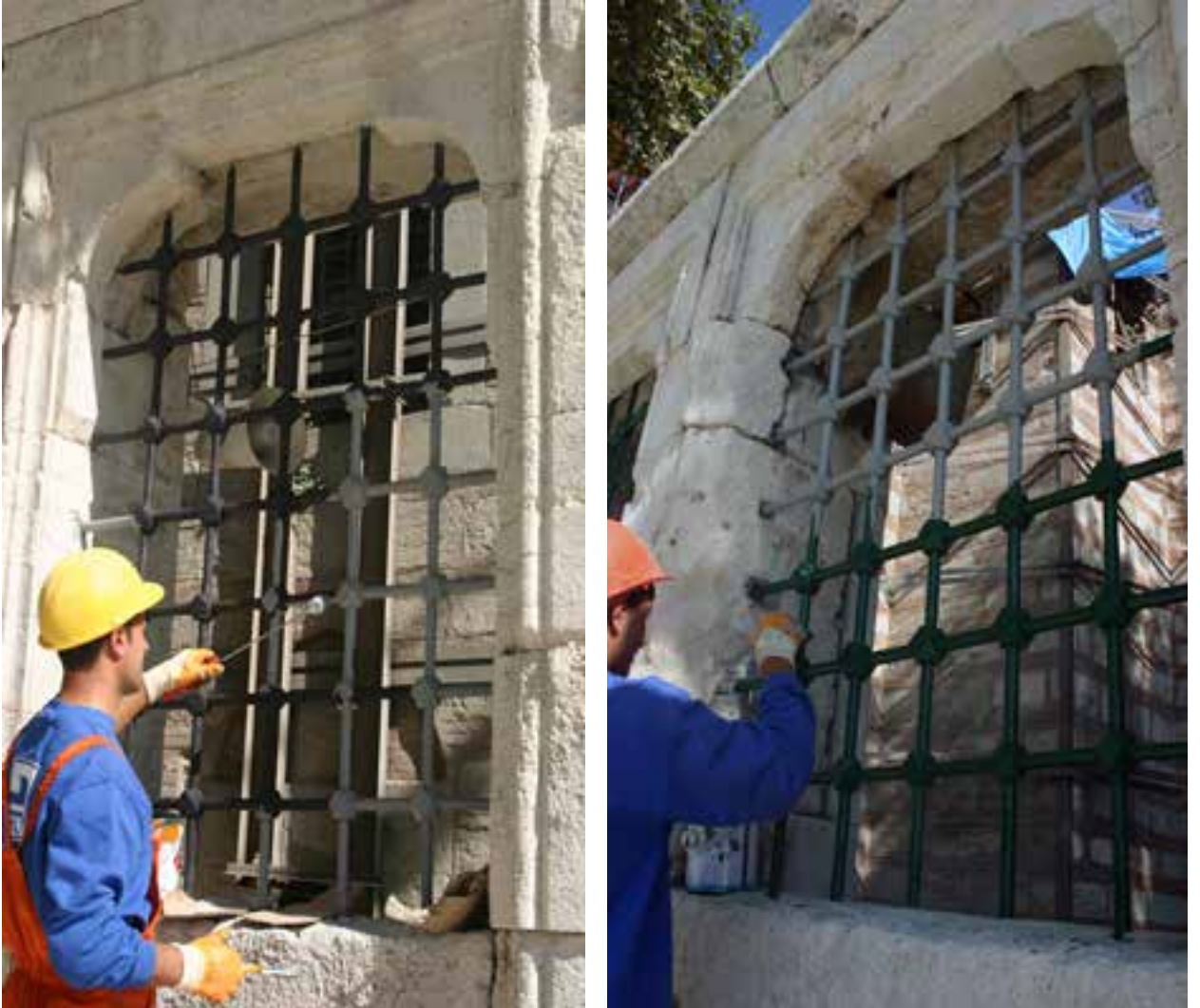
Fotoğraf 30-31 Parmaklıklara koruyucu sürülmesi
