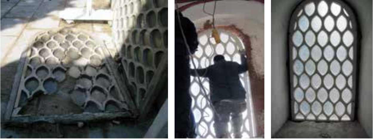
Fotoğraf 28-29-30 Hasarlı olan dışlık restorasyon öncesi ve sonrası
