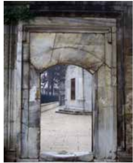
Fotoğraf 21-22-23 Güneybatı ve kuzeydoğu hazire duvarlarında bulunan kapıların mermer söve, silme ve kemerleri
