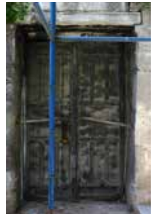
Fotoğraf 17-18 Korozyona uğrayan demir kapı ve aksesuarları
