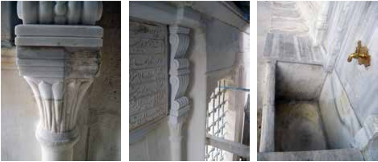
Fotoğraf 6-7-8 Mermer yüzeylerde yapılan onarım çalışmaları
