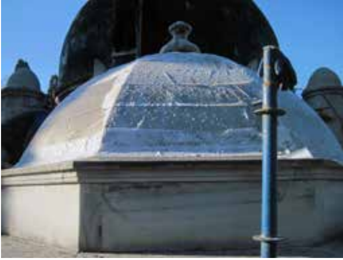
Fotoğraf 3-4 Mermer kubbe ab57 ile temizlik yapılırken
