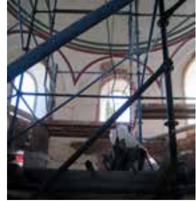
Fotoğraf 37-38 Çimento sıvalar söküldükten sonra
