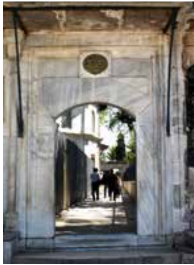
Fotoğraf 21-22-23 Güneybatı ve kuzeydoğu hazire duvarlarında bulunan kapıların mermer söve, silme ve kemerleri
