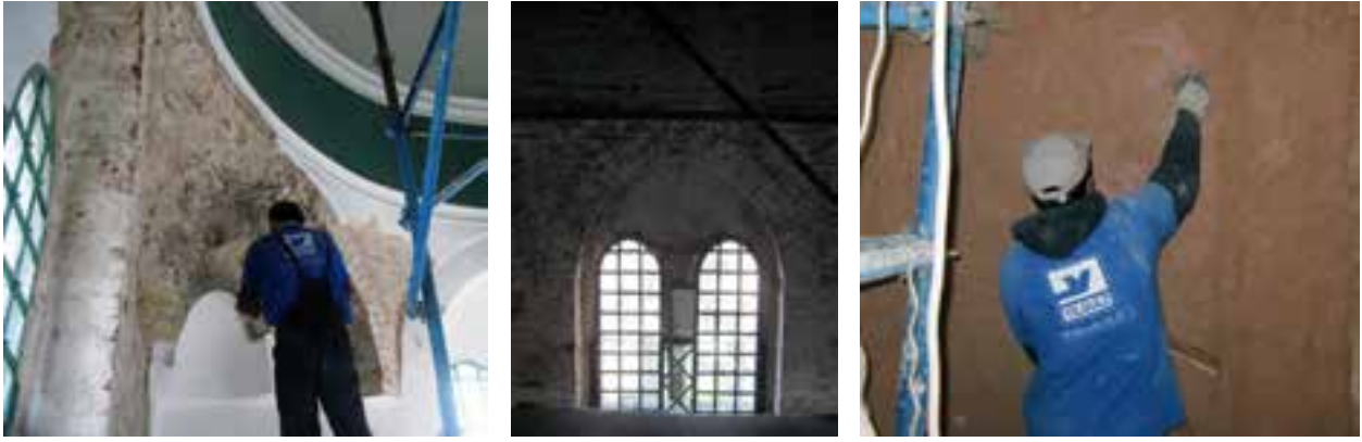
Fotoğraf 39-40-41 Çimento sıva sökülmesi ve Horasan sıvanın yapılması
