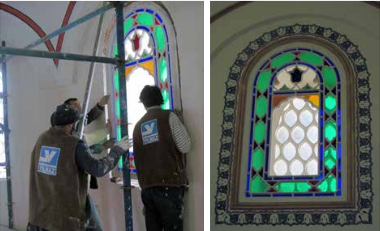
Fotoğraf 31-32 İçlik yerine takılması ve restorasyon sonrası
