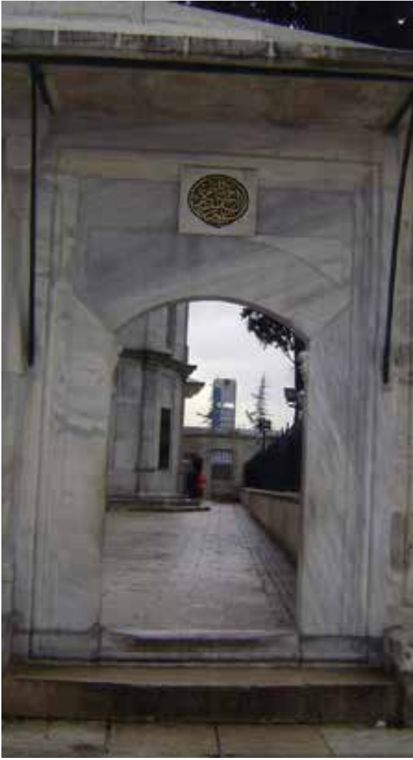
Fotoğraf 37 Temizlenen mermer yüzeyler
