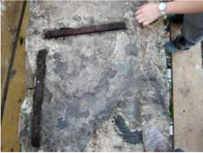
Fotoğraf 19-20 Kenet ve zivanalarda meydana gelen korozyon
