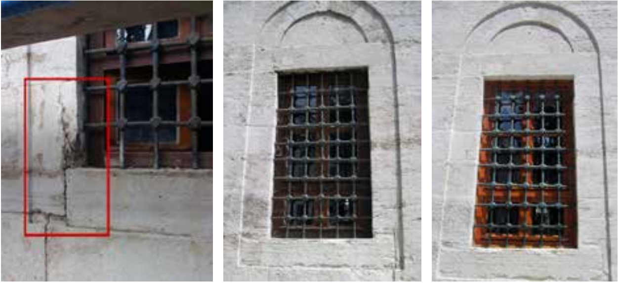
Fotoğraf 33-34-35 Taşı patlayan parmaklığın restorasyon öncesi ve restorasyon sonrası
