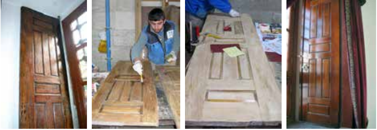
Fotoğraf 12-13-14-15 Kepenk restorasyon öncesi, onarım çalışmaları sırasında ve restorasyon sonrası
