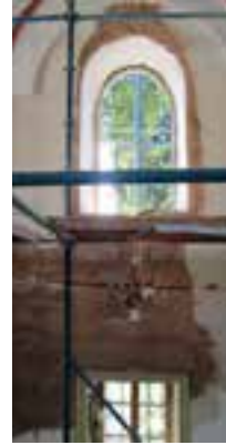
Fotoğraf 37-38 Çimento sıvalar söküldükten sonra
