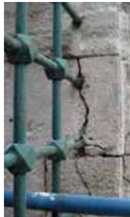
Fotoğraf 15-16 Taşı patlatarak duvar dokusuna zarar veren korozyona uğramış lokma demir parmaklıklar
