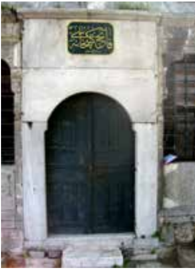
Fotoğraf 21-22-23 Güneybatı ve kuzeydoğu hazire duvarlarında bulunan kapıların mermer söve, silme ve kemerleri
