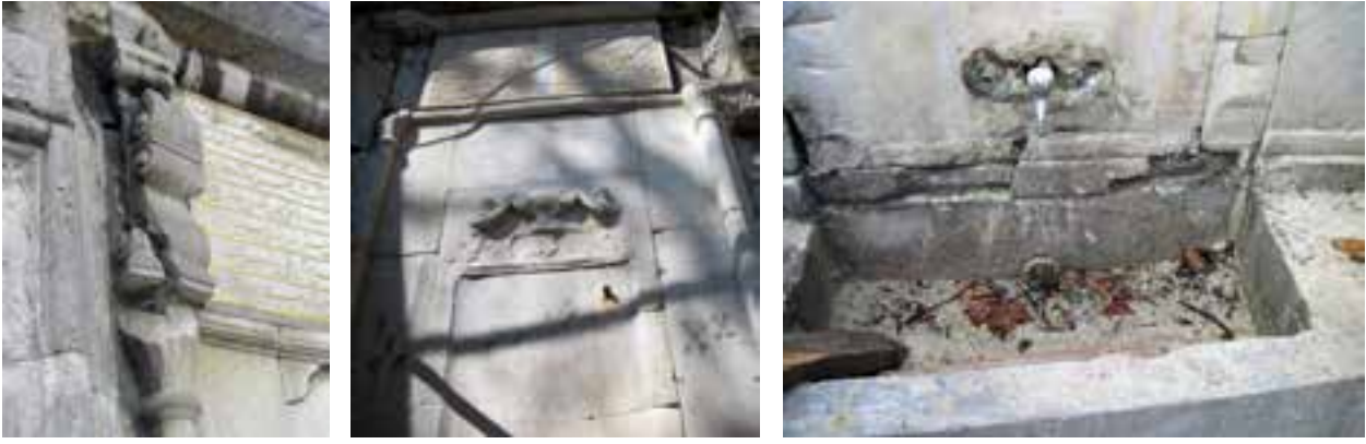
Fotoğraf 3-4-5 Mermer yüzeylerde görülen bozulmalar
