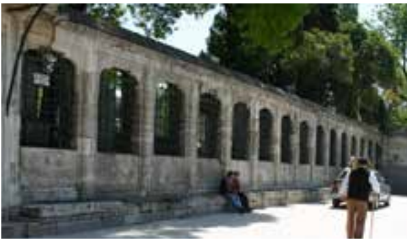
Fotoğraf 3 Güneybatı hazire duvarı çorbacı kapısı tarafı
