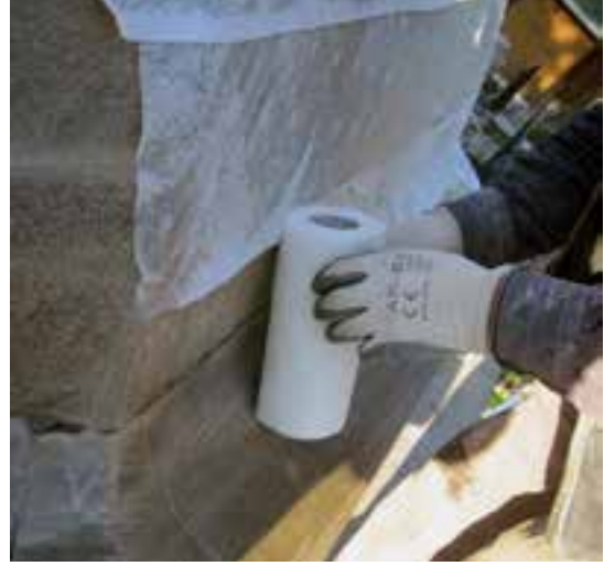
Fotoğraf 3-4 Mermer kubbe ab57 ile temizlik yapılırken
