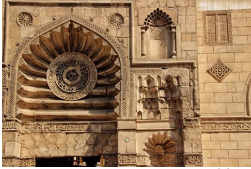
Görsel 3.16. Al-Akmar Cami cephesi 262
