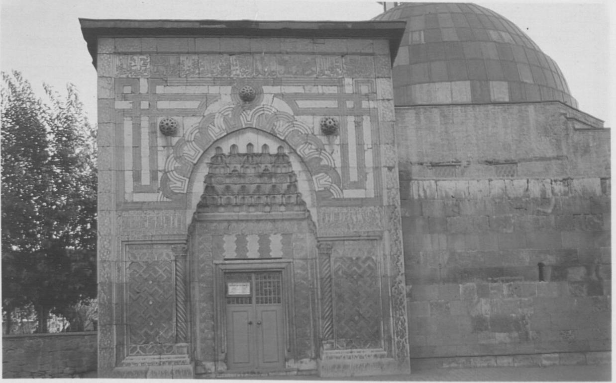
Res. 11: Konya Karatay Medresesi, doğu cephe (1994)
