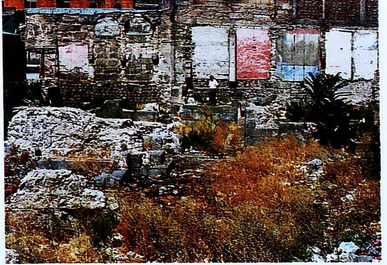
Res. 1: Pervane Bey Medresesi kalıntıları genel görünüş.
