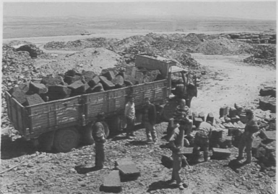
Res. 23: Karhane Taş Ocağında taşın yüklenmesi.
