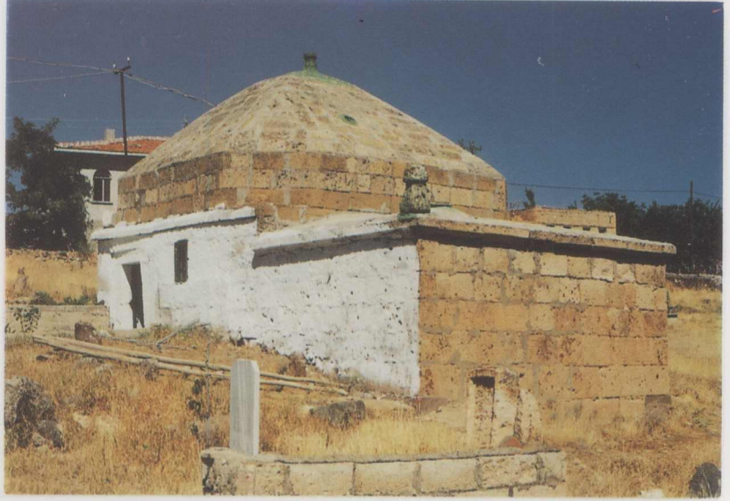
Res. 1: Şeyh İbrahim Kümbeti batı ve güney cephesi
