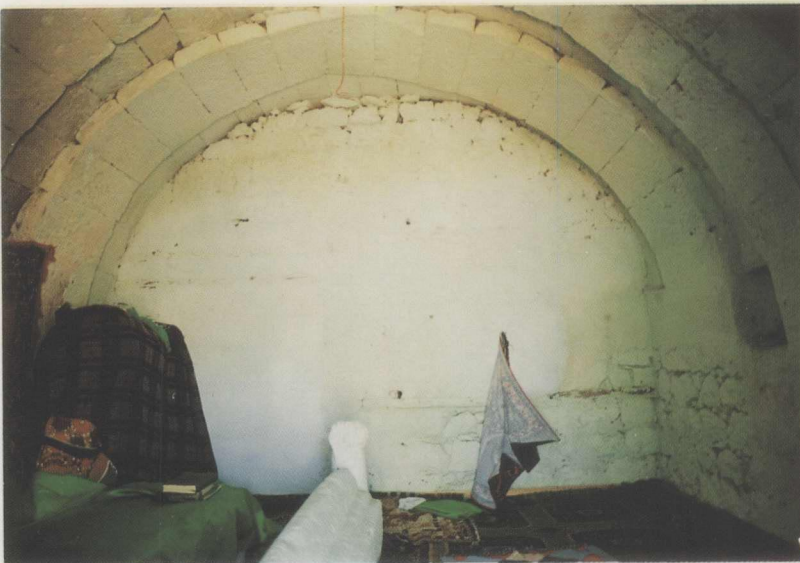
Res. 12: Türbe iç mekan
