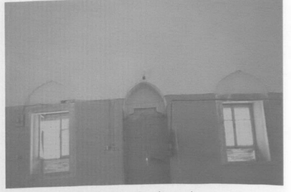
Res.18: İç Mekandan, kuzey duvarı.
