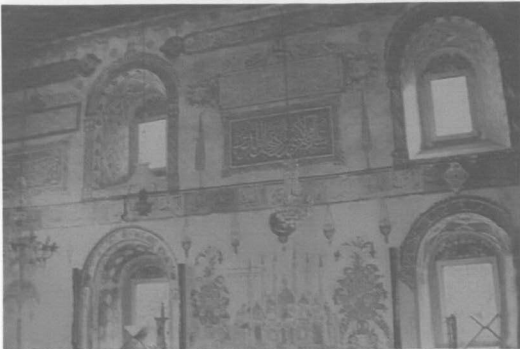
Res.9: Harim batı duvarı ve süslemesi.
