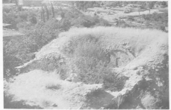
Lev. 17: Karabey Hamamı, üstten görünüm.
