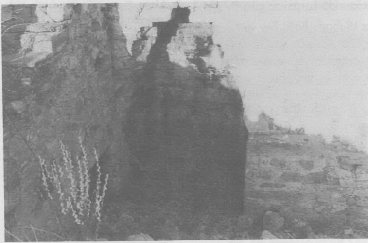
Lev. 8: Balta Bey Hamamı, batı cephe ayrıntı.
