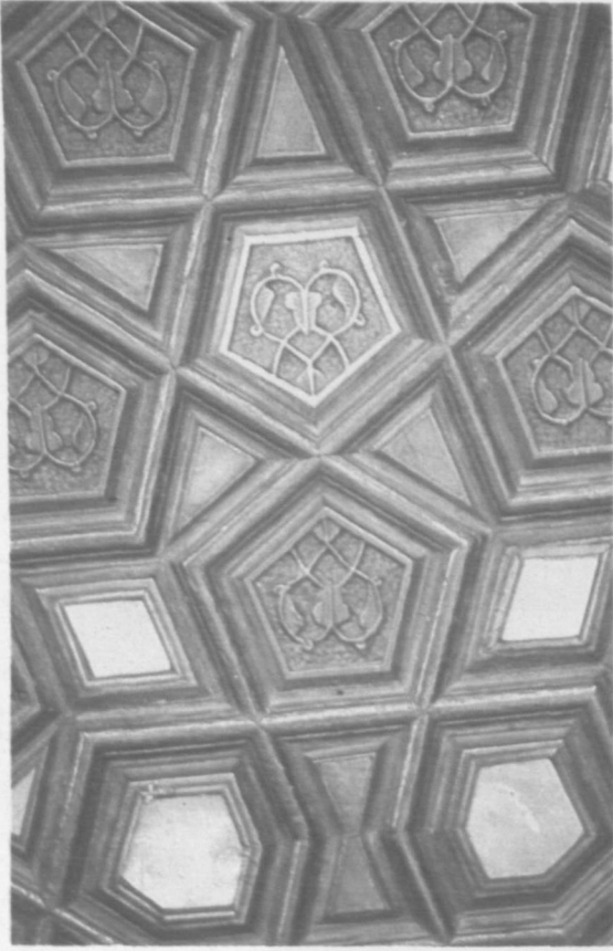
21- Kânûnî Türbesi, kapıdan detay
