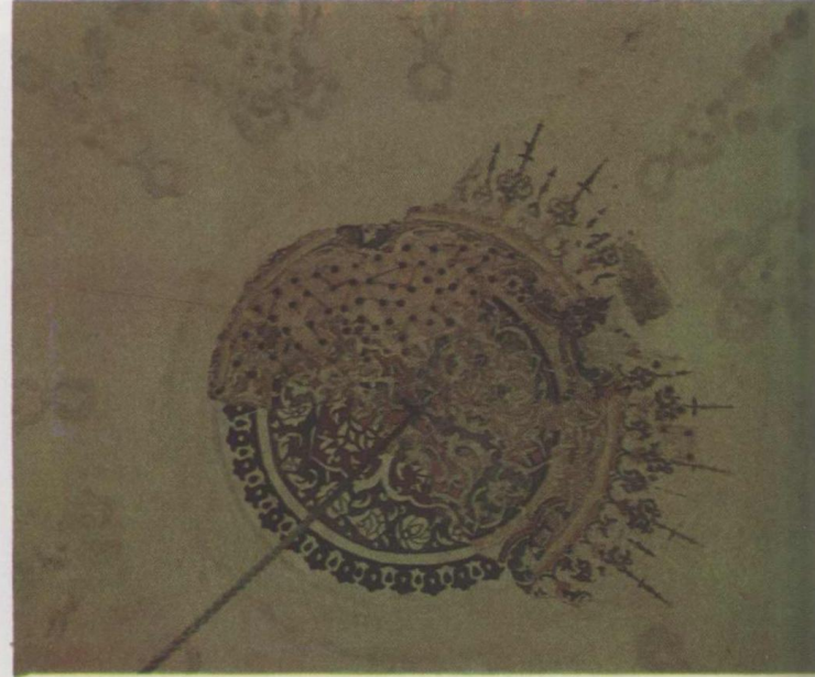
Resim12: Üsküdar Atik Valide Camii'nin giriş sağ mahfel orta kubbe göbeğinde bulunan orijinal tezyinatının raspa ile açılmış görünüşü.
