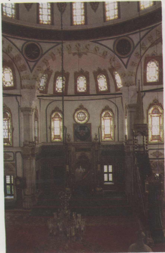
Resim2: Beylerbeyi Hamid-i Evvel Camii'nin mihrab cephesinin onarım sonrası görünüşü.
