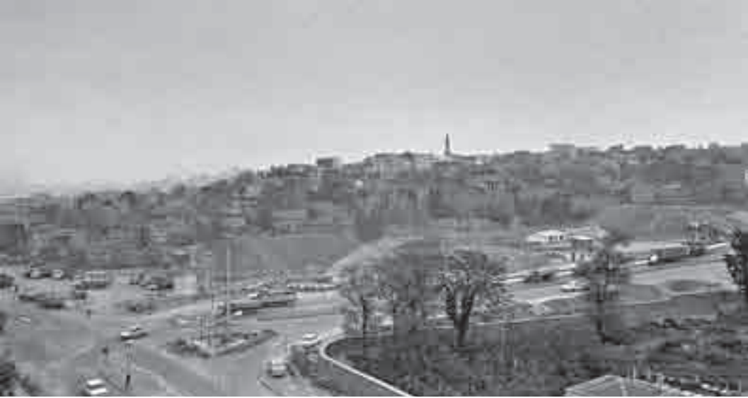
Resim 1. Ayvansaray surlarının Eyüp yönünden görünümü, yol yapım çalışmaları (Vibma*)
