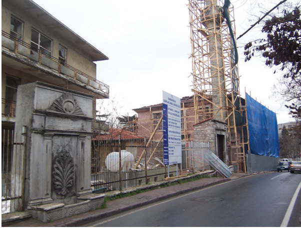
Resim 7. Bezm-i Alem Vakıf Guraba Külliyesi 'nde 2007'de çeşme ve cami onarımı. (H.Turhan Arş.)
