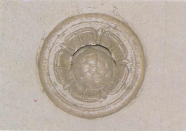
Resim 15: Balıkesir Zağnospaşa Camii mimberi üzerindeki kabaranın temizlenmiş hali.
