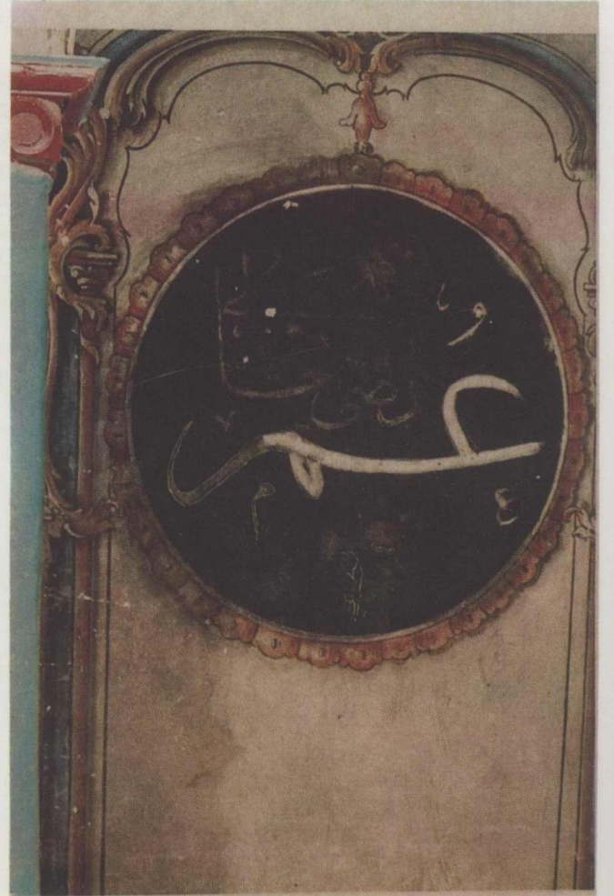
Resim 6: Yozgat Başçavuşoğlu Camii'ndeki kadınlar mahvelinin balkon kısmında yarı yarıya temizlenmiş bir yüzey.
