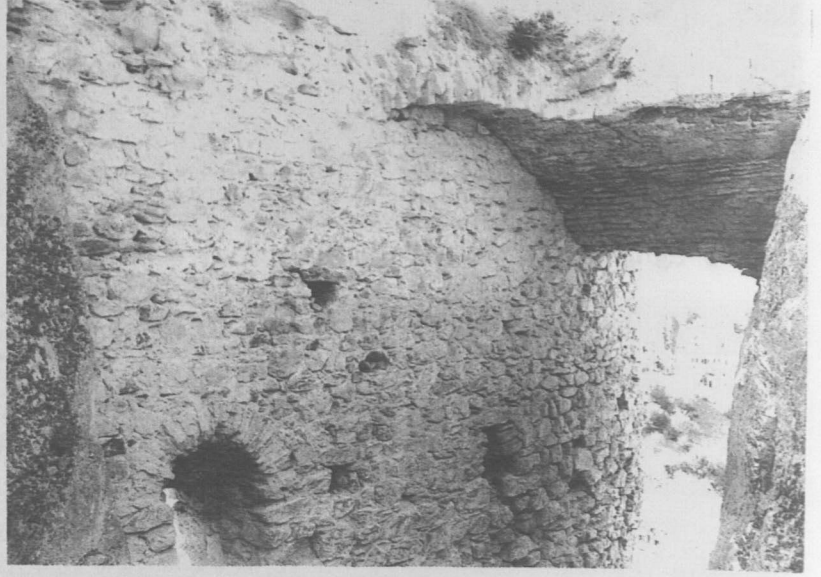
Resim 6: Kale girişinde örtlü sistemi.
