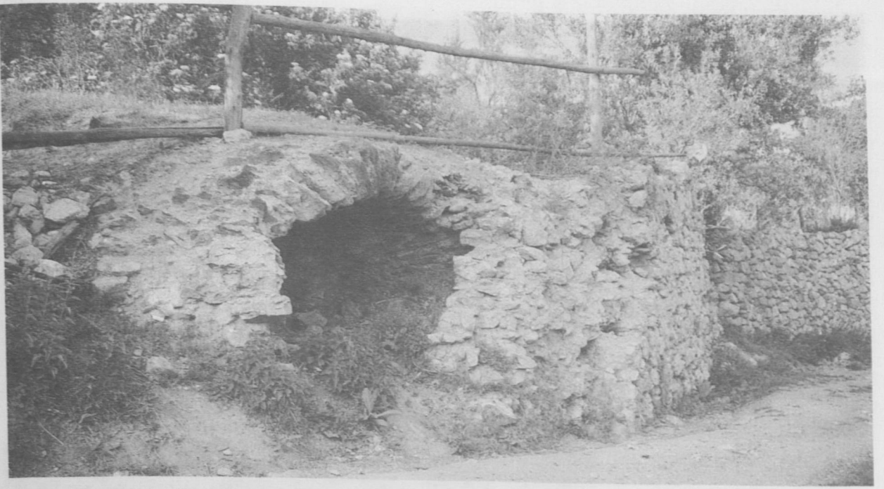
Resim 19: Eğrigöz Köyü Hamamı.
