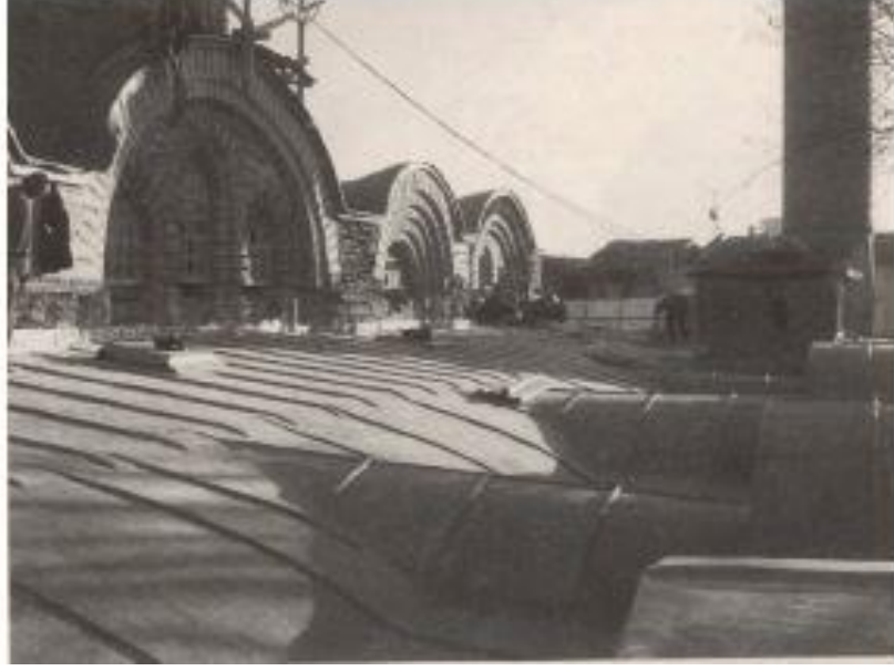
Şekil 4.2. Dış narteks çatısına kurşun döşenmesi
