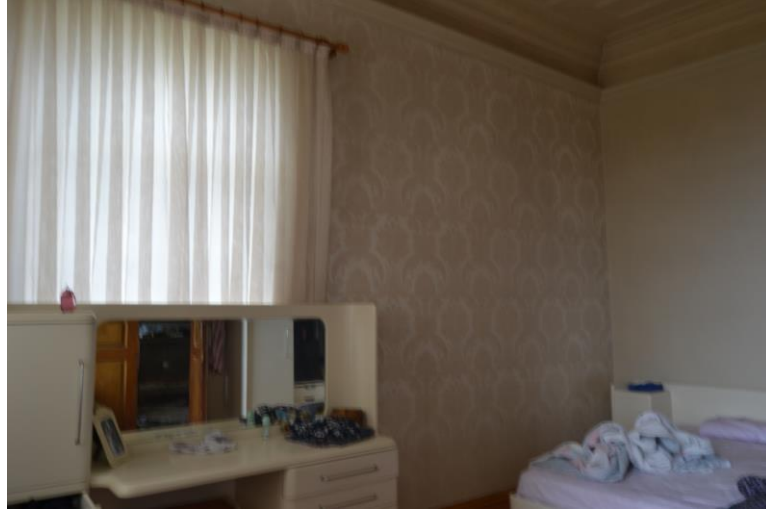
Şekil B. 50. 1-01 numaralı odanın doğu duvarı (2019)
