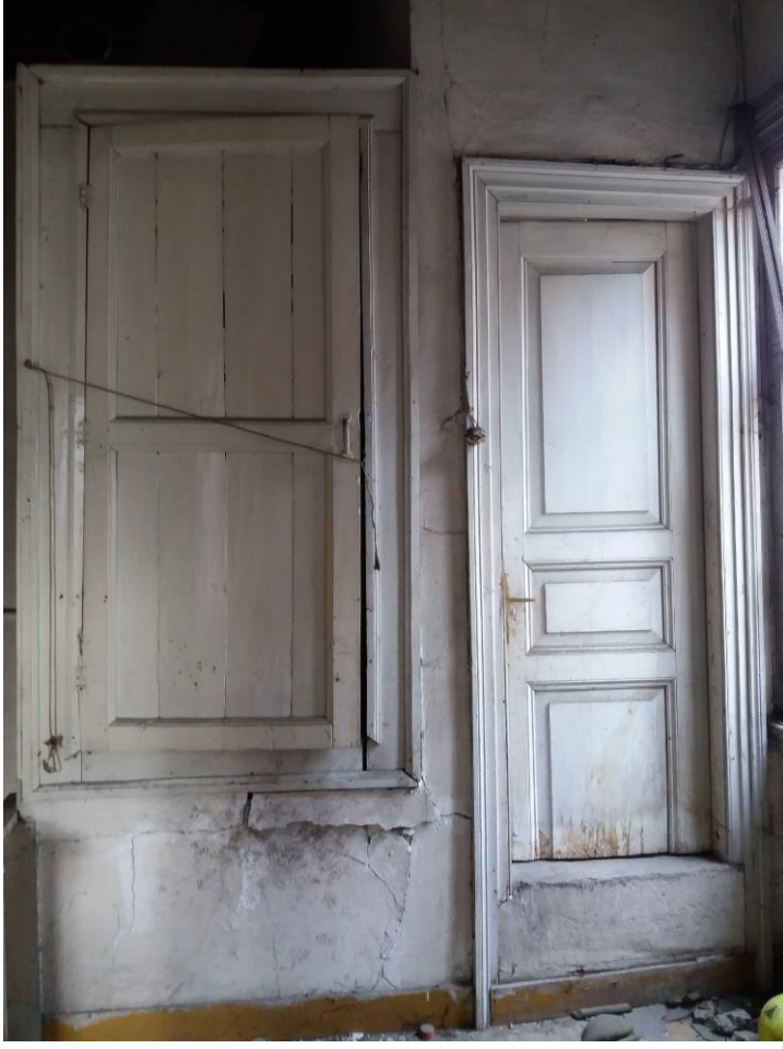
Şekil B. 105. Ek yapı 1-01 numaralı holün doğu duvarı (2019)
