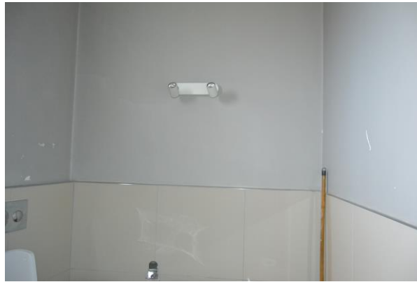
Şekil B. 58. 1-04 numaralı banyonun güney duvarı
