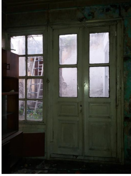
Şekil B. 96. Z-03 numaralı odanın güney duvarı (2019)
