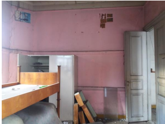
Şekil B. 117. 1-03 numaralı odanın kuzey duvarı (2019)
