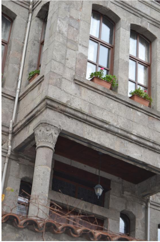
Şekil 5.30. Kuzey cephesinde bulunan çıkma, sütun başlığı basık kemerli pencereler, taş kar silmesi ve taş söveler (2019)
