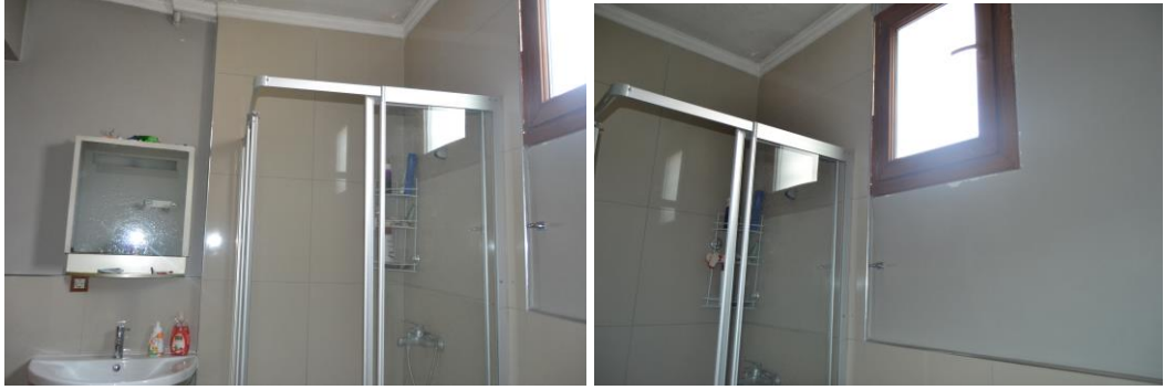
Şekil B. 56. 1-04 numaralı banyonun doğu duvarında bulunan pencere (2019)
