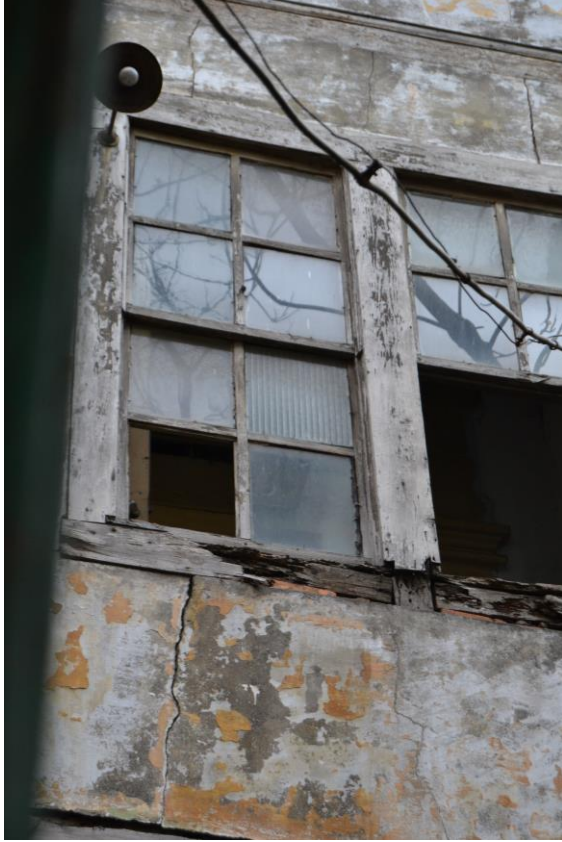
Şekil 5.35. Yapıda bulunan ahşap giyotin pencereler (2019)
