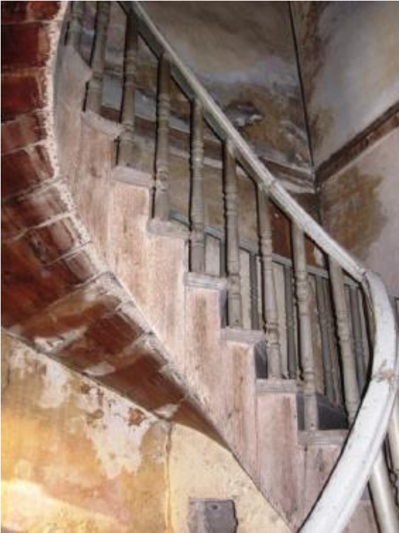
Şekil 5.39. Yapıya ait iç mekan merdivenleri ( Turhan, 2013, s.70)
