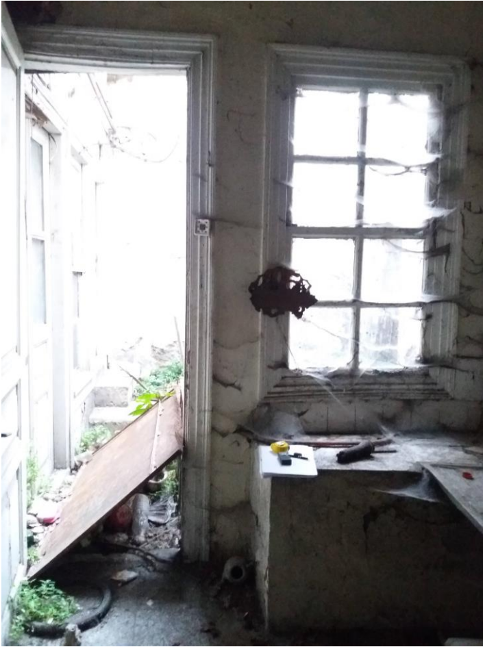
Şekil B. 85. Ek yapı Z-01 numaralı mutfağın doğu duvarı (2019)
