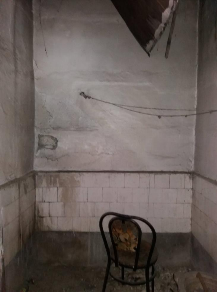
Şekil B. 100. Z-04 numaralı tuvaletin kuzey duvarı (2019)
