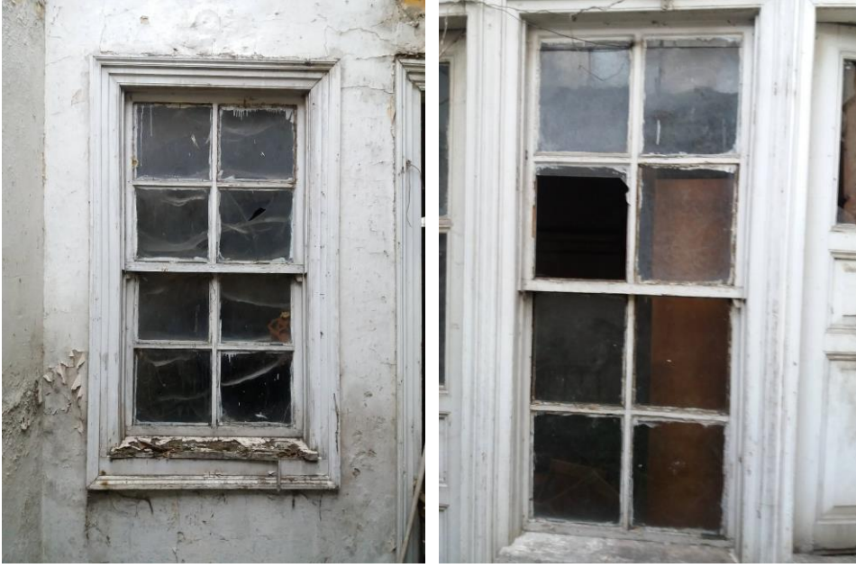
Şekil B. 80. Ek yapıda bulunan giyotin pencere detayı (2019)
