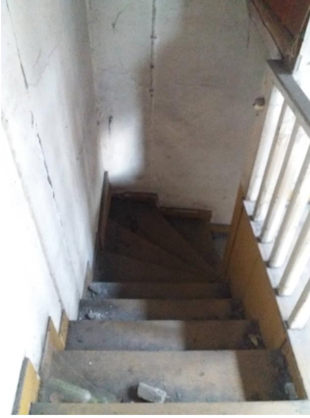
Şekil B. 103. Ek binada bulunan zemin katı birinci kata bağlayan ahşap merdiven (2019)
