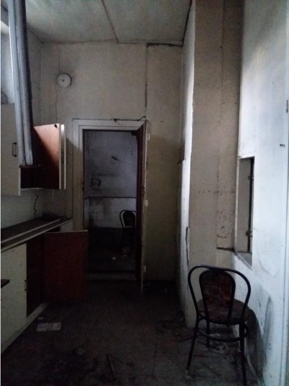
Şekil B. 90. Z-02 numaralı holün kuzey duvarı (2019)
