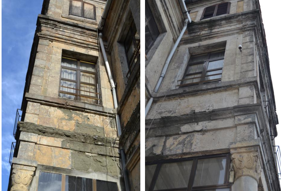
Şekil B. 13. Kurşunoğlu Konağının batı ve doğu cepheleri (2019)
