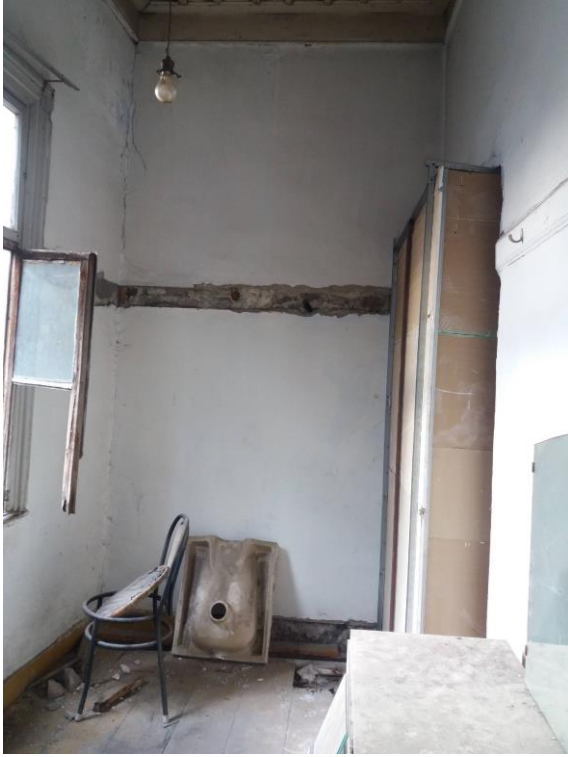
Şekil B. 110. 1-02 numaralı odanın kuzey duvarı (2019)
