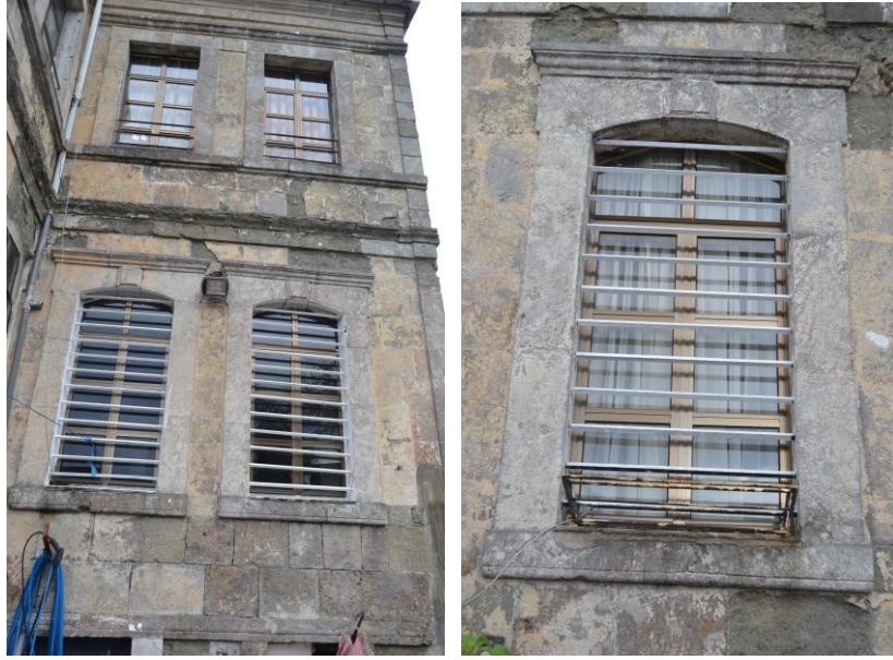
Şekil B. 17. Kurşunoğlu Konağı'nın kuzey cephesinde yer alan basık kemerli pencereler, pencerelerin etrafında yer alan taş söveler ve kilit taşı (2019)
