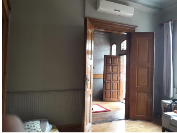
Şekil B. 24. Z-01 numaralı odanın batı duvarı (2019)
