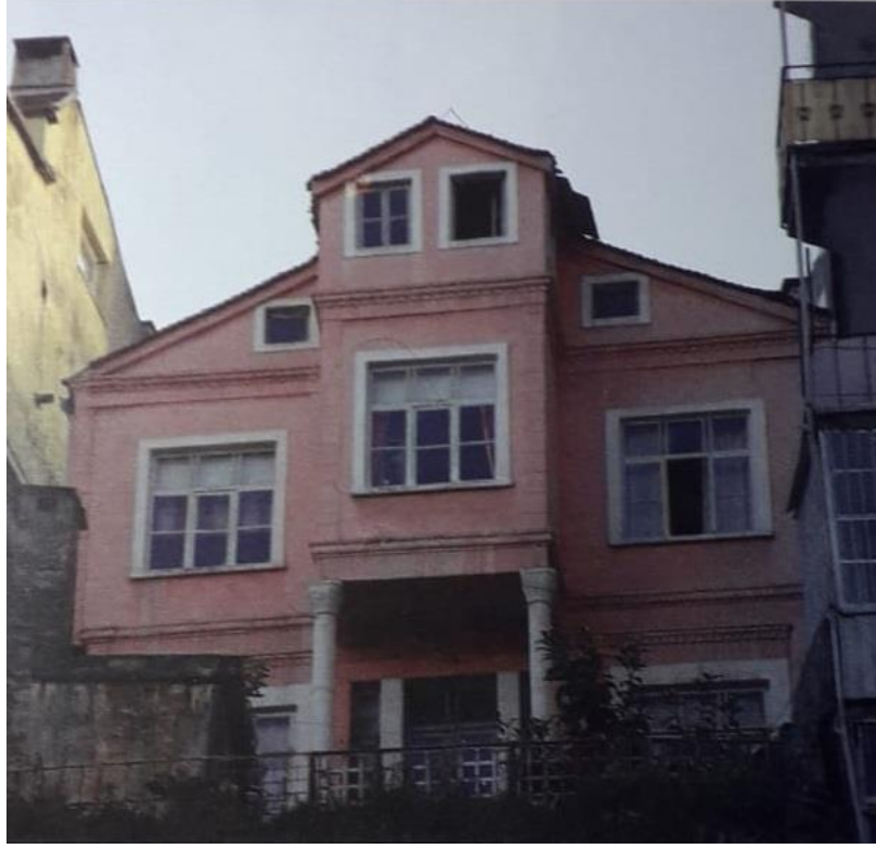
Şekil 2.14. 238 ada 1 parseldeki konut yapısı 2010 yılı güney cephesi (Özen, 2010, s.417)
