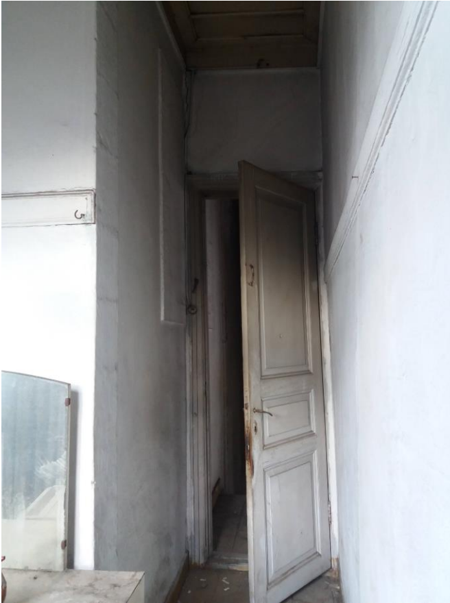
Şekil B. 112. 1-02 numaralı odanın giriş kapısı (2019)
