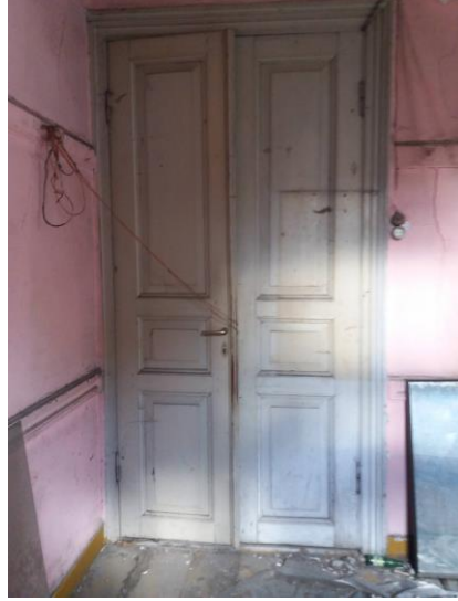
Şekil B. 116. 1-03 numaralı odanın giriş kapısı (2019)
