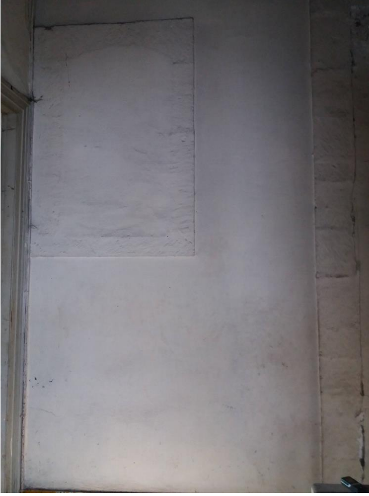
Şekil B. 107. 1-01 numaralı holün kuzey duvarı, duvarda bulunan kapatılmış pencere izi (2019)
