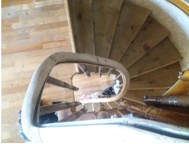
Şekil B. 66. Yapıda bulunan ahşap döner merdiven (2019)
