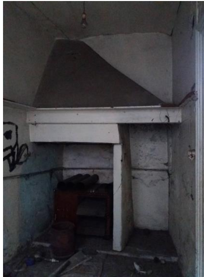
Şekil B. 88. Z-01 numaralı mekânın batı duvarı (2019)
