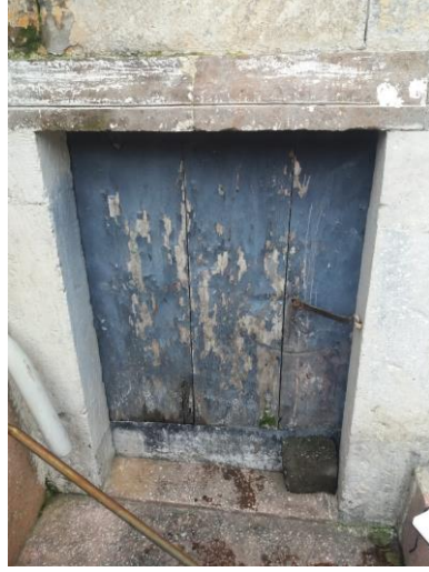
Şekil B. 70. Kurşunoğlu Konağı bodrum kat giriş kapısı (2019)
