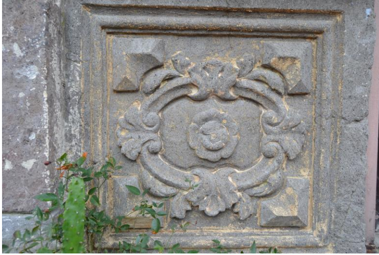
Şekil B. 15. Kurşunoğlu Konağı'nın kuzey cephesinde girişin iki yanında yer alan taş süsleme (2019)
