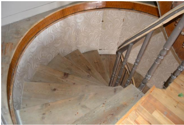
Şekil B. 67. Yapıda bulunan ahşap döner merdiven (2019)
