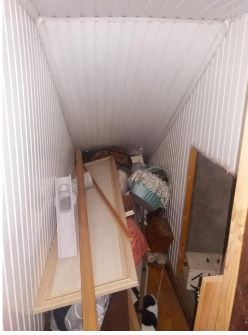
Şekil B. 65. Yapının ikinci katında bulunan çatı altı dolap (2019)
