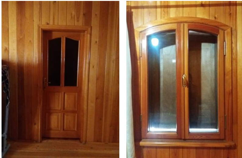
Şekil B. 61. 2-01 numaralı odanın giriş kapısı ve penceresi (2019)
