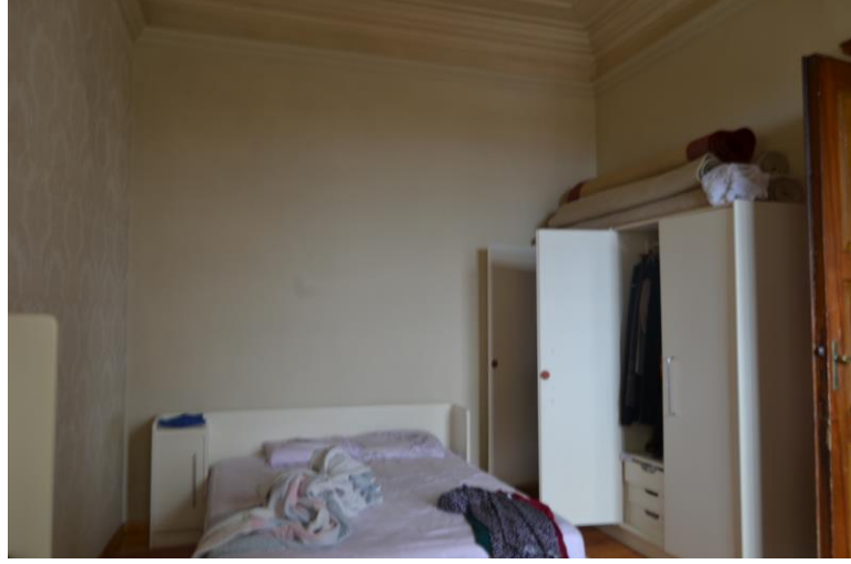
Şekil B. 49. 1-01 numaralı odanın güney duvarı (2019)
