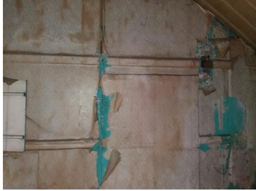
Şekil B. 97. Z-03 numaralı odanın kuzey duvarı (2019)
