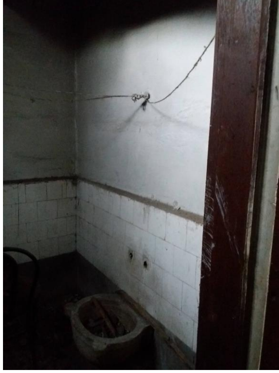
Şekil B. 101. Z-04 numaralı tuvaletin dođu duvarı (2019)
