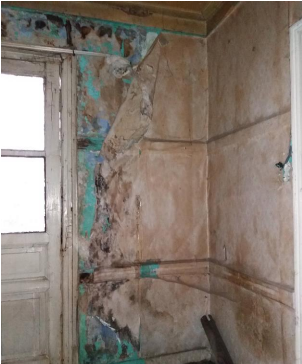
Şekil B. 95. Z-03 numaralı odanın güney duvarı (2019)
