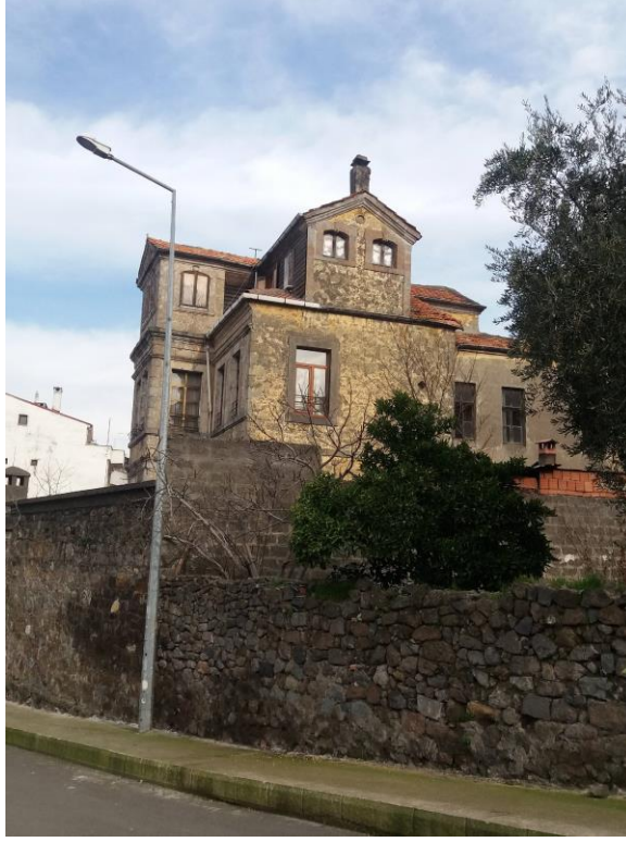
Şekil B. 10. Kurşunoğlu Konağı'nın Aralık Sokak üzerinden görünümü (2019)
