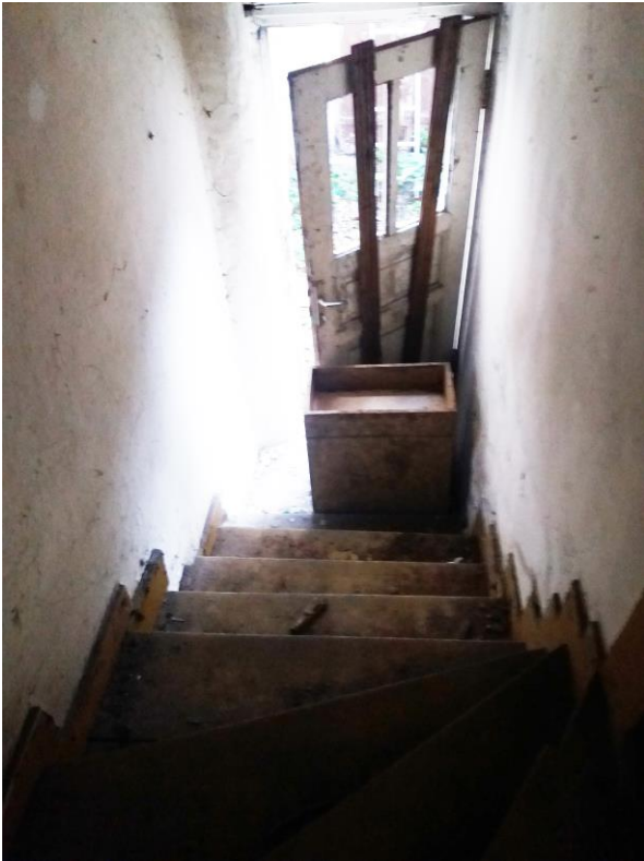
Şekil B. 104. Ek binada bulunan ahşap merdiven (2019)
