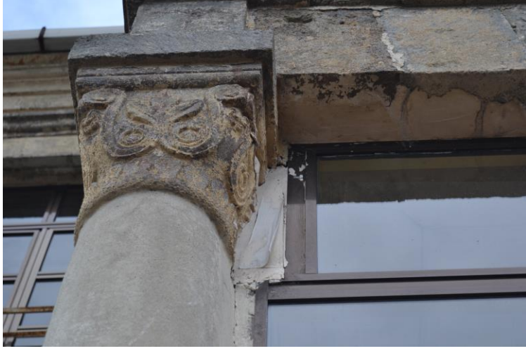
Şekil B. 14. Kurşunoğlu Konağı'nın kuzey cephesinde yer alan sütun başlığı (2019)
