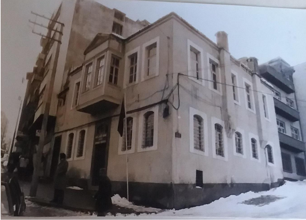
Şekil 2.15. 237 ada 26 parseldeki konut yapısı 1996 yılı fotoğrafı (Trabzon Kültür Varlıklarını Koruma Bölge Kurulu arşivi)
