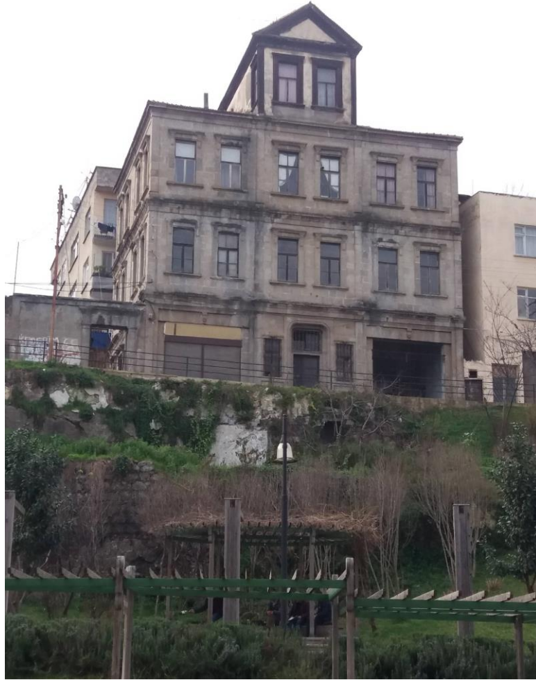
Şekil 5.38. Kalcıoğlu Evi giriş cephesi (2019)
