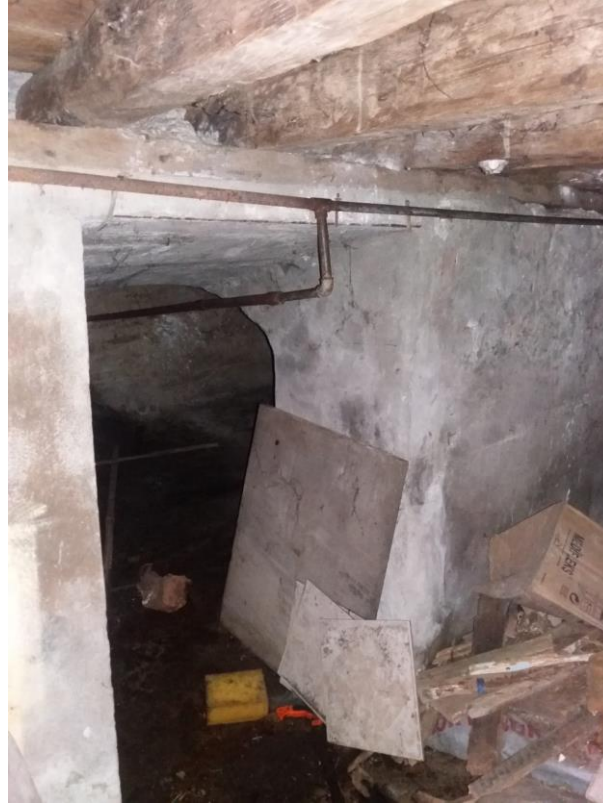
Şekil B. 73. B-01 numaralı mekandan B-02 numaralı mekan geçişi sağlayan boşluk (2019)
