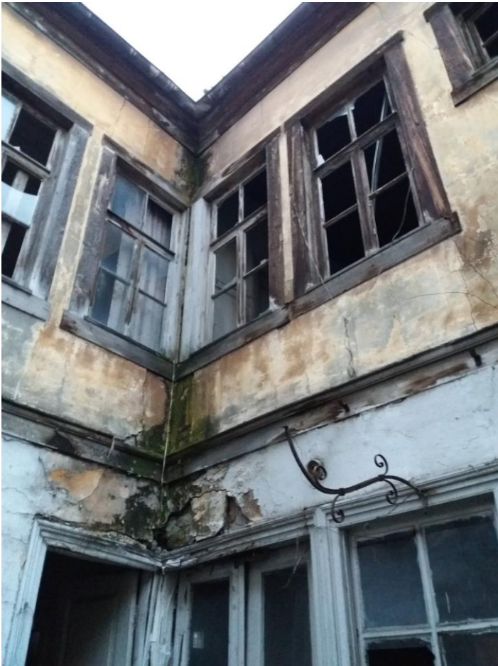
Şekil B. 81. Ek yapı güney ve doğu cephesi birleşimi (2019)
