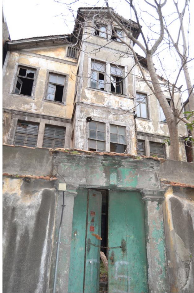
Şekil 5.33. 237 ada 4 parseldeki yapının kuzey cephesi (2019)
