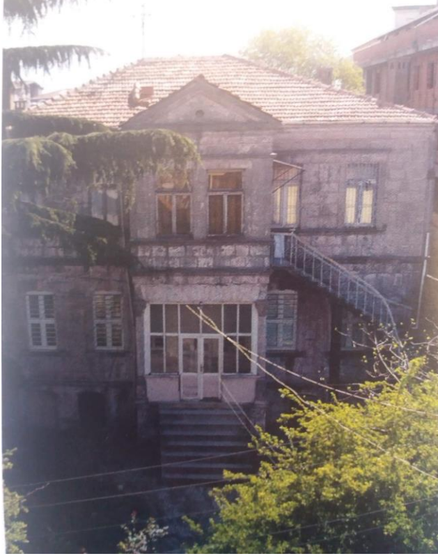
Şekil 5.37. 242 ada 90 parselde bulunan yapı (Tuluk, Ö, Düzenli, H, 2010, s.409)
