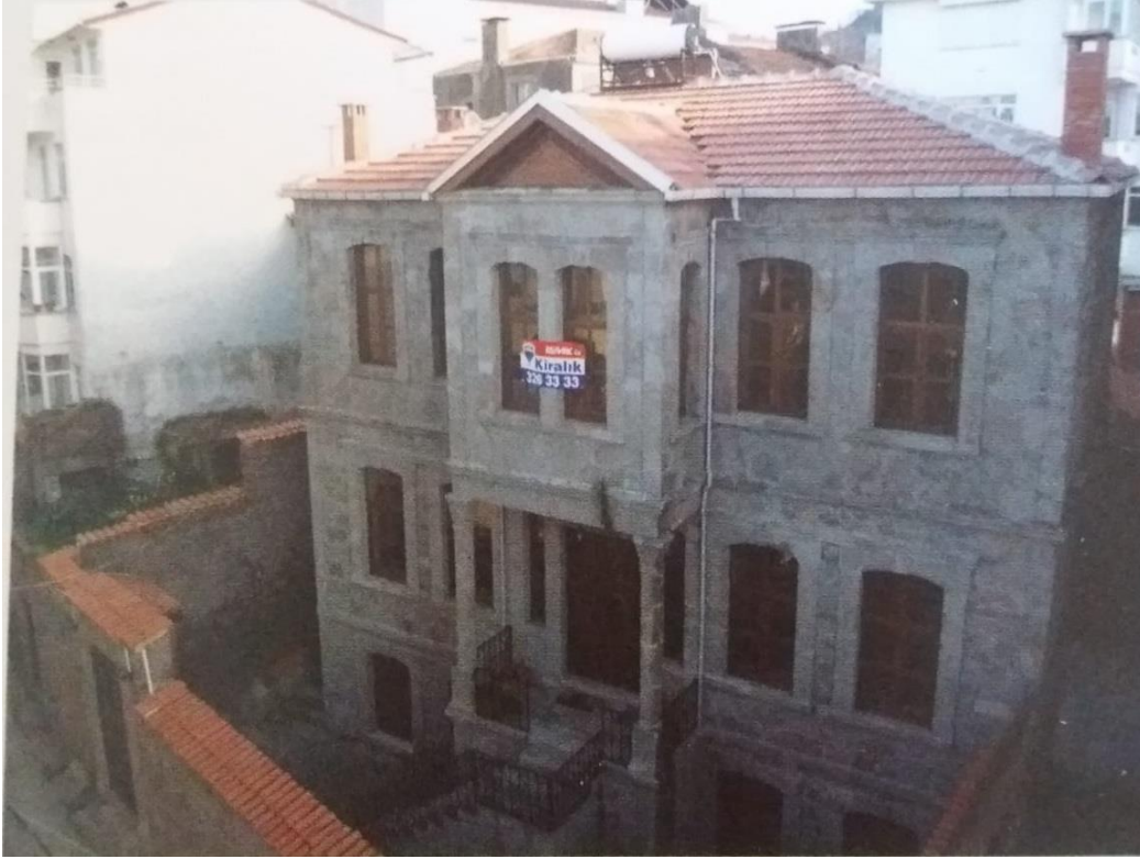
Şekil 5.29. 239 ada 2 parseldeki yapı (Tuluk, Ö, Düzenli, H, 2010, s.409)
