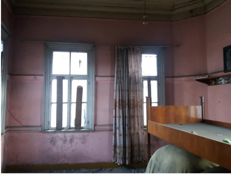
Şekil B. 118. 1-03 numaralı odanın güney duvarı (2019)
