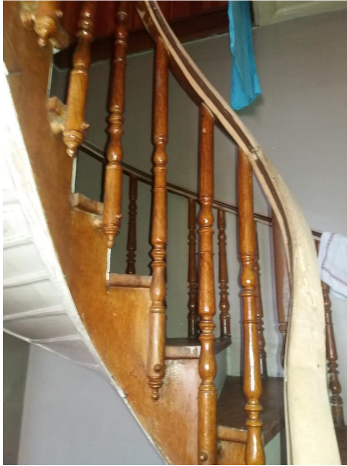
Şekil B. 69. Yapıda bulunan ahşap döner merdiven (2019)
