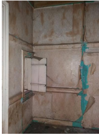
Şekil B. 98. Z-03 numaralı odanın batı duvarı (2019)
