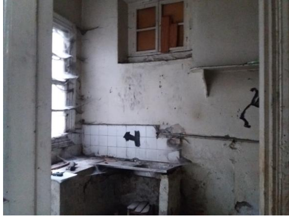
Şekil B. 87. Z-01 numaralı mekânın güney duvarı (2019)
