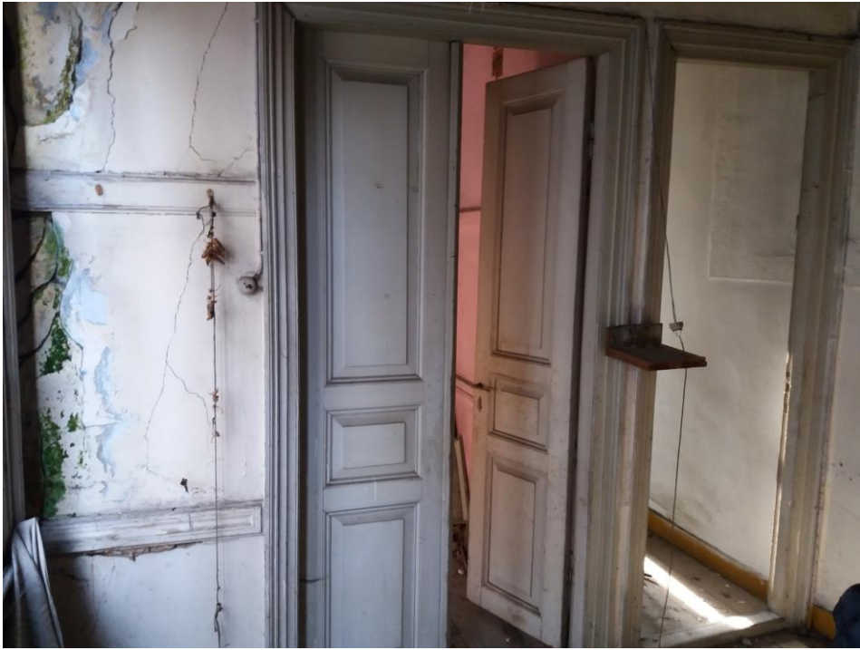
Şekil B. 106. Ek yapı 1-01 numaralı holün batı duvarı (2019)
