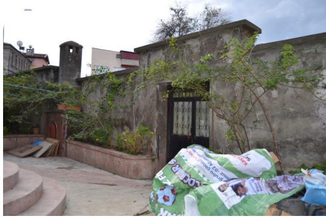
Şekil B. 7. Konağın Aralık Sokak üzerinden girişini sağlayan bahçe kapısı (2019)
