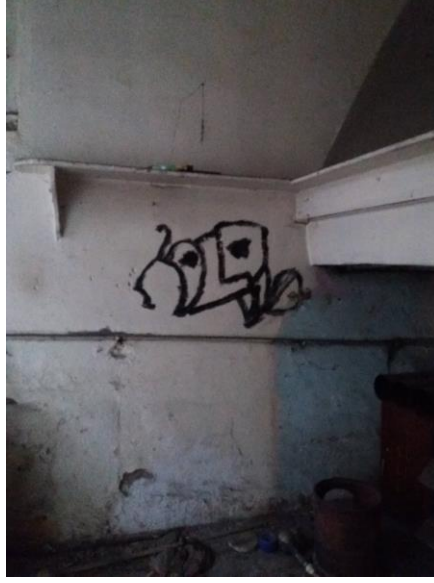
Şekil B. 86. Z-01 numaralı mutfağın güney duvarı (2019)
