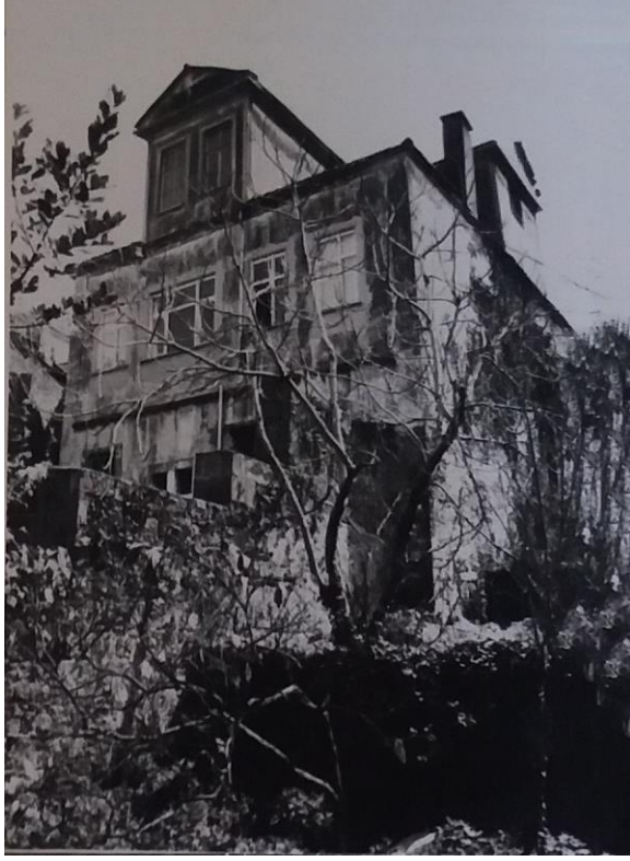
Şekil 2.9. 249 ada 7 parseldeki konut yapısı 1996 yılı fotoğrafı (Trabzon Kültür Varlıklarını Koruma Bölge Kurulu arşivi)
