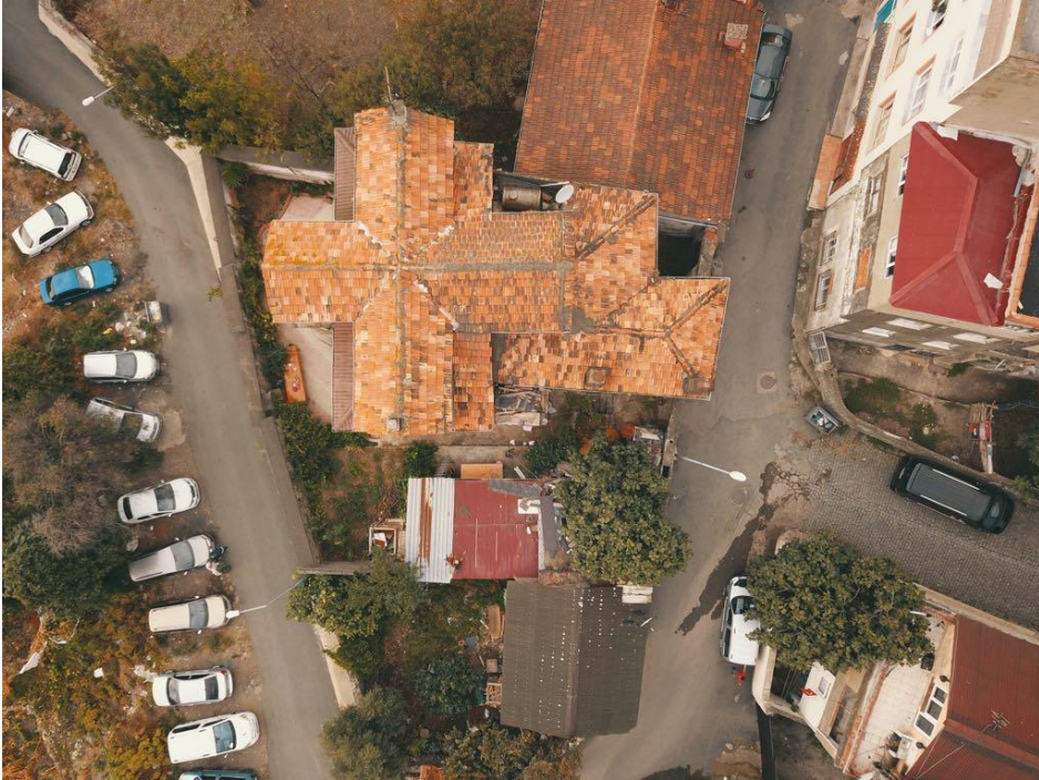
Şekil B. 2. Kurşunođlu Konađı ve ek yapı kuşbakışı görünüm (2019)
