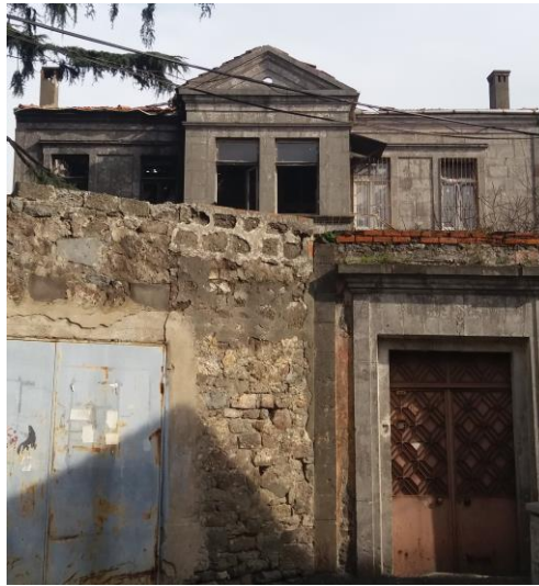
Şekil 5.36. 242 ada 90 parselde yer alan yapının batı cephesi (2019)
