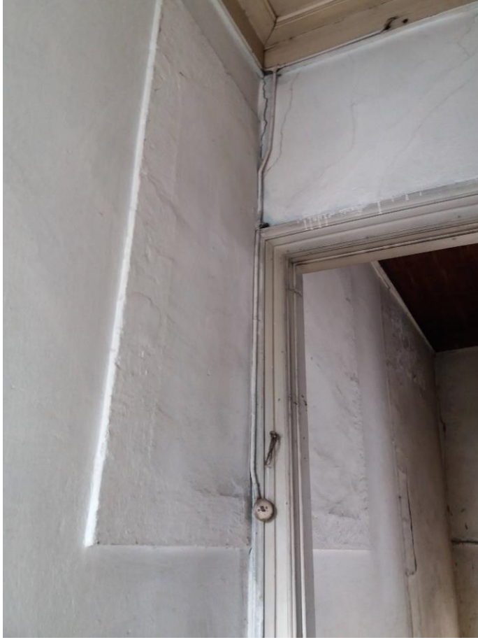
Şekil B. 113. 1-02 numaralı odanın kuzey duvarında yer alan kapatılmış pencere izi (2019)
