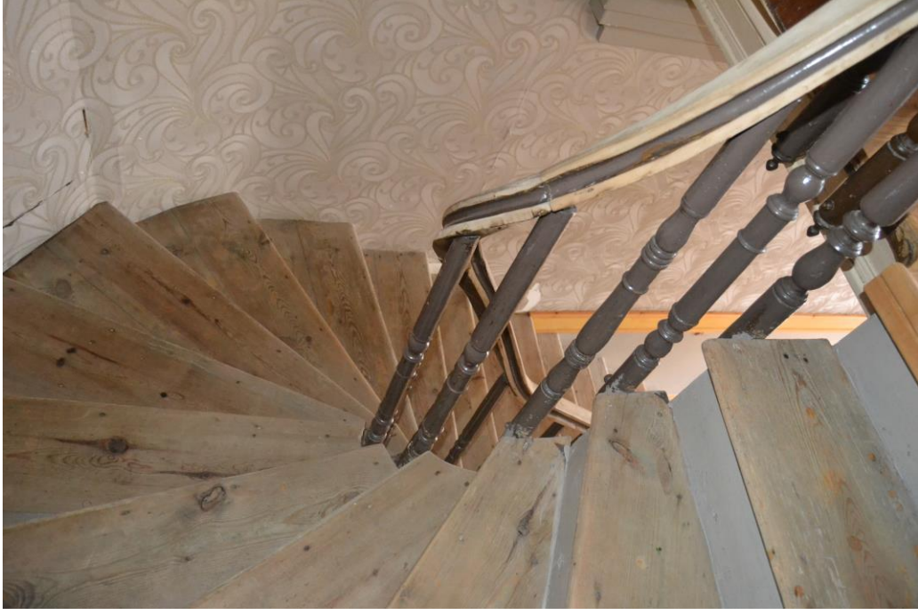
Şekil B. 68. Yapıda bulunan ahşap döner merdiven (2019)
