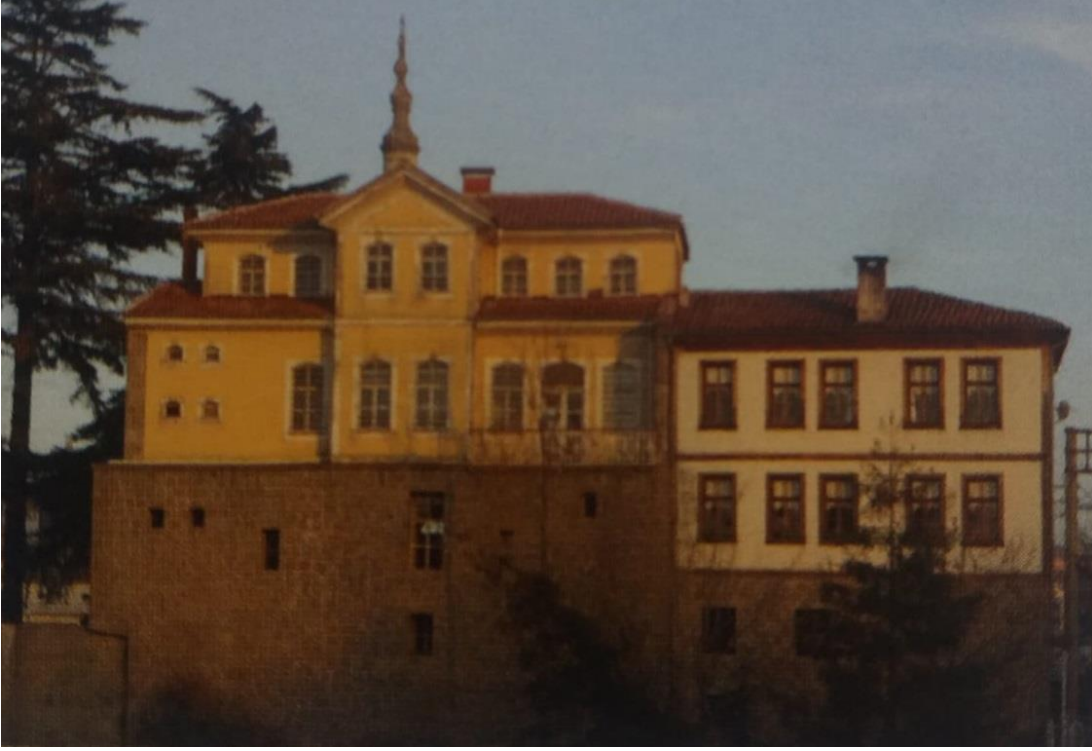
Şekil 5.41. 110 ada 41 parselde yer alan yapının batı cephesi (Tuluk, Ö, Düzenli, H, 2010, s.409)
