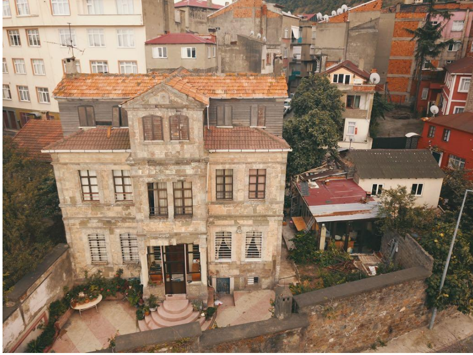
Şekil B. 3. Kurşunoğlu Konağı kuzey cephesi (2019)
