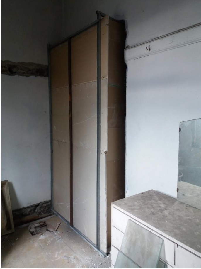
Şekil B. 109. 1-02 numaralı odanın dođu duvarı (2019)
