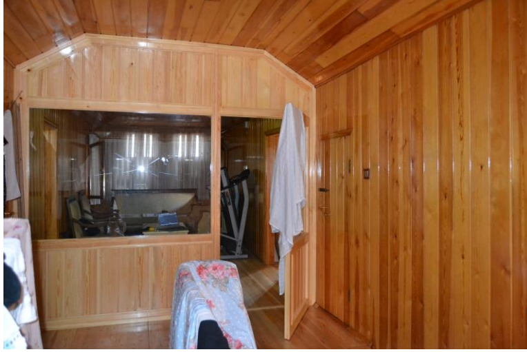
Şekil B. 59. 2-03 numaralı holde bulunan bölücü duvar (2019)
