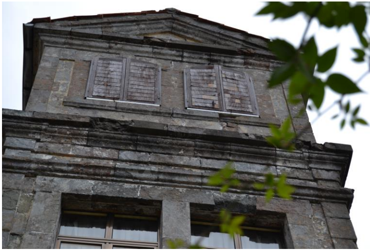
Şekil B. 16. Konağın ikinci kat pencerelerinde bulunan ahşap kepenk (2019)
