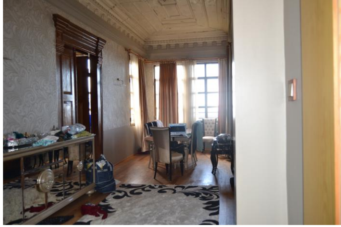
Şekil B. 35. 1-03 numaralı holün kuzey ve batı duvarı (2019)
