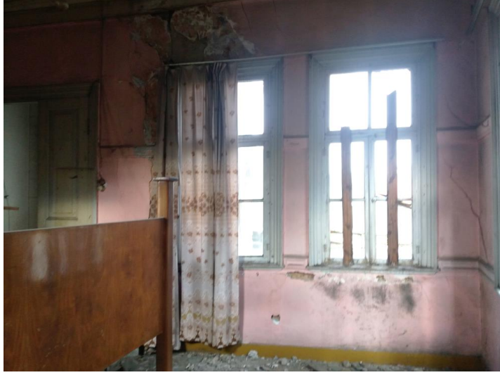
Şekil B. 115. 1-03 numaralı odanın doğu duvarı (2019)
