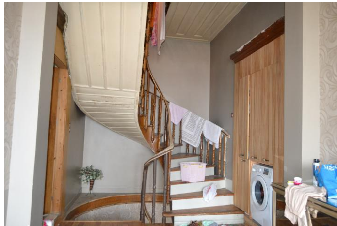
Şekil B. 37. 1-03 numaralı holün güney duvarı, birinci katı ikinci kata bağlayan ahşap döner merdiven (2019)
