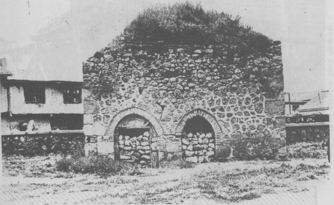
Resim : 40 — Mektebin giriş cephesi tamirden önce.
