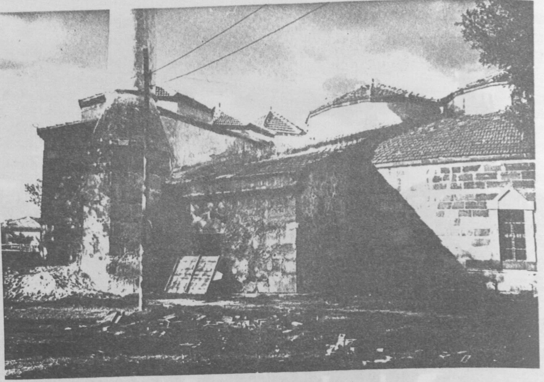
Resim : 6 — Camiin yan cephesi.
