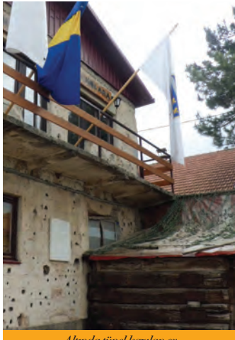
Altında tünel kazılan ev
