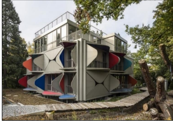
Görsel 4.1. Mekanik Bale Binası. 274
