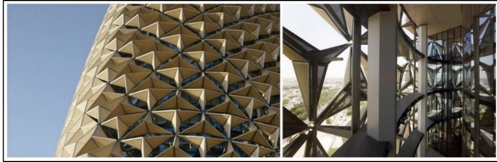
Görsel 4.8. Al Bahar Kuleleri Cephe Görünüşü ve İskeleti. 283
