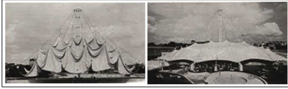
Görsel 1.21. 1967’da R. Taillibert Tarafından Tasarlanan Boulevard Carnot Yüzme Havuzu Üst Örtüsü Açık ve Kapalı Pozisyonları. 62
