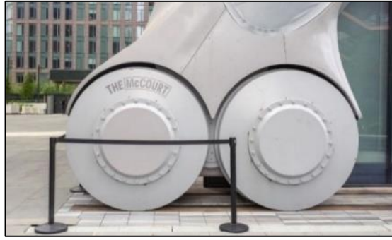
Grsel 4.49. The Shed Yapı Kabuđunun Hareket Etmesini Sađlayan Tekerlekler. 346
