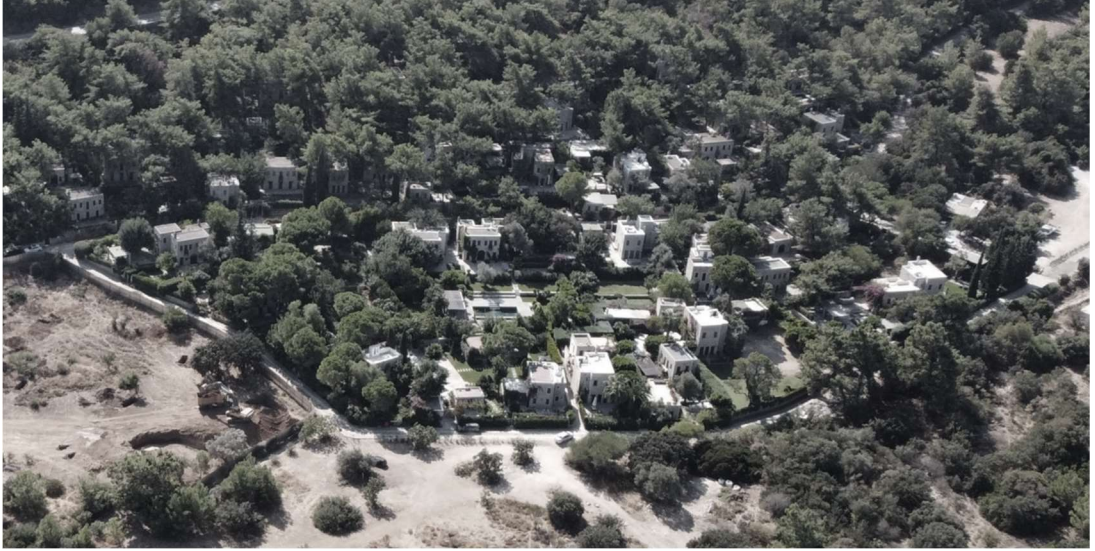
Şekil 3.49: Demir Evler Kompleksi, Turgut Cansever. (Berşan Karagül, 2022)
