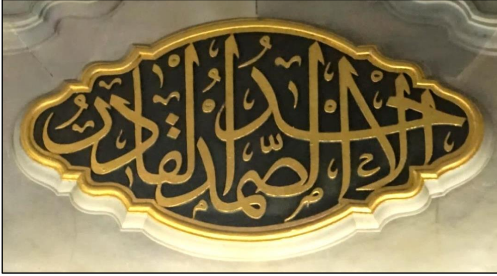
Resim 2. 47: Nuruosmaniye Camii kuzey duvar cephesinde esmâ.
