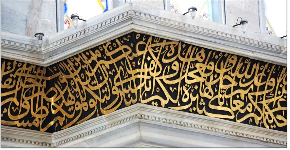
Resim 2. 118: Nuruosmaniye Camii kuşak yazısı köşe geçiş detayı.
