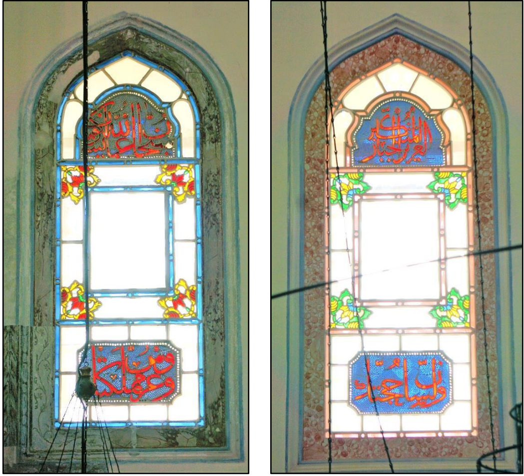
Resim 2. 167-2. 168: Ayazma Camii batı duvar cephesi revzen yazıları.
