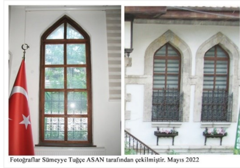
Resim 2.12 2 no.lu, Kazanasmazlar Konağı, ön cephe pencereleri. 157
