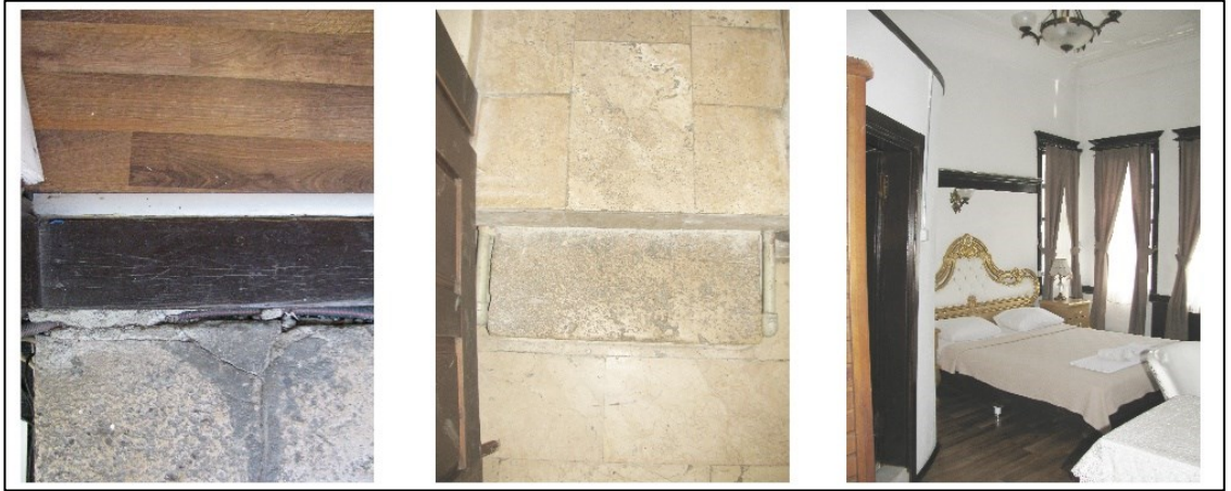
Resim 3.6 Solda: avlu-1. kat zemini, ortada: avlu-bodrum kat zemin: Amasya beji mermeri. Sağda: banyo ile yenilenmiş örnek hotel odası
