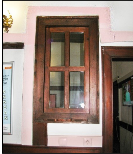
Resim 3.13 2 no.lu Kazanasmazlar yapısı elektrik kablo kanalları 186
