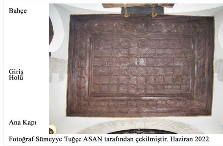
Resim 2.9 2 no.lu Kazanasmazlar Konağı, 464-6 ada parsel, giriş holü tavanı.
