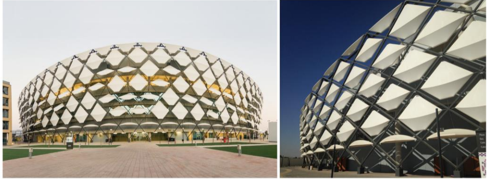
Şekil 2. 27 Hazza Bin Zayed Stadyumu cephesinde kullanılan hareketli sistem örneği (Url-5)
