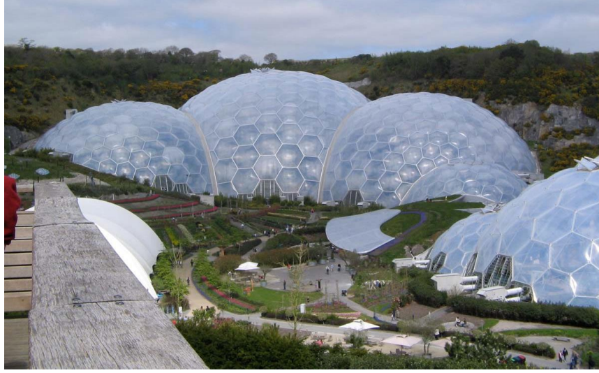
Şekil 3. 10 ETFE kaplama malzemesi ile tasarlanan Eden projesi (Url-20)
