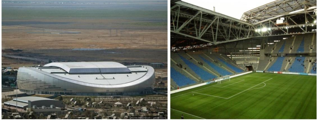
Şekil 4. 1 Hareket eden çelik malzeme çatı-Astana Stadyumu 2009 (Url-33)
