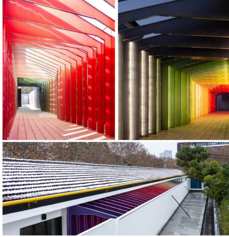
Şekil 3. 11 Tasarlanan sokakta kullanılan PC malzemeli güneş panelleri-Şangay (Url-93)
