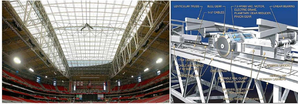
Şekil 5. 25 Stadyum çatı konstrüksiyonu (Waggoner, 2018)
