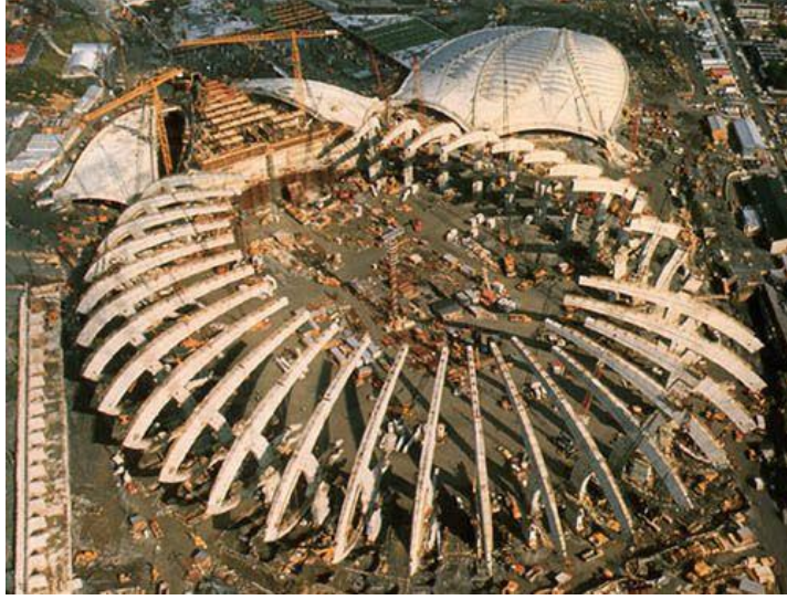
Şekil 5. 44 Stadyum temel taşıyıcı sistemi (Url-76)
