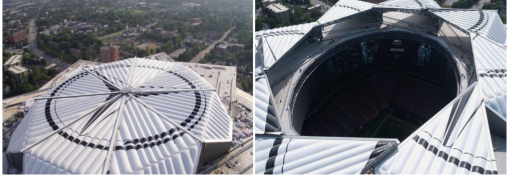
Şekil 5. 17 Çatı malzemesi yakın görünüm (Url-59)
