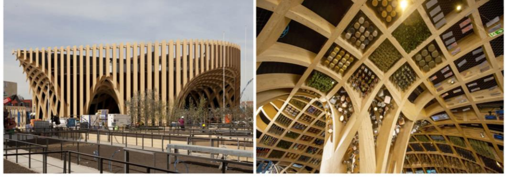
Şekil 3. 17 Ahşap malzemenin hem taşıyıcı hem üst örtü olarak kullanılması (Url-96)
