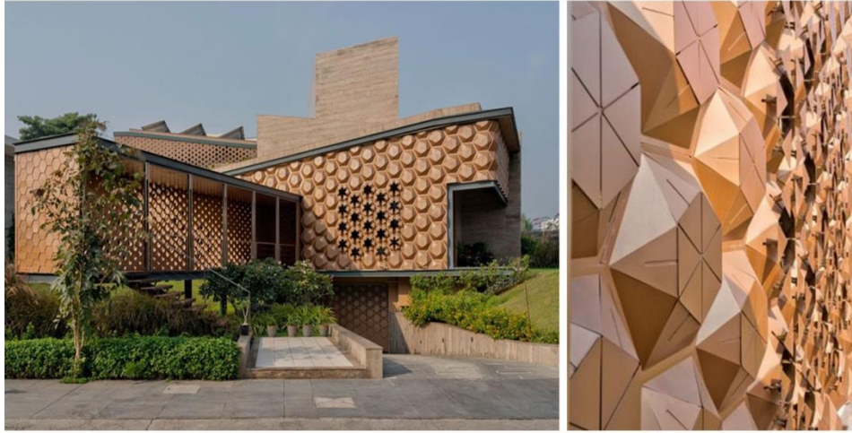
Şekil 3. 3 Cephede metal kullanımı ve güneşin hareketiyle açılıp kapanan cephe (Url-21)
