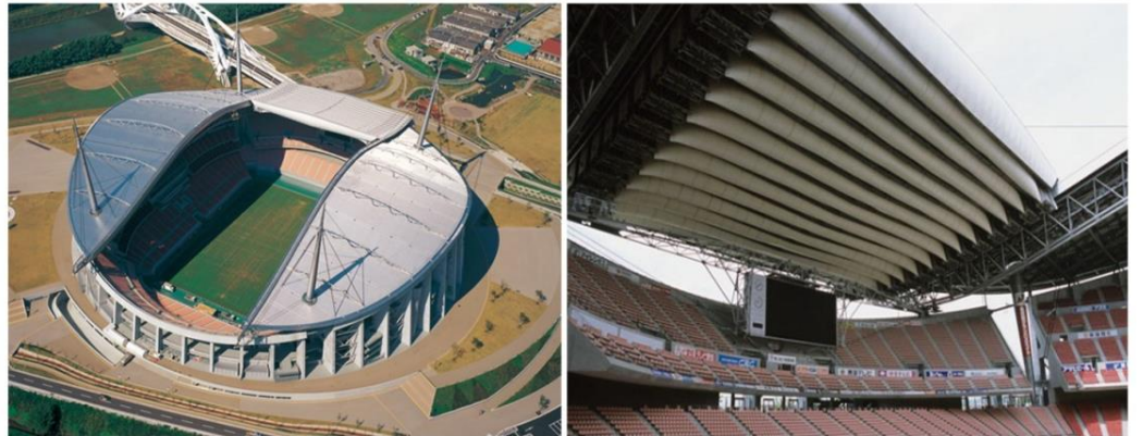
Şekil 4. 2 Hareket eden PVC malzeme çatı- Toyota Stadyumu 2001 (Url-32)
