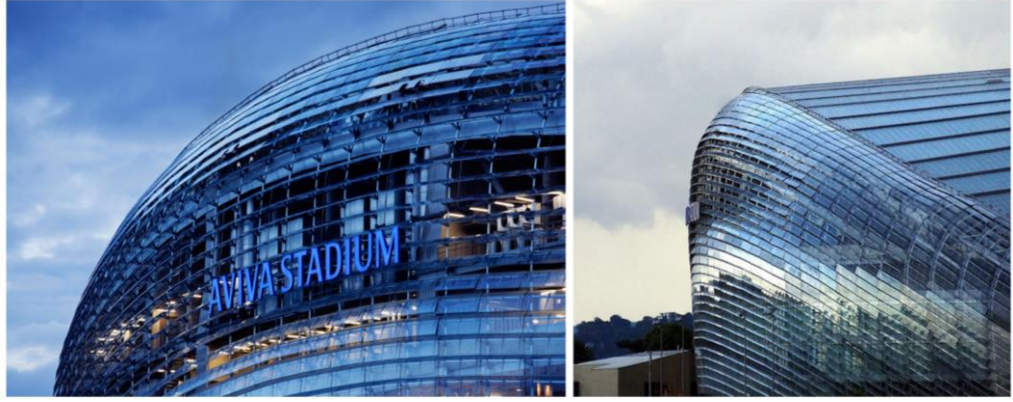
Şekil 5. 60 Aviva Stadyum cephesinde kullanılan şeffaf panjurlar (Url-105)
