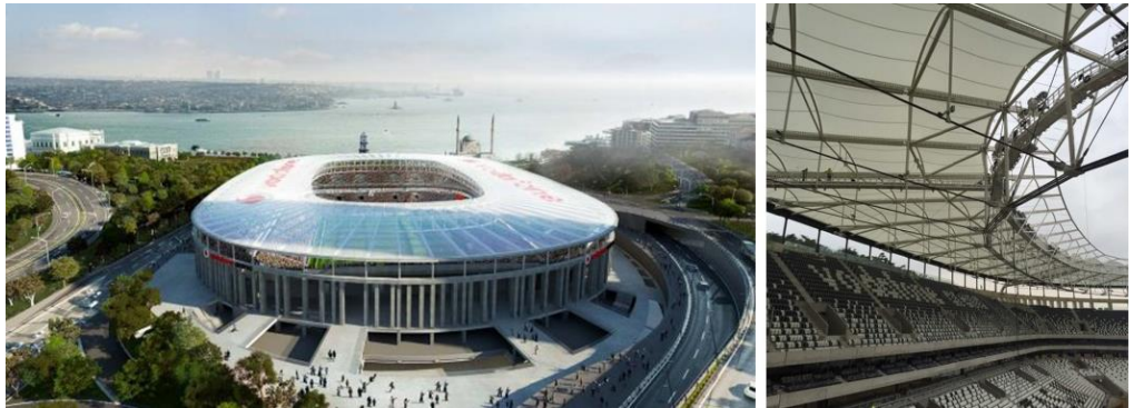
Şekil 3. 7 Vodafone Arena örtü sisteminde PTFE malzeme kullanımı (Url-15)
