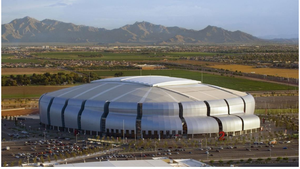
Şekil 5. 29 Cephedeki dikey cam bantlar ve metal panel kullanımı (Url-65)
