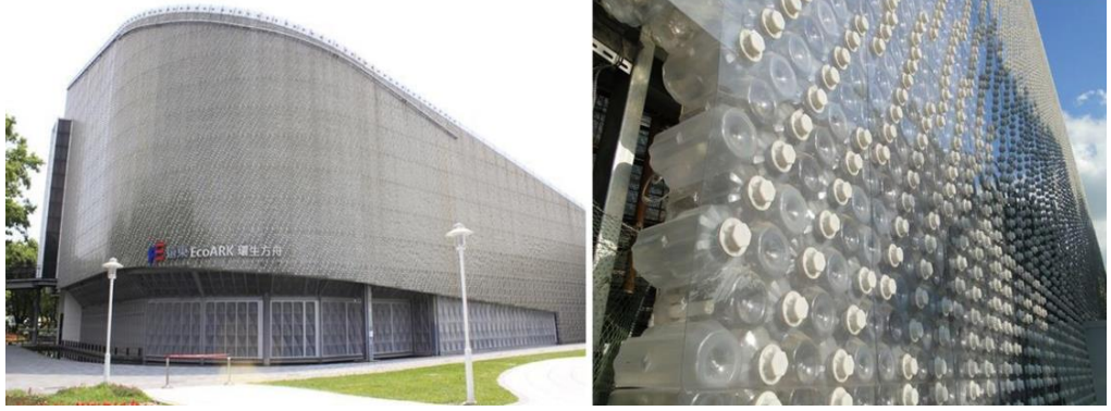
Şekil 3. 12 Cephesi plastik şişeden oluşan EcoArk projesi (Url-94)
