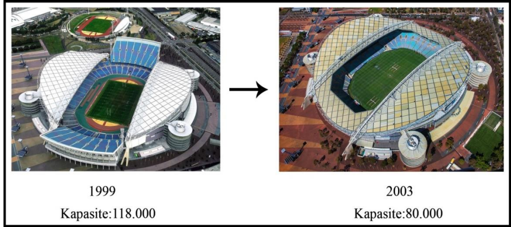
Şekil 5. 35 Stadyum tribün ve çatı dönüşümü (Selo, 2019)
