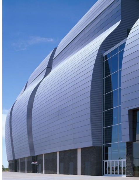
Şekil 5. 28 Stadyum cephesi ve dikey cam bantlar (Url-65)
