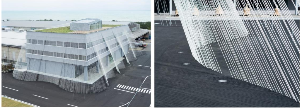
Şekil 3.15 Fa-bo galerisi ve zemine bağlanmış karbon fiber iplikler (Url-22)
