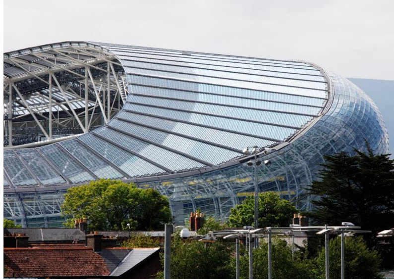
Şekil 5. 62 Çatı ve cephe birleşimi (Url-105)
