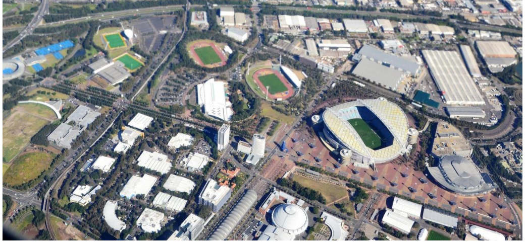
Şekil 5. 30 Şehir ve stadyum konumu (stadyumun günümüz hali) (Url-66)
