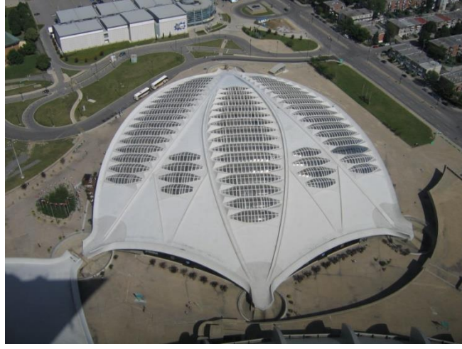
Şekil 5. 40 Alanda bulunan velodrom binası (Url-81)
