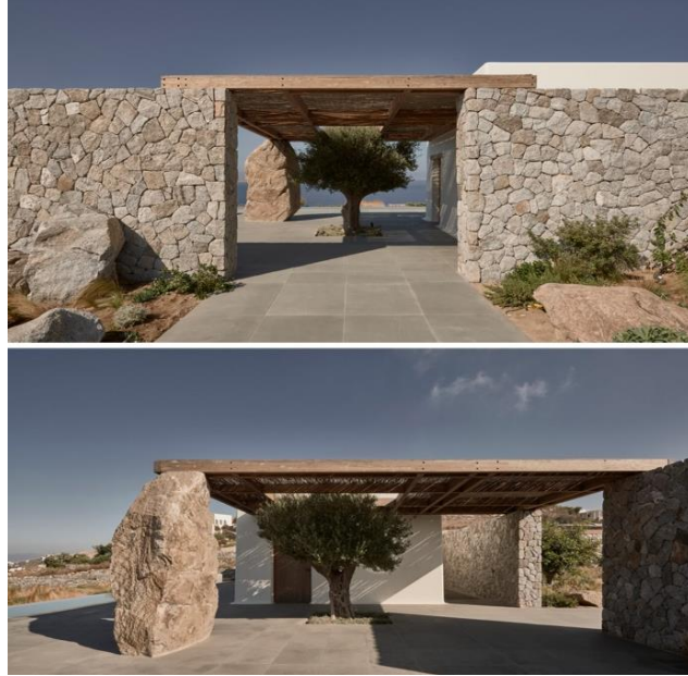
Şekil 3. 19 Cephede kaplama taş malzeme kullanımı (Url-98)
