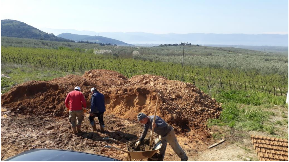
Resim 64 Kerpicin karılması ve çiğnenmesi
