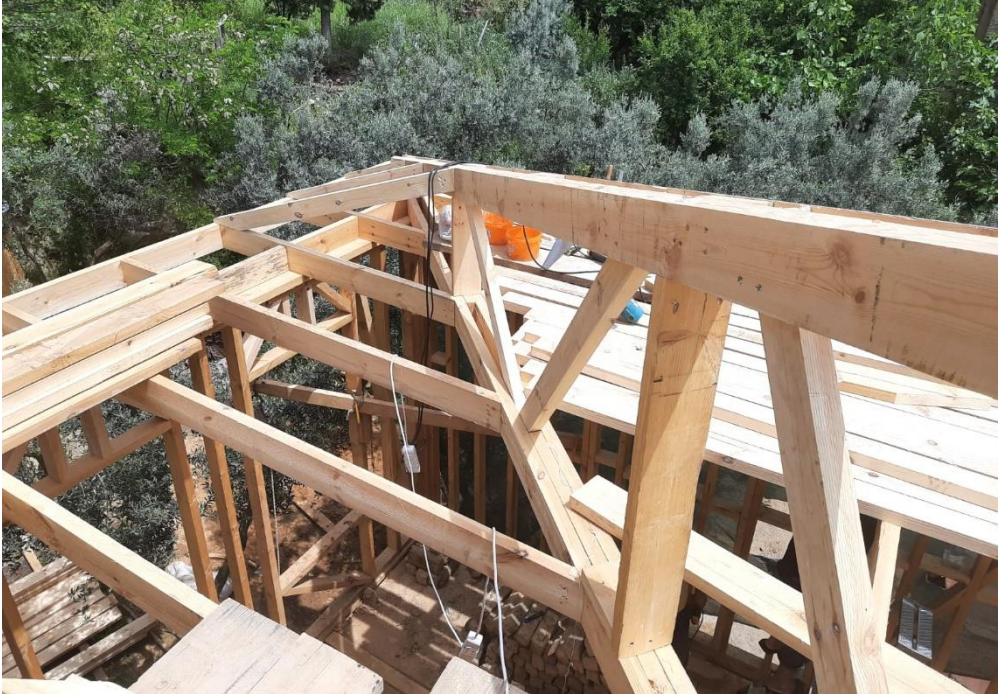
Resim 89 Çatı karkası köşede makas şeklinde yapılmıştır
