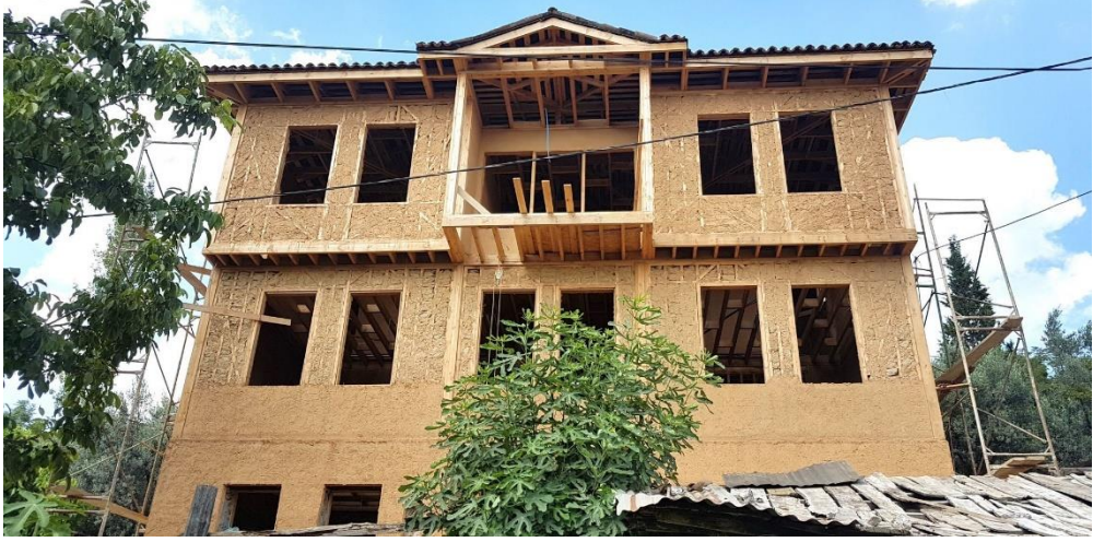
Resim 121 Bina ön cephede kerpiç sıvanın kaba aşaması
