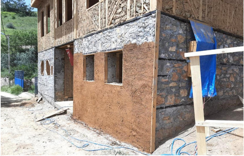
Resim 116 Taş duvar üzeri kerpiç sıvanın kaba aşaması
