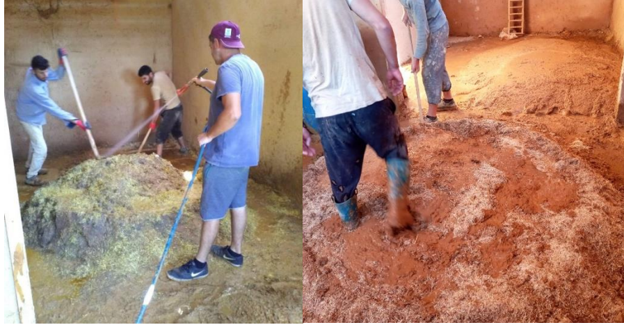
Resim 111 Kerpiç sıvanın hazırlanması
