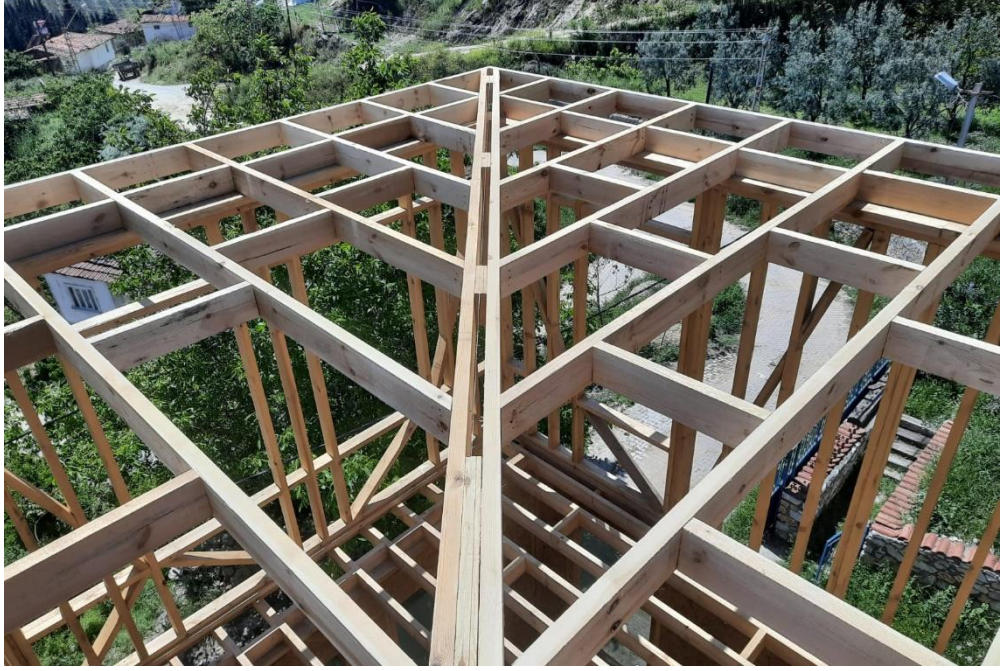
Resim 87 Ahşap döşeme ve tavan mertekleri ile ahşap duvar ilişkisi
