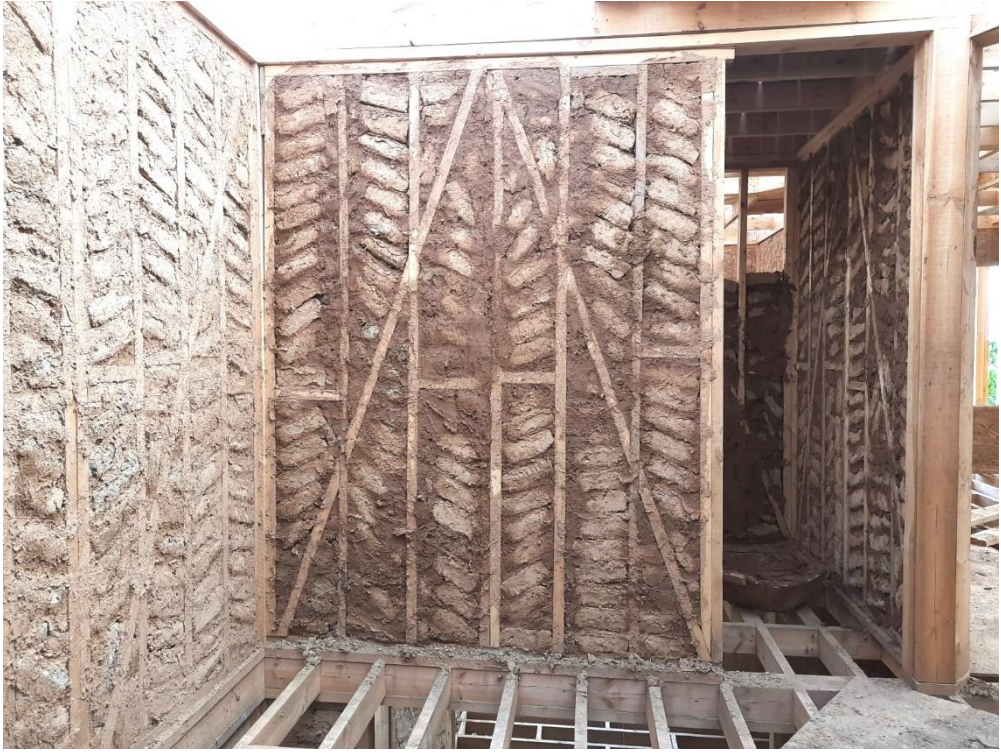
Resim 79 Kerpiç örülmüş ahşap karkas duvar
