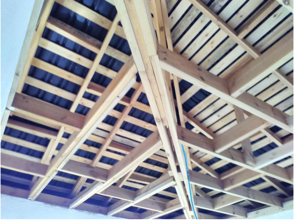
Resim 88 Çatının oturduğu üst kata tavan karkası
