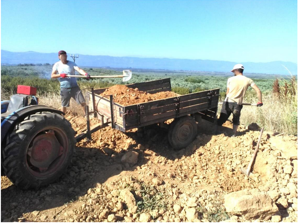
Resim 63 Kerpiç toprağının traktörle nakli
