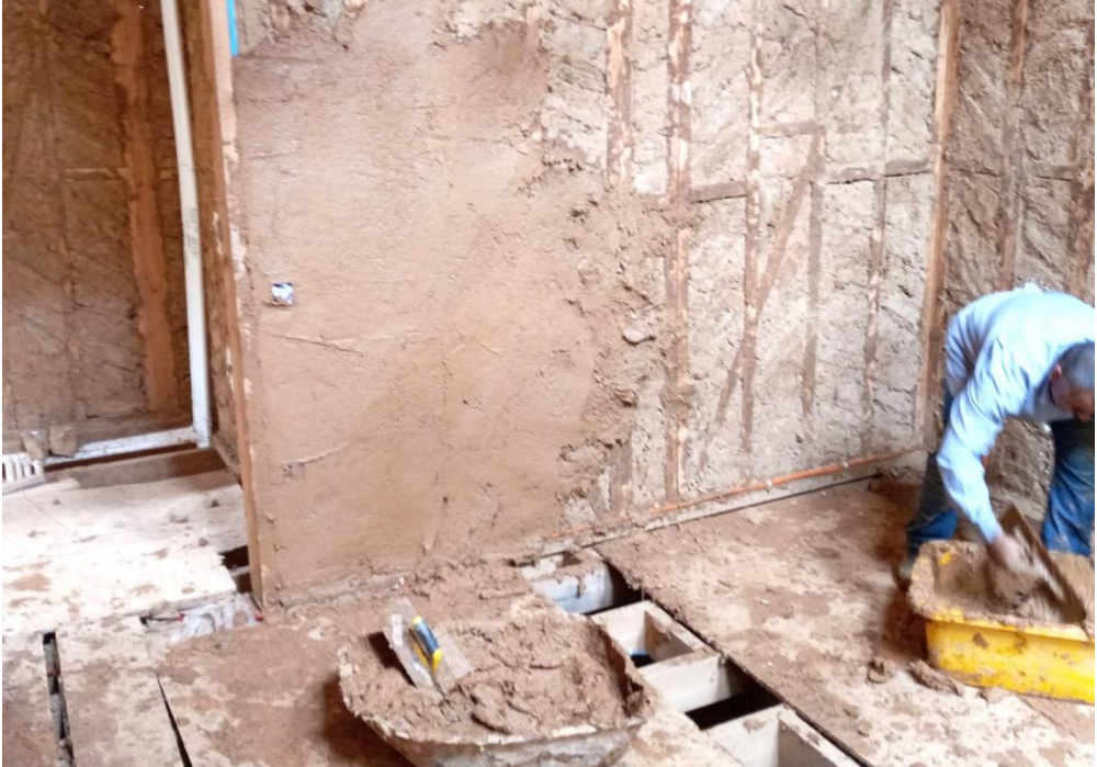
Resim 114 Ahşap duvar üzeri kerpiç sıvanın kaba aşaması
