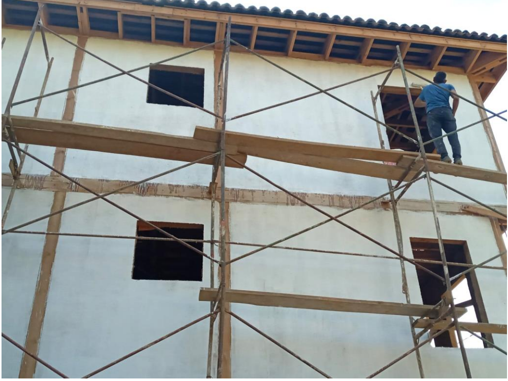
Resim 144 Kireç badananın sürülme işlemi
