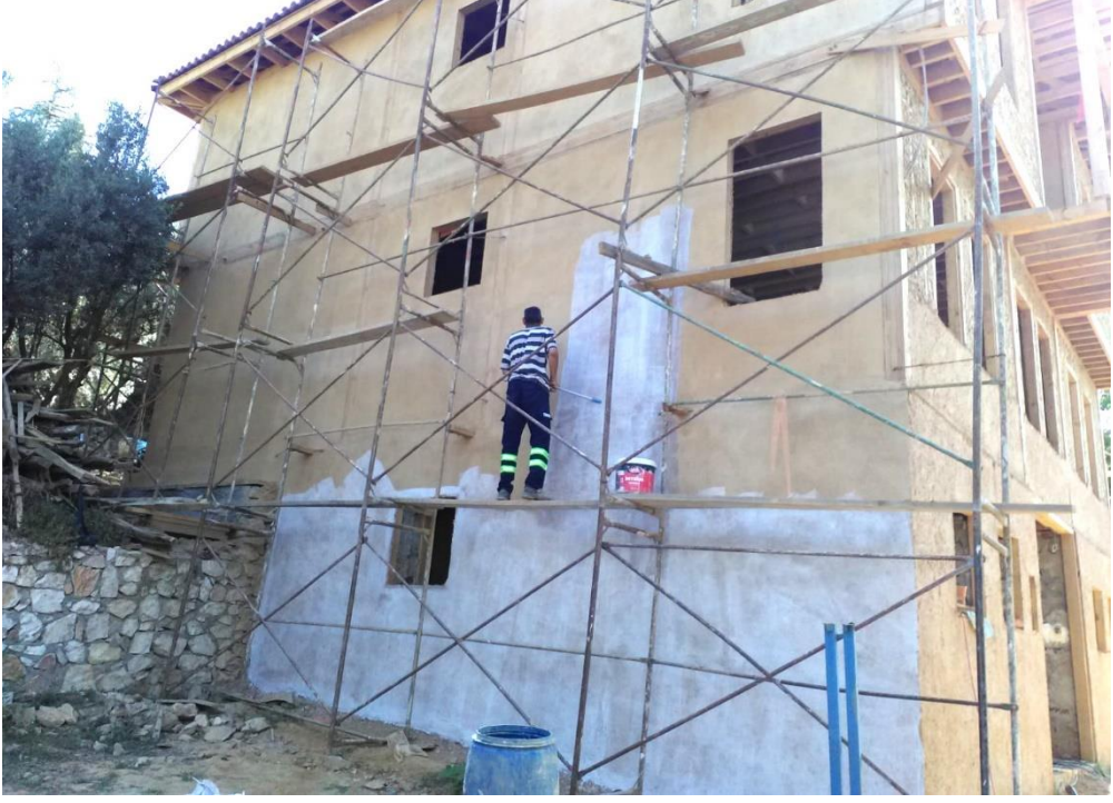
Resim 141 Kireç badananın sürülme işlemi
