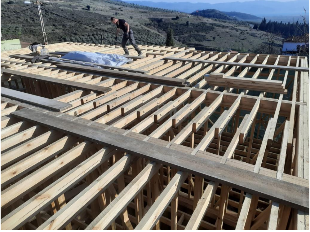
Resim 85 Ahşap döşeme mertekleri ve taban ilişkisi
