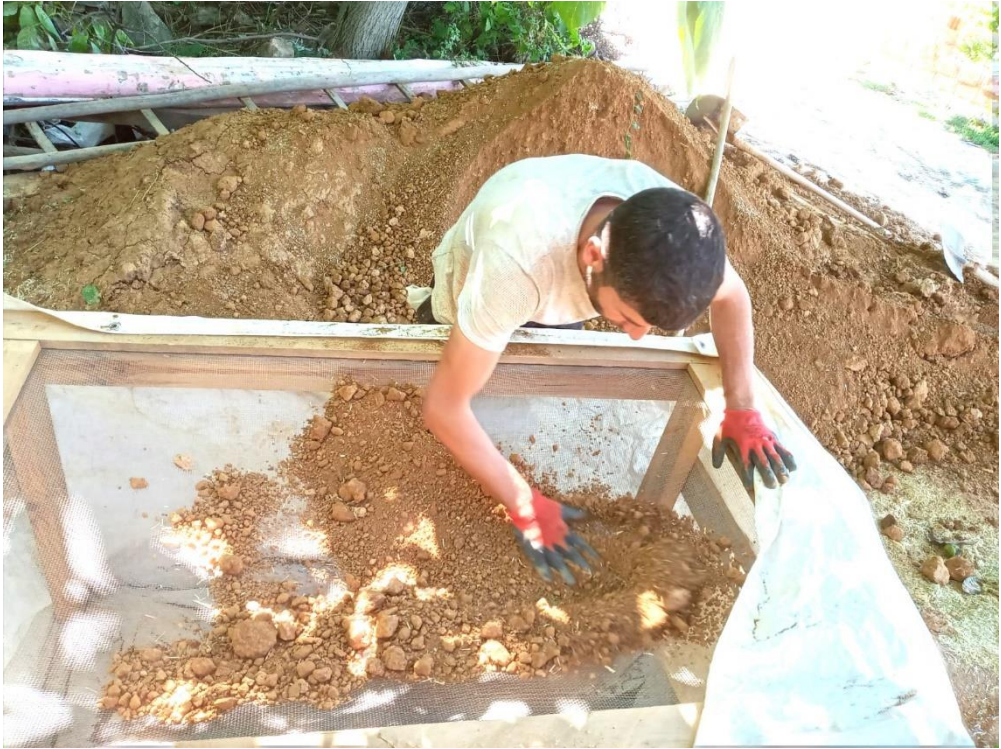
Resim 77 Kerpici örmek ve kerpiç sıva için kullanılan toprağın elenmesi
