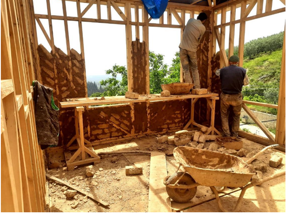
Resim 80 Kerpiç örme işlemi
