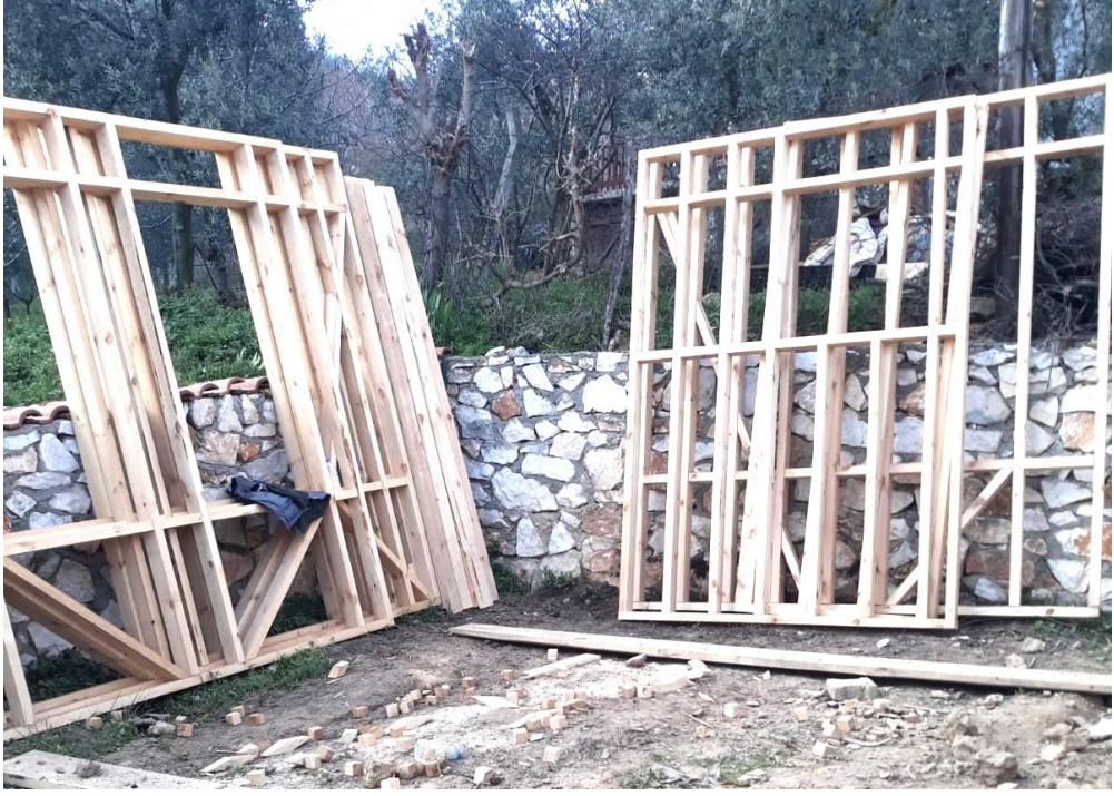
Resim 50 Yerde çakılmış ahşap duvar panelleri
