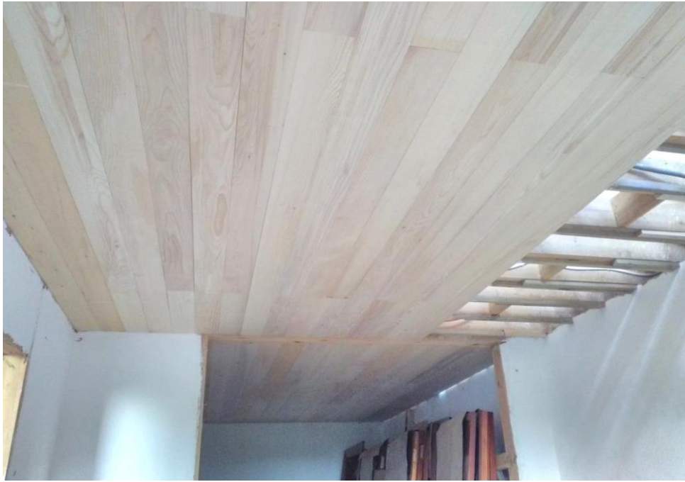
Resim 150 Tavan kaplaması çakılması
