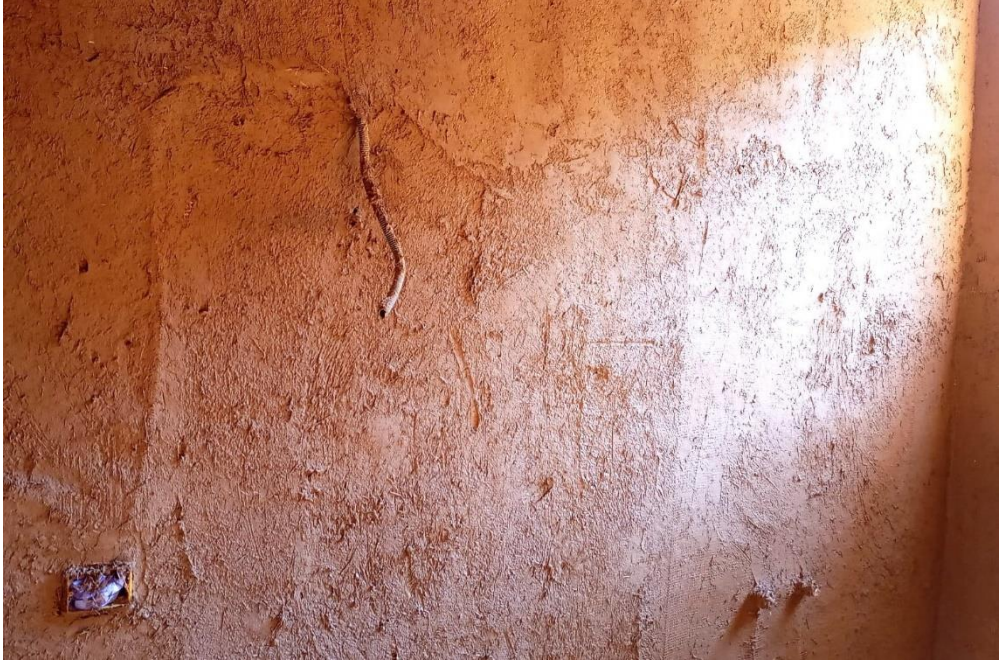
Resim 119 Ahşap duvar üzeri kerpiç sıvanın kaba aşaması – duvarda tesisat altlığı bulunmaktadır.
