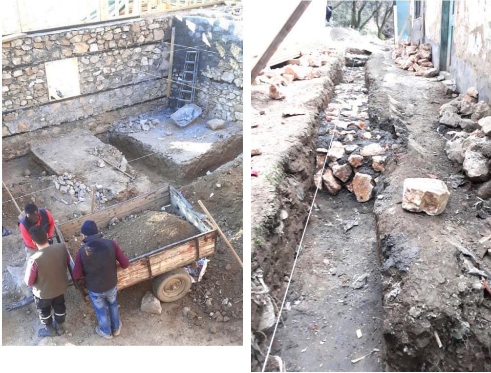
Resim 35 Temel inşası aşamaları
