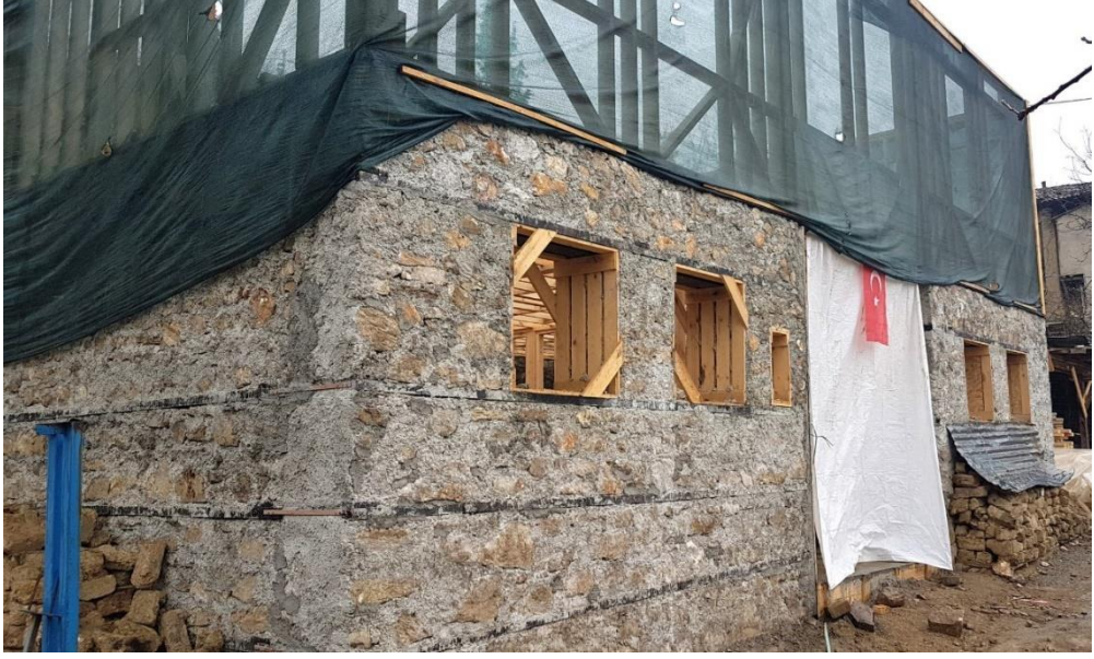
Resim 47 Taş duvarda pencere boşluğu açılması ve ahşap hatıllar
