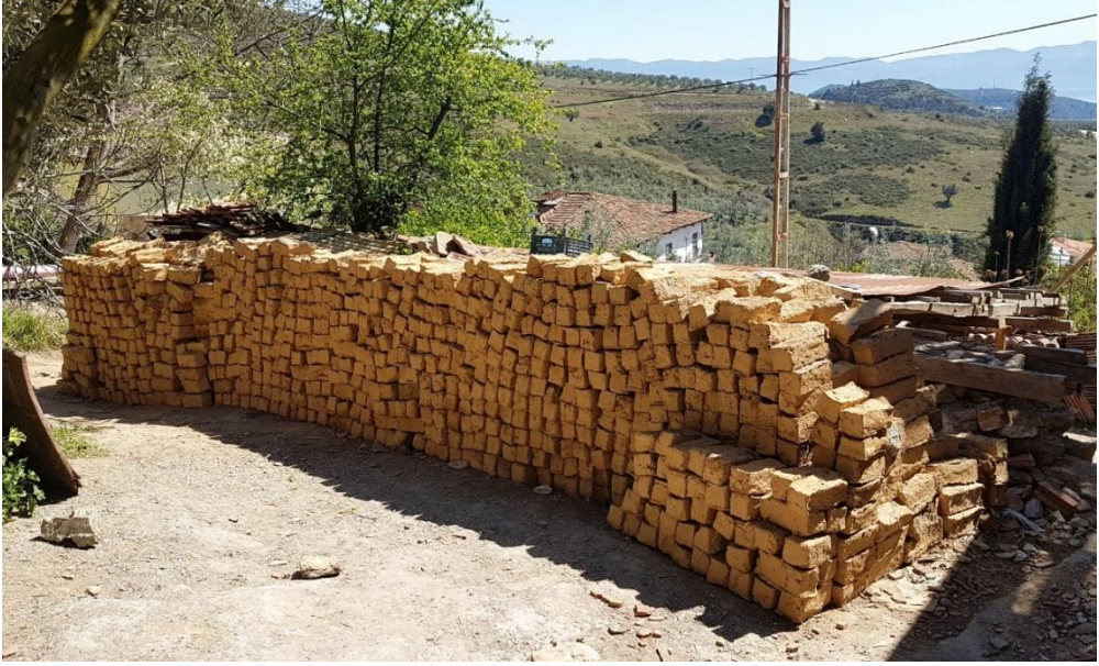
Resim 74 Kuruduktan sonra inşaat alanına getirilmiş kerpiç
