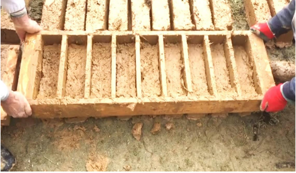
Resim 69 Kerpicin kalıptan çıkarılması
