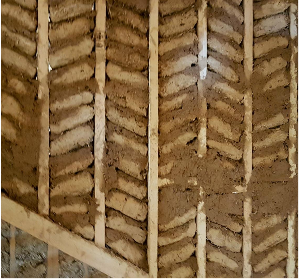
Resim 75 Kerpiç örgü ahşap karkas ilişkisi
