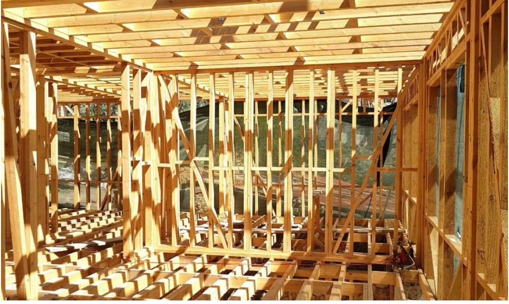
Resim 59 Ahşap karkas, tüm detaylar bir arada
