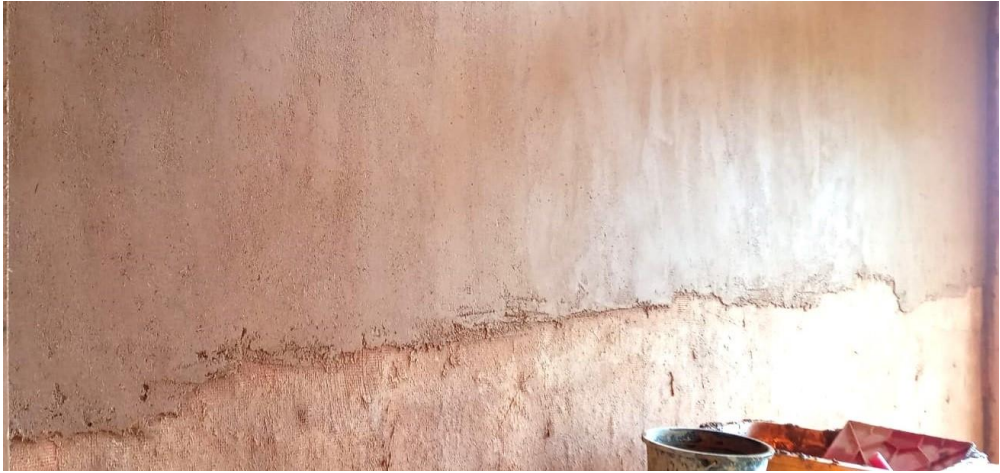
Resim 122 Taş duvar üzeri kerpiç sıvanın kaba ve ince aşaması
