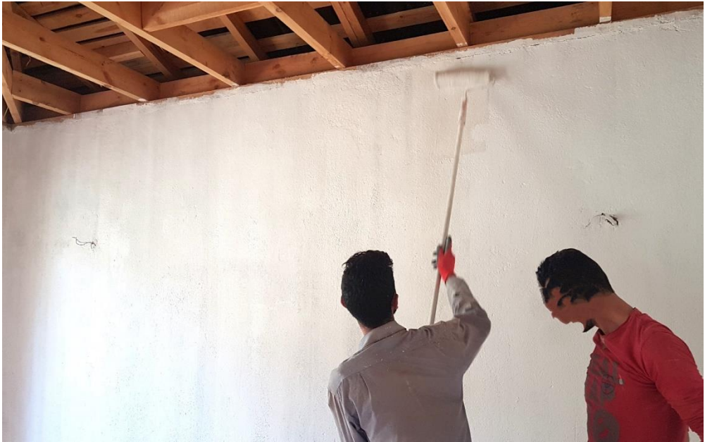
Resim 143 Kireç badananın sürülme işlemi
