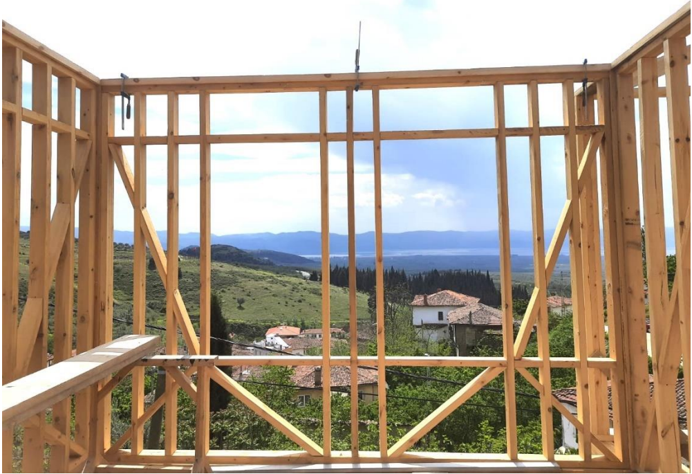
Resim 56 Ahşap karkas, sikme ve çapraz bağlantılar
