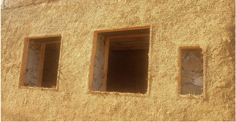
Resim 120 Taş duvar üzeri kerpiç sıvanın kaba aşaması
