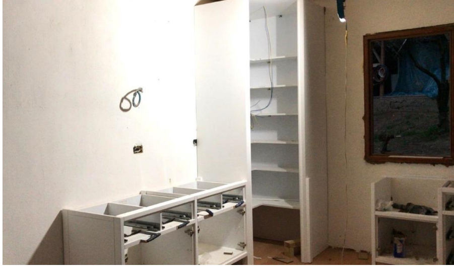
Resim 139 Mutfak dolabı montaj aşaması
