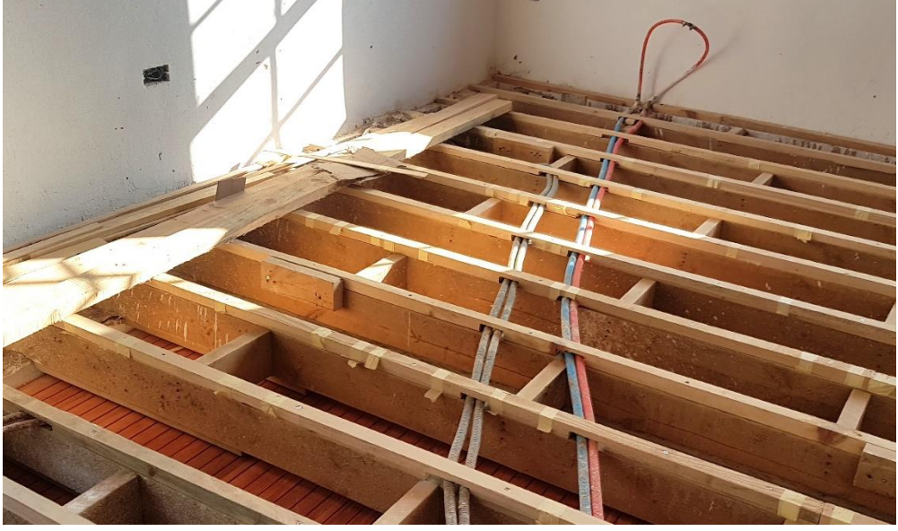
Resim 105 Tesistatların üstünden geçen ıtarlar
