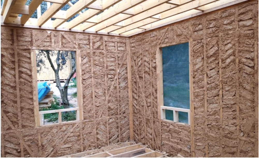
Resim 81 Kerpiç örülmüş ve harçları kurumuş duvar örgü
