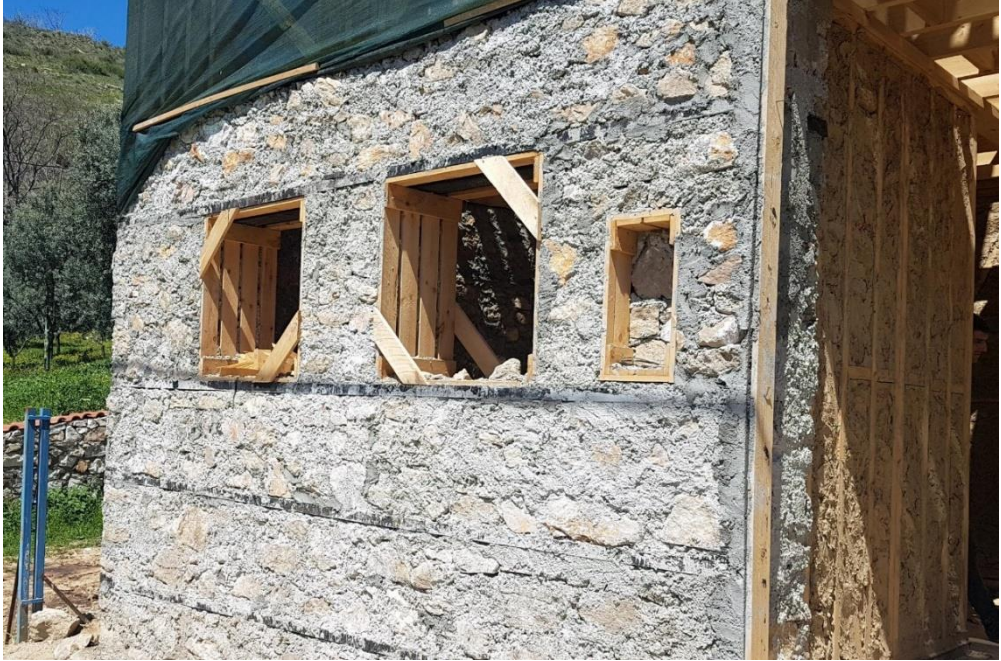
Resim 46 Taş duvarda pencere boşluğu açılması ve ahşap hatıllar
