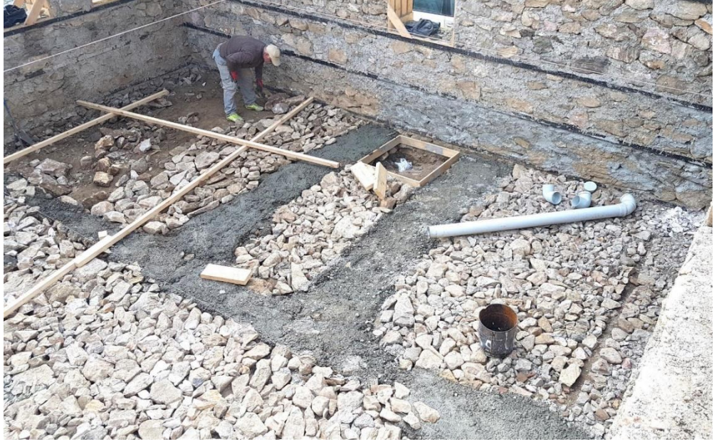
Resim 38 Temel inşası aşamaları
