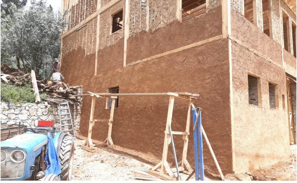
Resim 117 Taş ve ahşap duvar üzeri kerpiç sıvanın kaba aşaması
