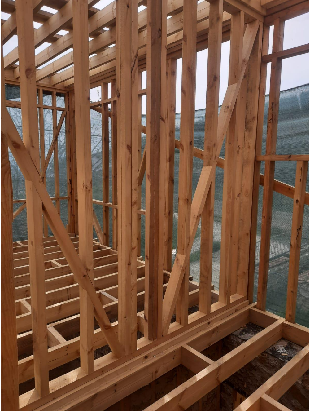
Resim 54 Ahşap karkas dikme ve döşeme ilişkisi
