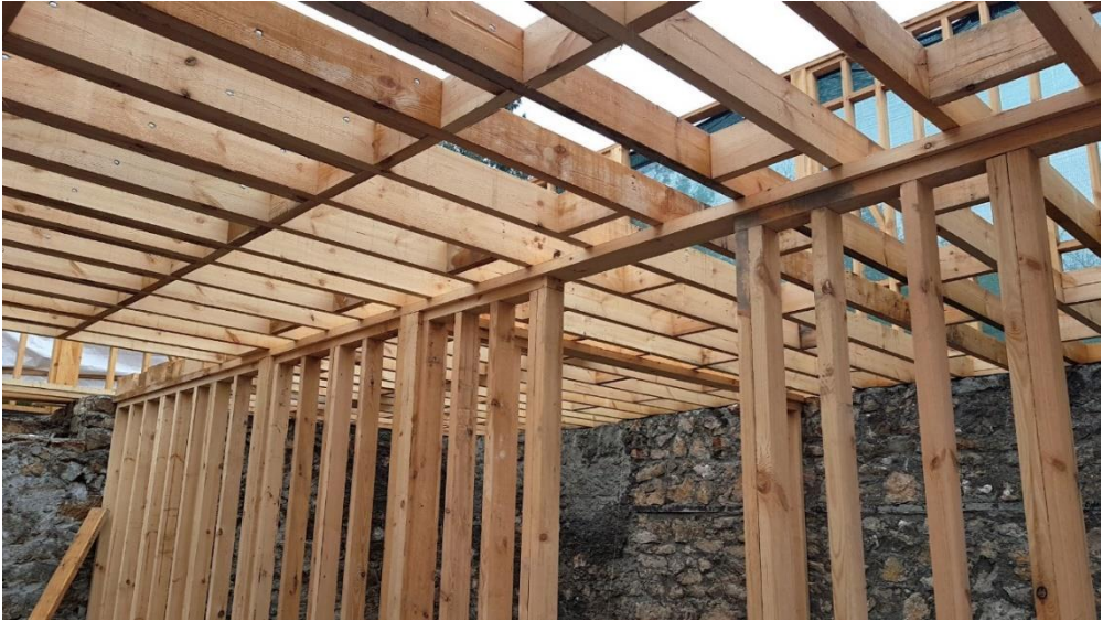
Resim 53 Ahşap karkas, duvar ve döşeme ilişkisi
