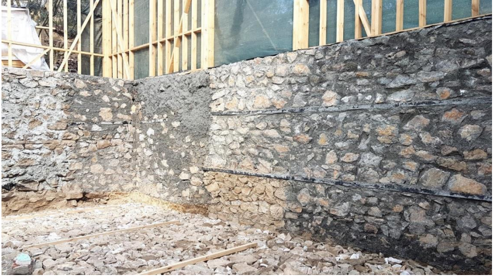
Resim 44 Eski evin duvarının güçlendirilmiş hali
