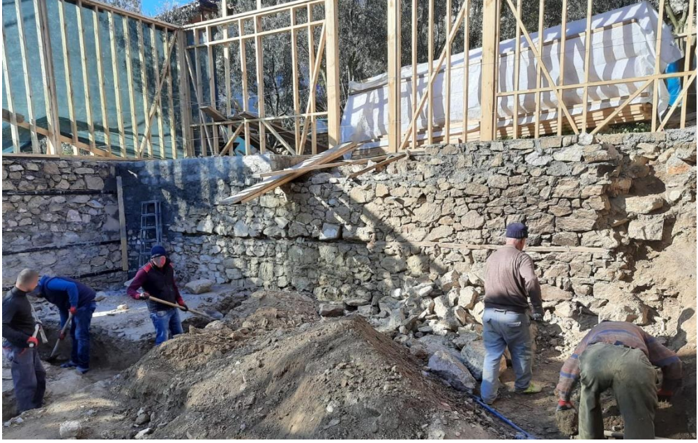
Resim 43 Eski evin duvarının güçlendirilmesi
