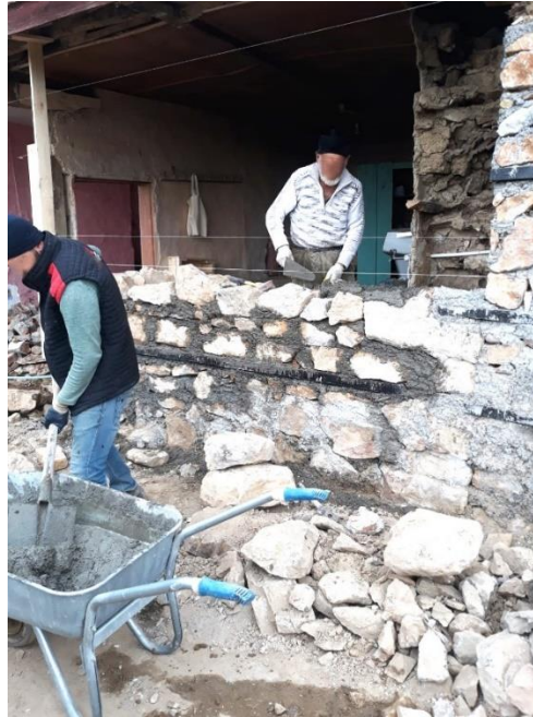
Resim 40 Taş duvar örülmesi
