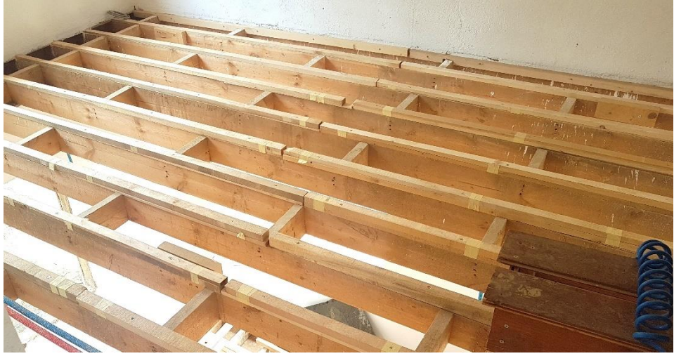
Resim 147 Mertek üzerine çıta çakılması
