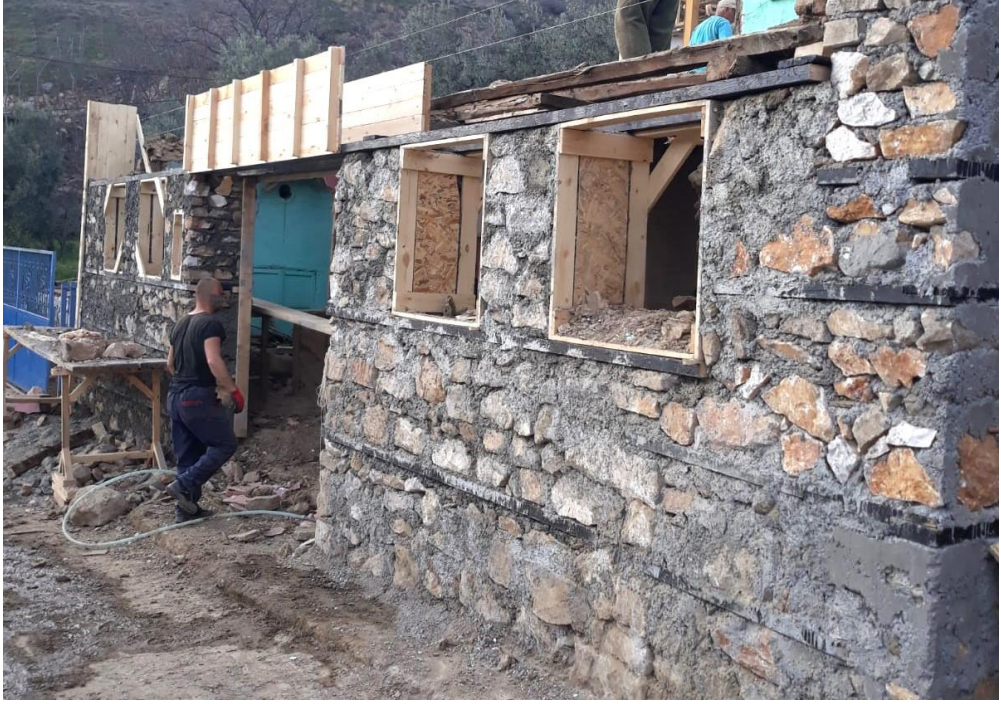
Resim 45 Taş duvarda pencere boşluğu açılması ve ahşap hatıllar
