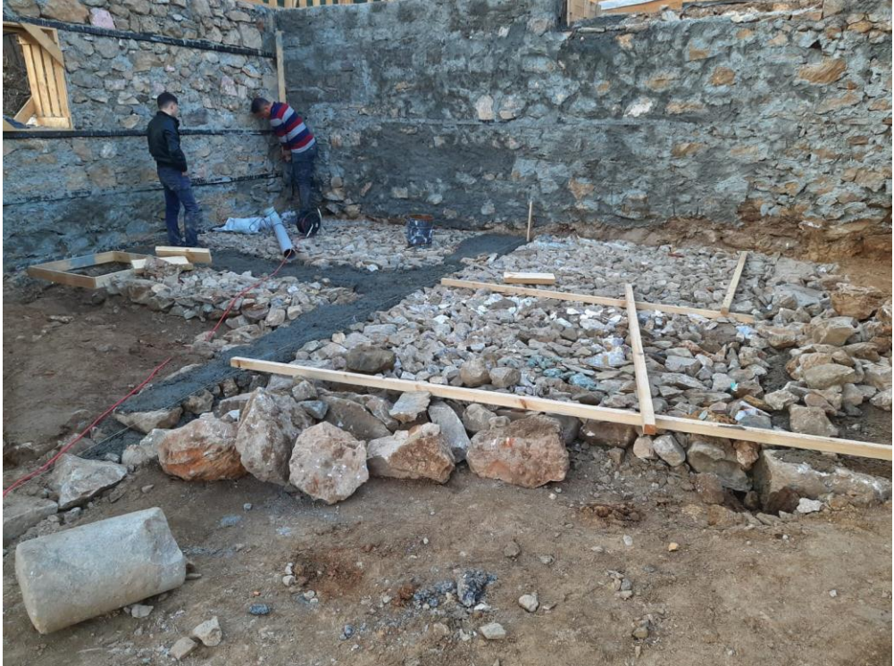
Resim 37 Temel inşası aşamaları
