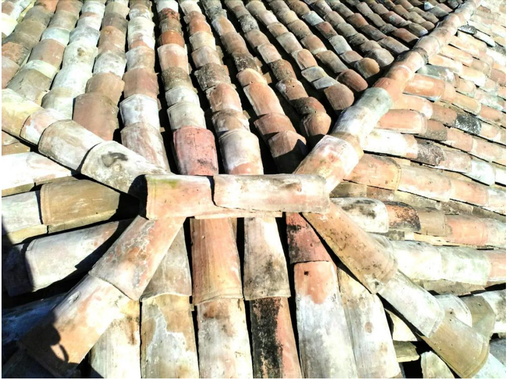
Resim 99 Kanallı bitümlü panel üstüne alaturka kiremit döşenmesi
