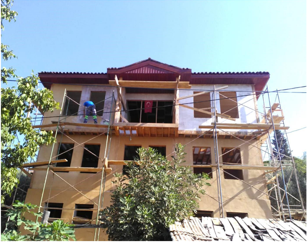
Resim 142 Kireç badananın sürülme işlemi
