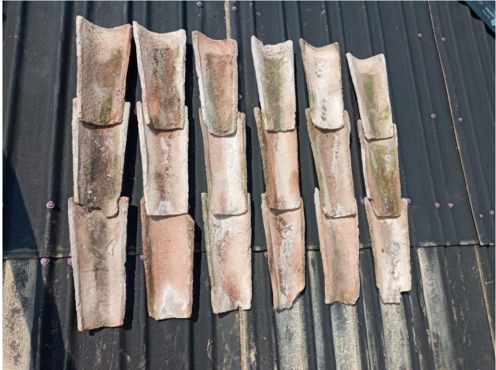
Resim 97 Kanallı bitümlü panel üstüne alaturka kiremit döşenmesi
