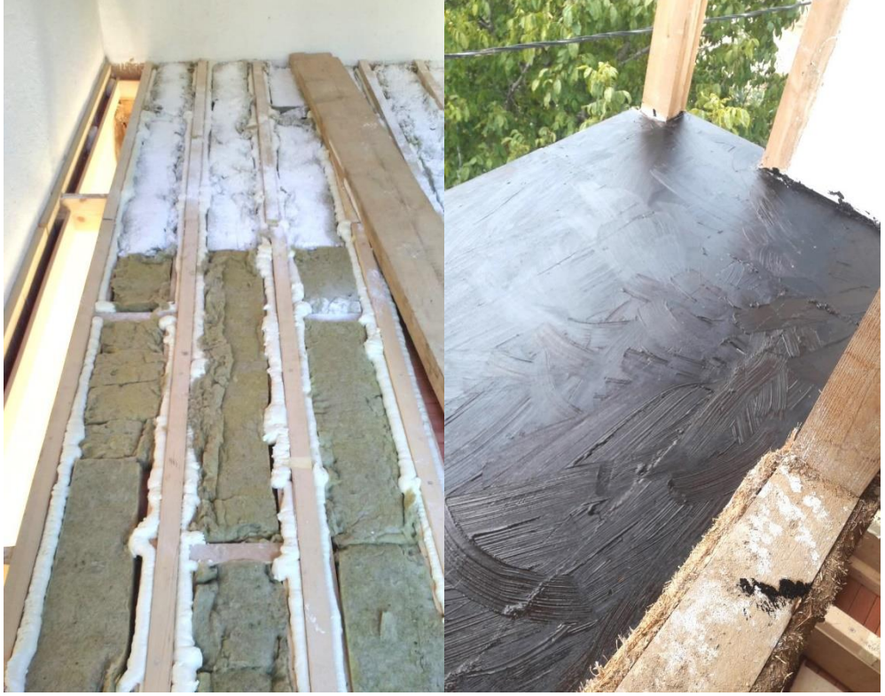
Resim 149 Mertek arasına taşyünü ve kireç konulması ve Balkon döşemesi altında likit membran sürülmüş kontra
