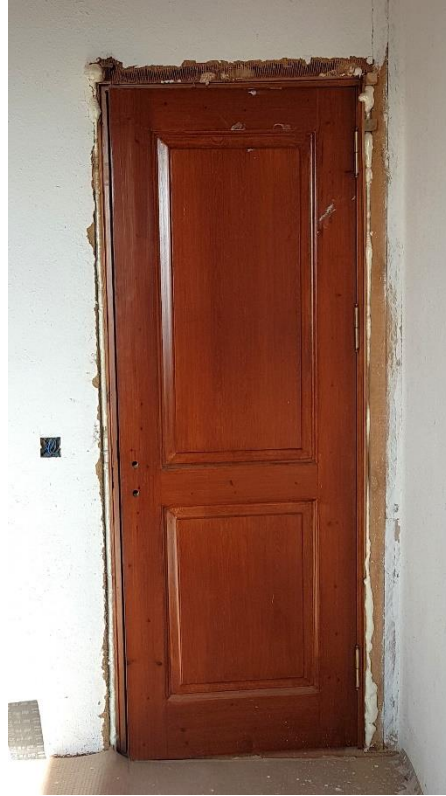
Resim 128 İç kapı ilk montajı
