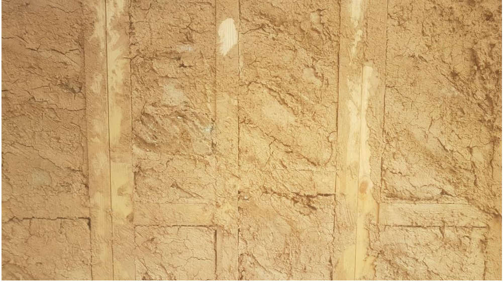
Resim 78 Kerpiç örüldükten sonra büzüşürse harç ile takviye edilmesi
