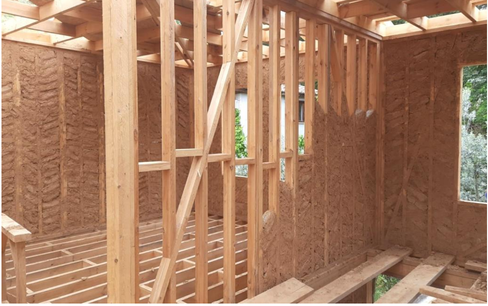
Resim 82 Ahşap karkas ve yarım kalmış kerpiç duvar örgü
