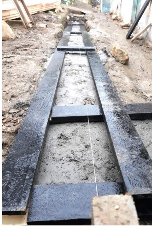
Resim 39 Taş duvarda kullanılan ahşap hatıllar
