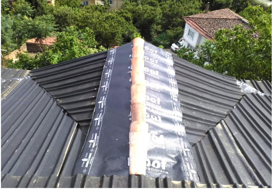
Resim 96 Kanallı bitümlü panel üstünde mahya omurgasında bitümlü membran
