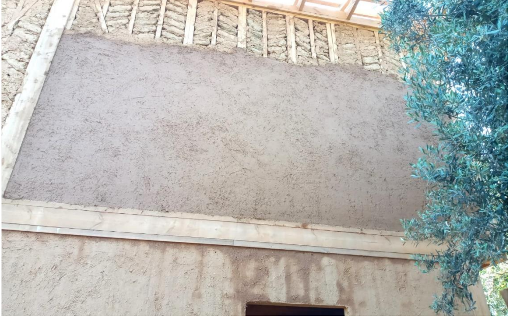
Resim 115 Ahşap duvar üzeri kerpiç sıvanın kaba aşaması
