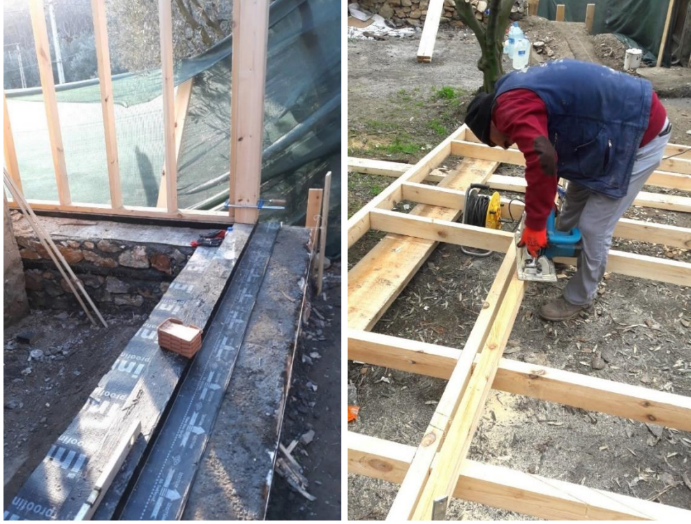
Resim 48 Ahşap malzemenin membran ile izolasyonu
