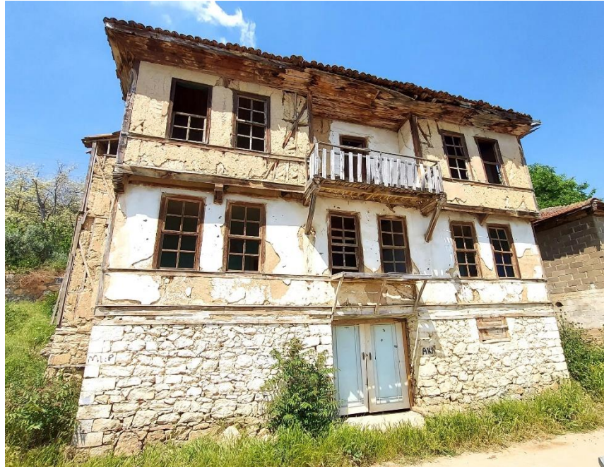
Resim 20 Alta katı taş, diğer 2 katı ahşap karkas arası kerpiç, ortada balkon üçlü cephe, ikili pencere düzeni
