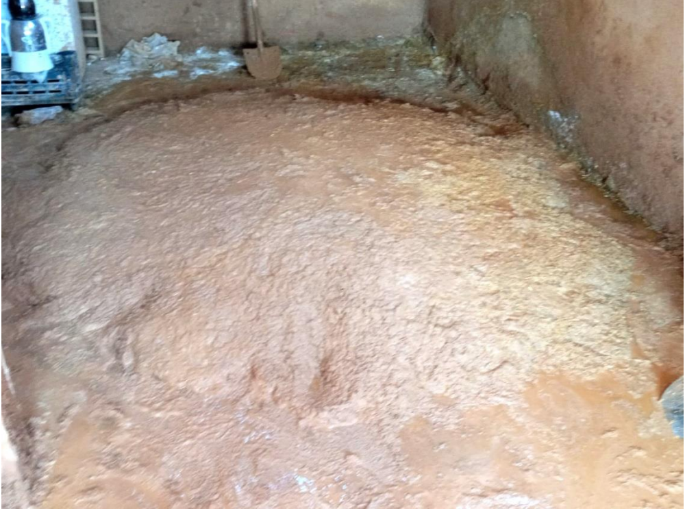
Resim 113 Kerpiç sıvanın hazırlandıktan sonra mayalanması için bekletilmesi
