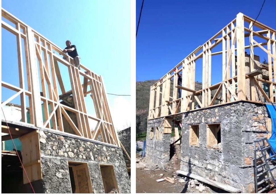
Resim 60 Taş duvar, ahşap karkas
