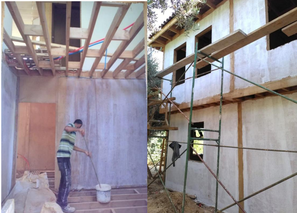
Resim 140 Kireç badananın sürülme aşaması
