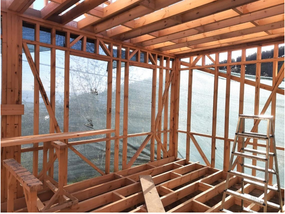
Resim 86 Ahşap döşeme ve tavan mertekleri ile ahşap duvar ilişkisi
