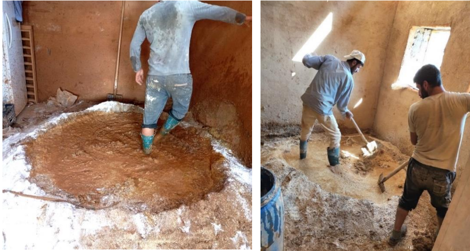
Resim 112 Kerpiç sıvanın hazırlanması
