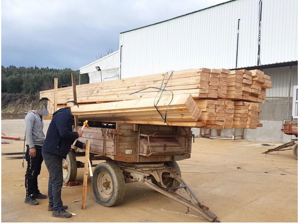
Resim 30 Kerestenin inşaat alanına nakli
