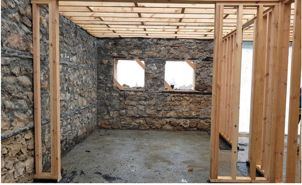
Resim 55 Taş duvar ve ahşap karkas ilişkisi
