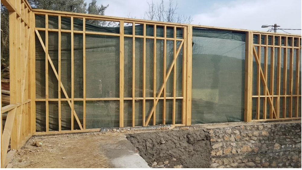
Resim 52 Yerine monte edilmiş ahşap karkas
