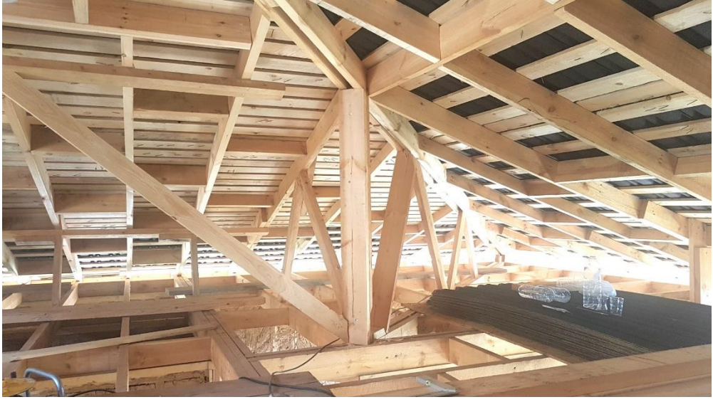
Resim 90 Çatı dikmeleri duvar ve taban üstlerine denk getirilmiştir
