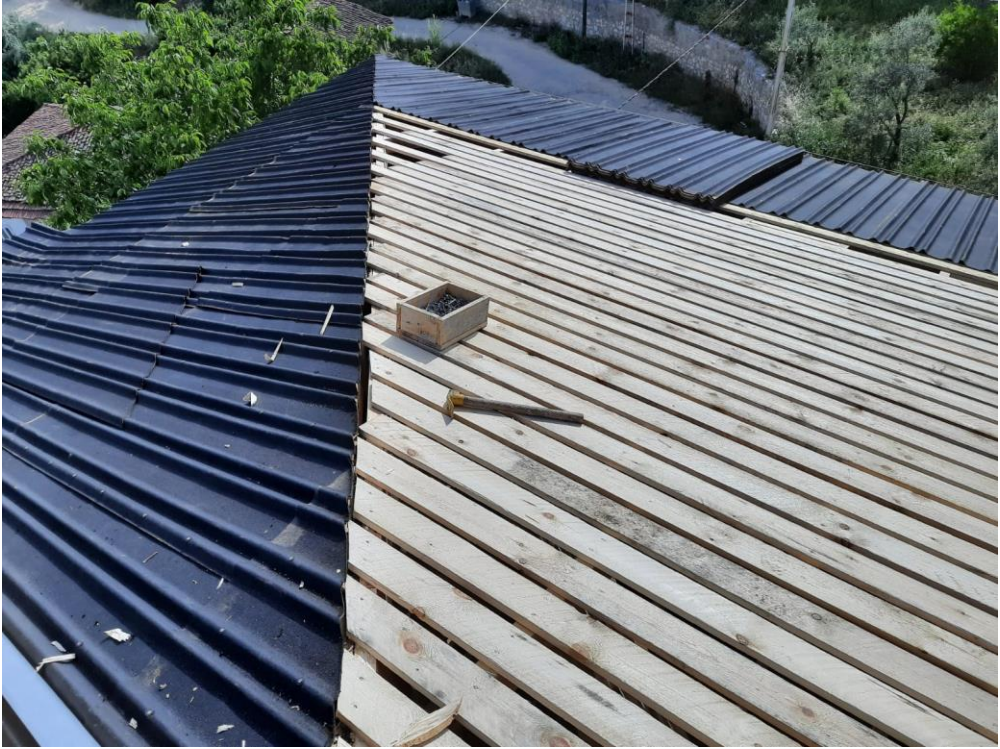
Resim 95 Kaplama tahtası üstünde kanallı bitümlü kiremit altı paneli
