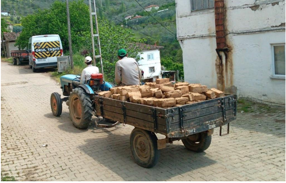
Resim 76 Üretilmiş kerpicin inşaat alanına taşınması
