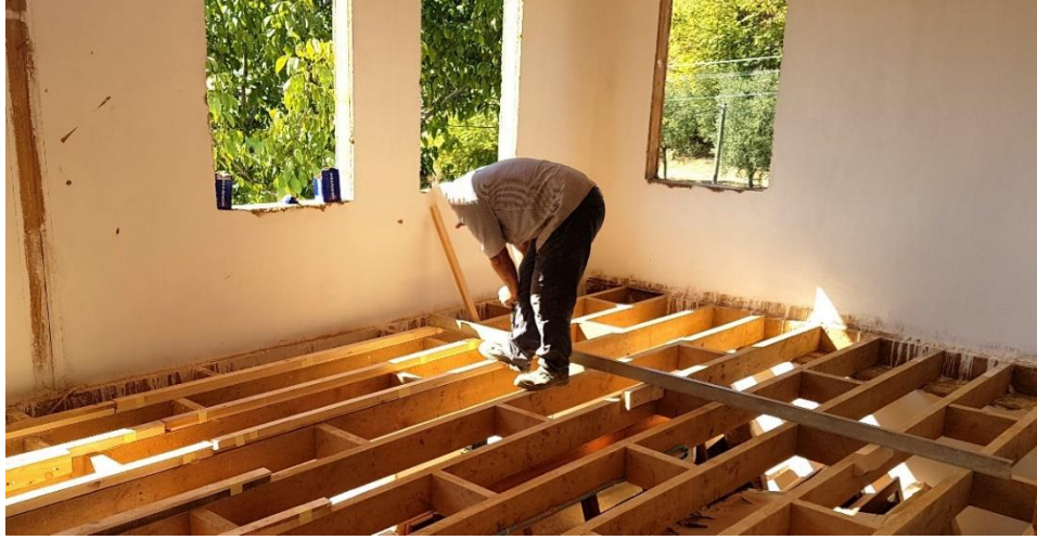
Resim 146 Mertek üzerine çıta çakılarak döşemenin teraziye alınması
