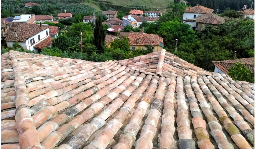
Resim 98 Alaturka kiremit (yıkılan eski binadan ve köyden toplandı)
