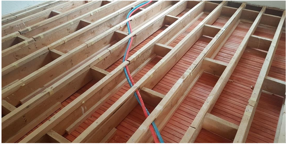
Resim 148 Mertek üzerine çakılan çıta ve tesisat borusu ilişkisi, altta tavan kaplaması
