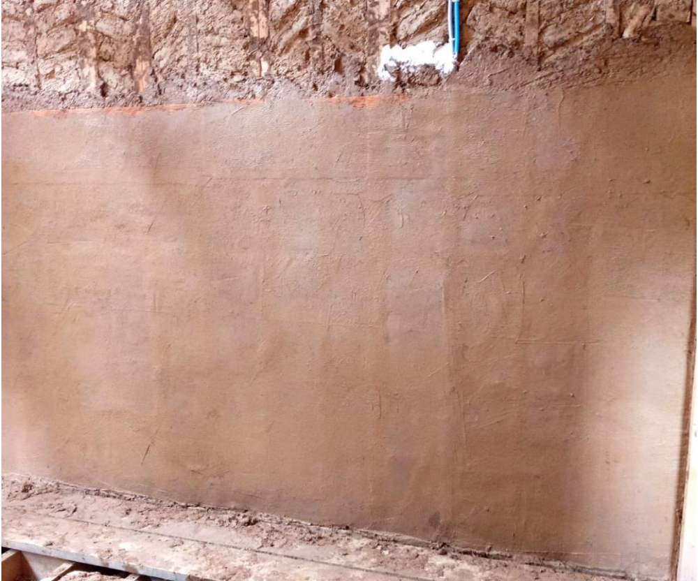
Resim 118 Ahşap duvar üzeri kerpiç sıvanın kaba aşaması, altta file bulunmaktadır
