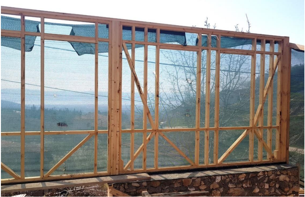
Resim 51 Montaj yapılmış ahşap duvar panelleri
