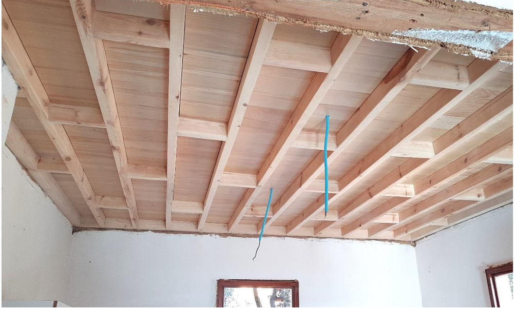
Resim 151 Mutfak üzeri bakkal tavan uygulaması
