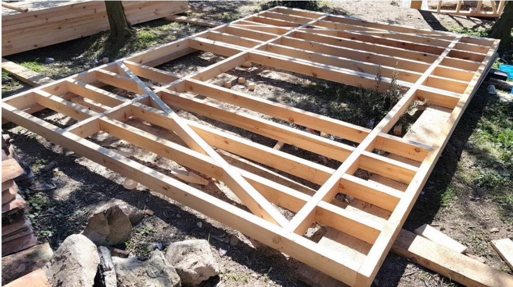
Resim 49 Yerde çakılmış ahşap duvar paneli
