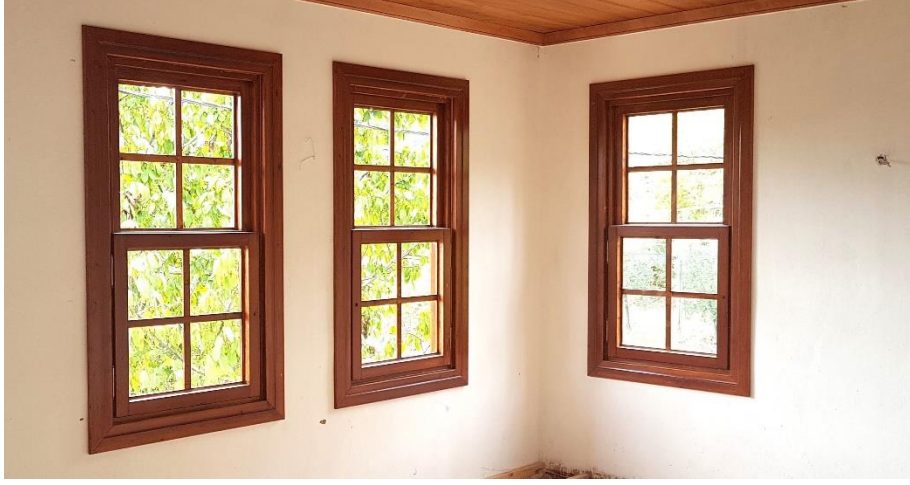
Resim 131 Pencerelelerin montajı, bire iki oranı ve giyotin görünümlü kanatlı
