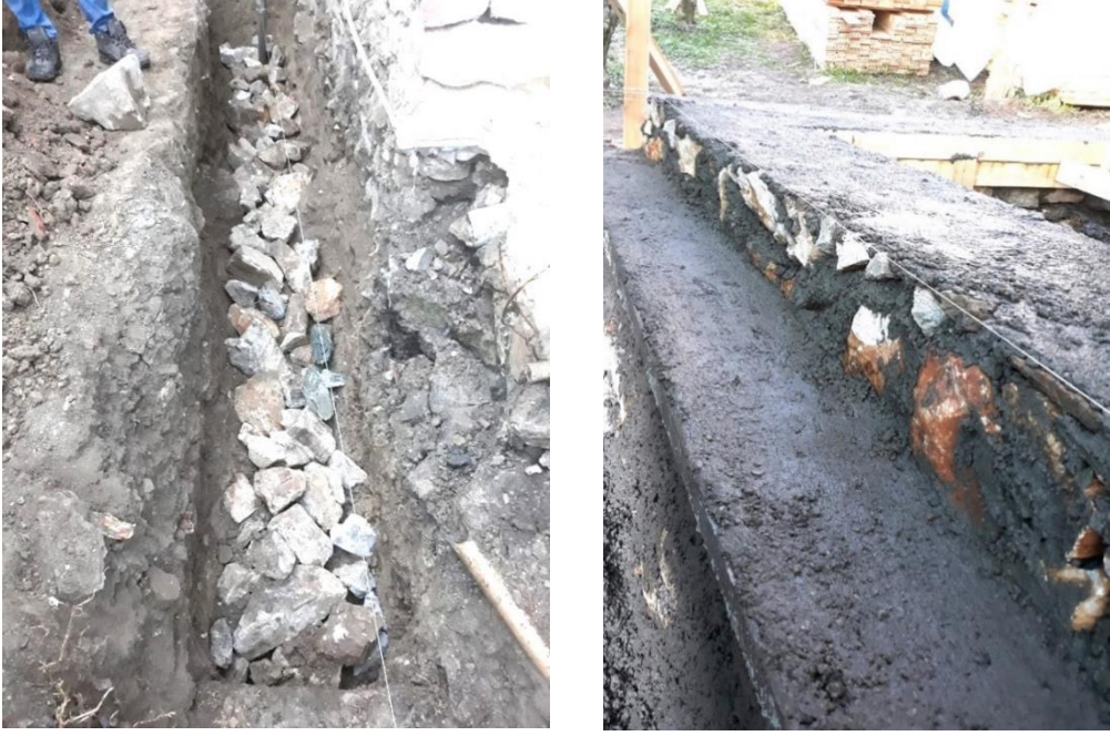
Resim 36 Temel inşası aşamaları
