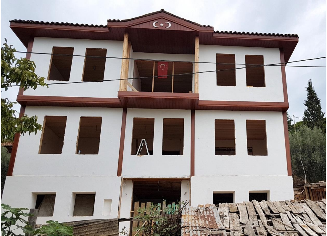
Resim 145 Kireç badananın son kat sürülme işlemi bitmiş hali
