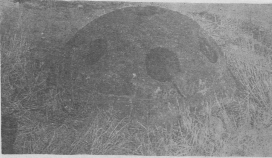
Resim 15 — Kayseri Kadı Hamamı'nın erkekler kısmında, yekpare taştan oyulmuş ışık kubbeciklerinden biri
