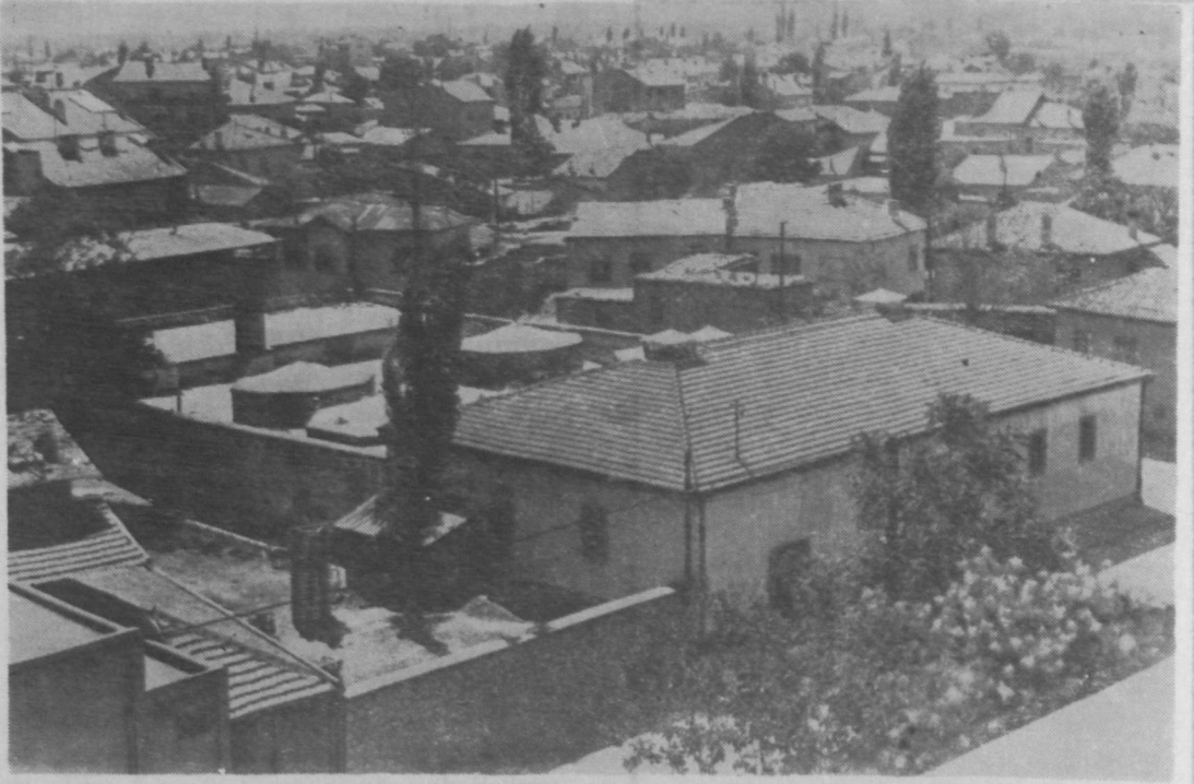
Resim 1 — Konya'da Sahib Ata (Sultan) Hamamı'nda soyunma mahallerinin örtüleri ile aydınlık fenerlerinin 1962 yılı onarımından sonraki durumu
