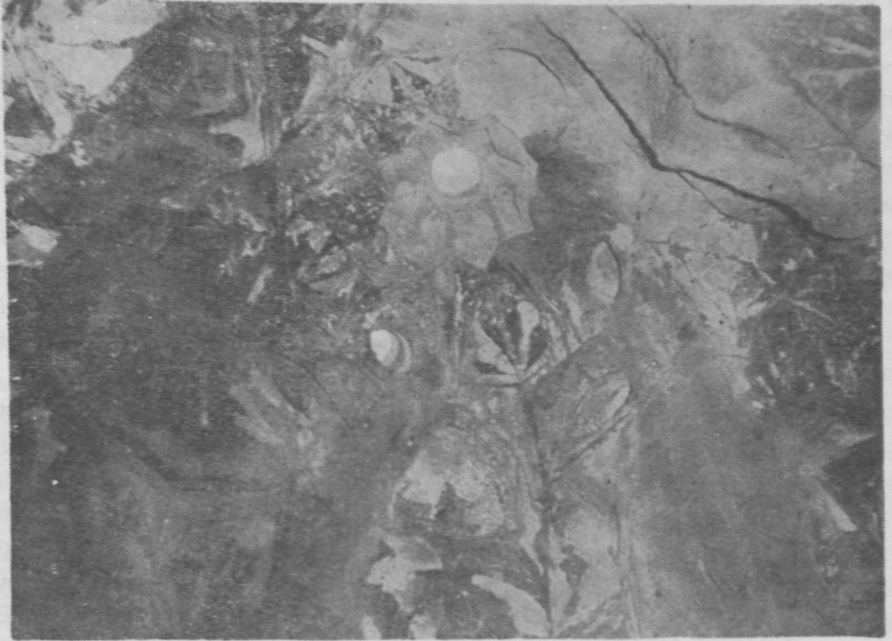
Resim 15 — Kayseri Kadı Hamamı'nın erkekler kısmında, yekpare taştan oyulmuş ışık kubbeciklerinden biri
