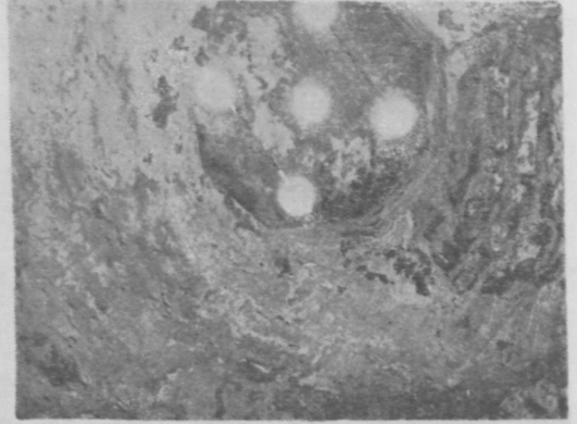
Resim 19 — Kayseri Erkilet Mehmet Paşa Hamamı'nın sıcaklık mahalli kubbesindeki ışık tavanı (Bugün mevcut değildir.)
