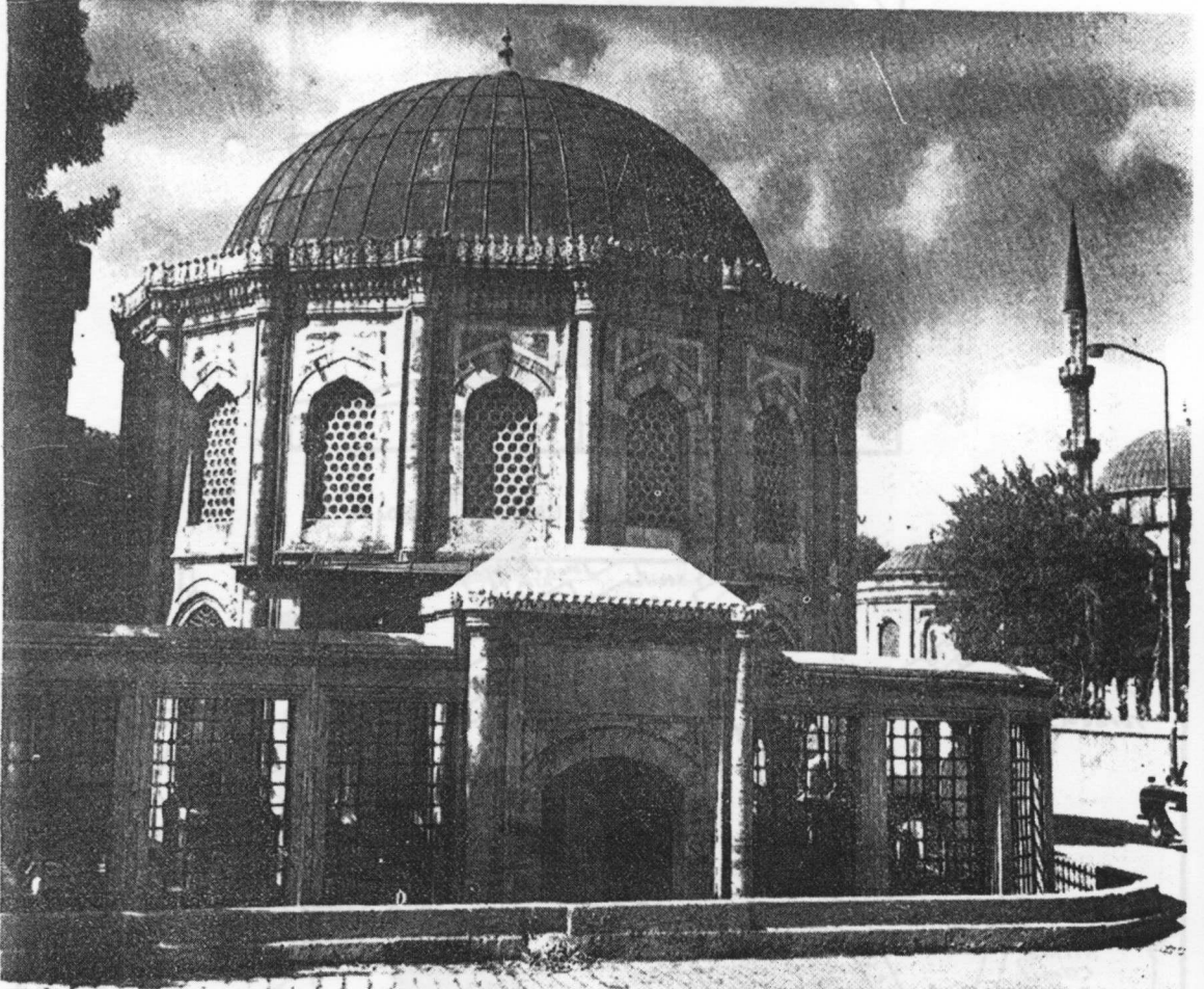
Res. 1 — Eyüp'te Ferhat Paşa Türbesi.
