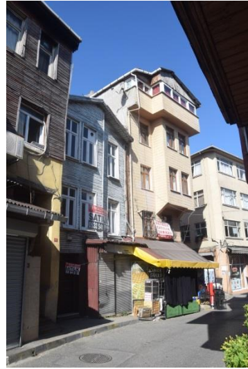
Fotoğraf 184. Yapı No:25 (Güzelaydın, Ağustos 2021)
