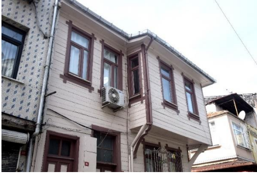
Şekil 4.64 2186 ada 24 parseldeki konutun cephesinde tesisat kabloları ve klima ünitesi, Yapı No: 18 (Güzelaydın, 2022)
