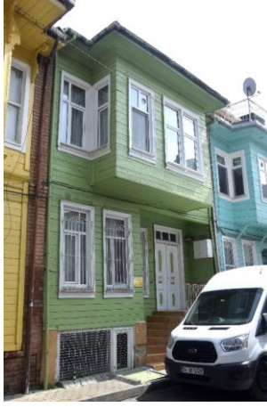
Şekil 122. Yapı No:16 (Güzelaydın, Mart 2022)
