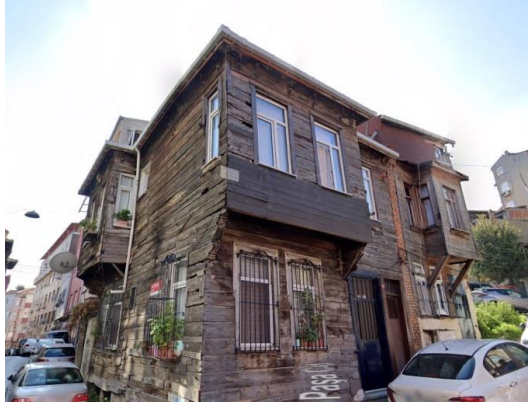
Şekil 3. Yapı No:01 (Google Earth, Ekim 2019)
