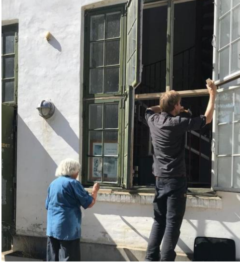
Şekil 2.7 Ahşap doğramaların yağlanması (Url-40)
