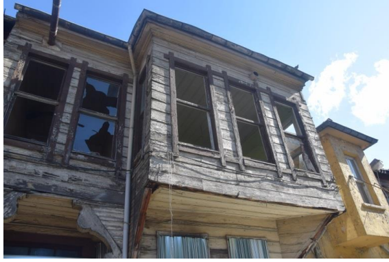
Fotoğraf 207. Yapı No:28
