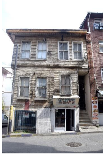
Şekil 164. Yapı No:22 (Güzelaydın, Mart 2022)
