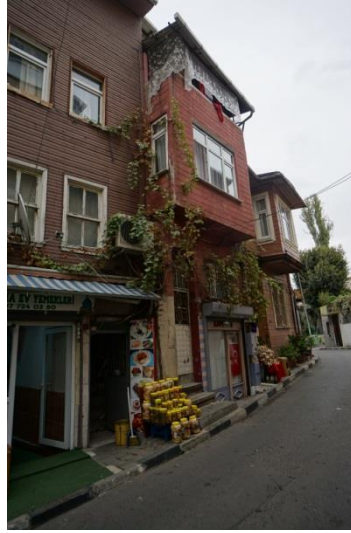
Fotoğraf 175. Yapı No:24
