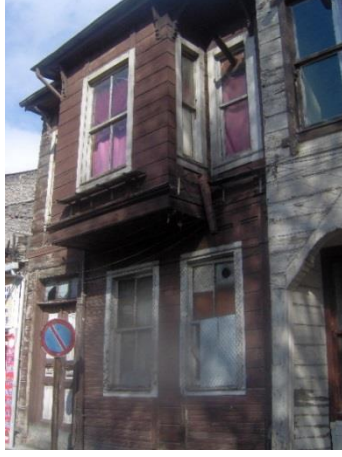
Fotoğraf 193. Yapı No:27 (Fatih Belediyesi CBS, t.b.)
