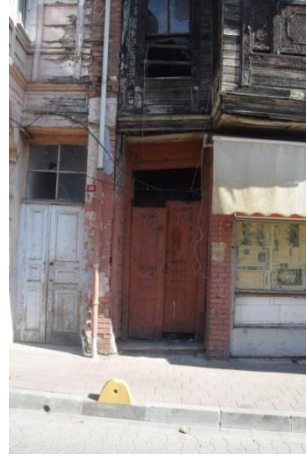
Fotoğraf 233. Yapı No:31 (Güzelaydın, Ağustos 2021)
