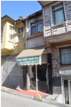
Fotoğraf 224. Yapı No:30 (Güzelaydın, Ağustos 2021)
