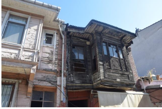
Fotoğraf 234. Yapı No:31 (Güzelaydın, Ağustos 2021)
