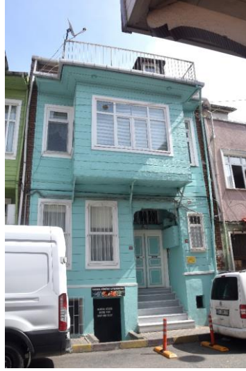
Şekil 129. Yapı No:17 (Güzelaydın, Mart 2022)
