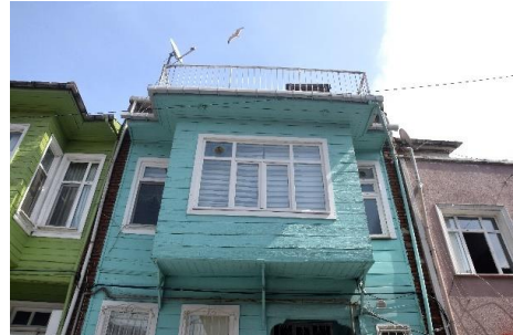
Şekil 4.57 1021 ada 4 parseldeki konutun 1. kat cephesinde değiştirilen pencere boşluğu (Güzelaydın, 2022)
