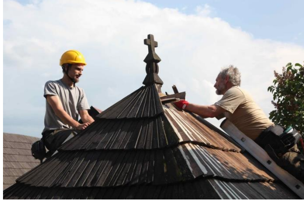
Şekil 2.10 Çatı kaplamasında bakım ve onarım çalışması (Url-47)
