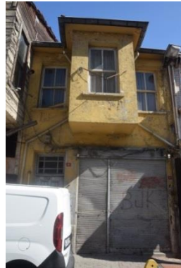
Fotoğraf 215. Yapı No:29 (Güzelaydın, Ağustos 2021)
