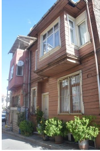
Fotoğraf 191. Yapı No:26 (Güzelaydın, Ağustos 2021)
