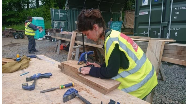
Şekil 2.3 SPAB koruma uygulaması (Url-52)
