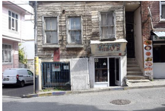
Şekil 165. Yapı No:22 (Güzelaydın, Mart 2022)
