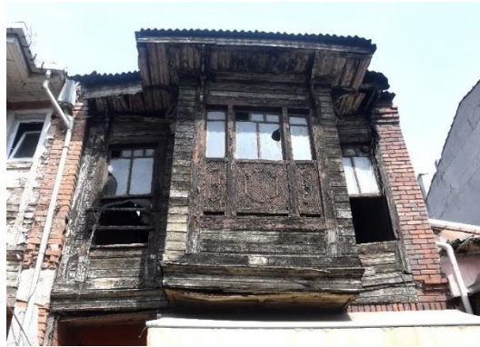
Şekil 4.47 Bakımsızlık nedeniyle yok olmaya yüz tutan ahşap pencere ve kafes detayı, Yapı No: 31 (Güzelaydın, 2022)
