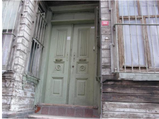
Şekil 20. Yapı No:03 (Fatih Belediyesi Arşivi)
