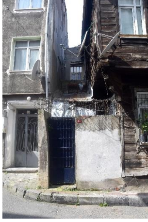
Şekil 4.58 2197 ada 17 parseldeki konutun güney cephesine bitişik ek yapı, Yapı No: 1 (Güzelaydın, 2022)
