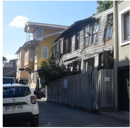
Şekil 68. Yapı No:09 (Güzelaydın, Ağustos 2021)
