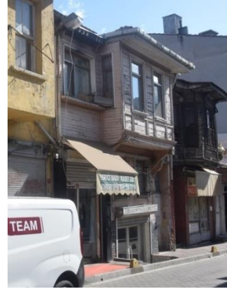
Fotoğraf 223. Yapı No:30 (Güzelaydın, Ağustos 2021)
