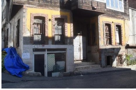
Şekil 4.54 Bölümlenerek dükkan haline getirilmiş ve cephesi değiştirilmiş yarı bodrum kat, Yapı No: 06 (Güzelaydın, 2021)
