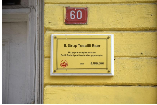
Şekil 3.11 Cephe sağlıklılaştırma çalışması yürütülen yapıların üzerindeki tabela (Güzelaydın, 2022)
