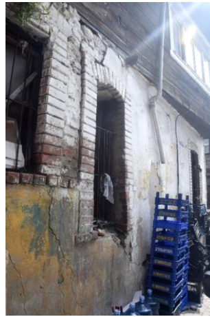
Şekil 51. Yapı No:06 (Güzelaydın, Ağustos 2022)
