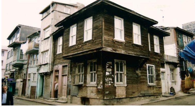
Şekil 131. Yapı No:18 (Kayan, 1999, s.131)
