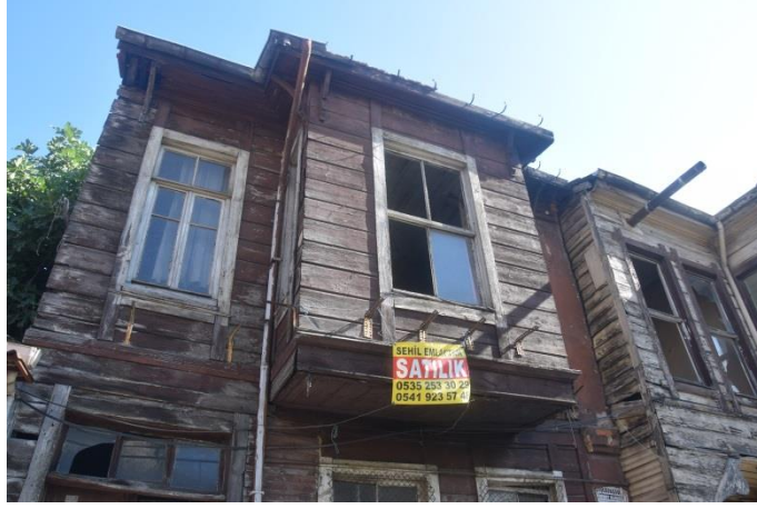
Fotoğraf 199. Yapı No:27 (Güzelaydın, Ağustos 2021)
