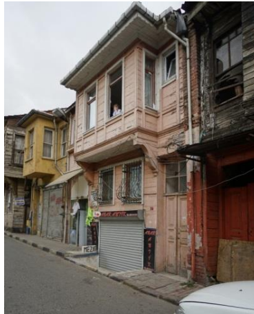
Fotoğraf 219. Yapı No:30
