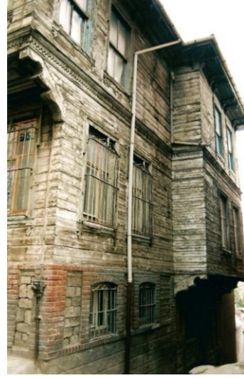
Şekil 18. Yapı No:03 (Kayan, 1999, s.89)
