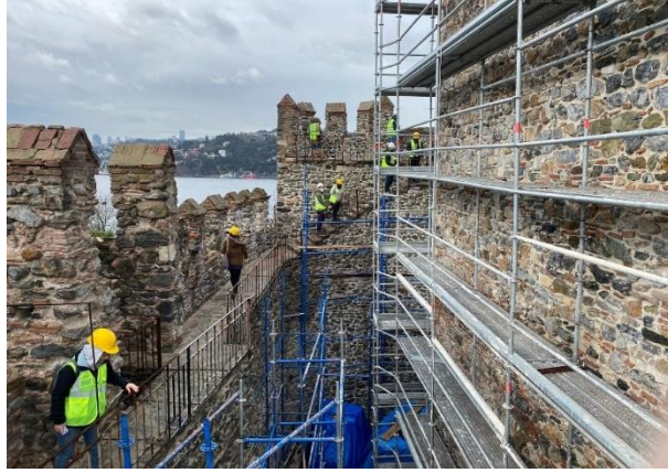
Şekil 3.9 İBB Miras Projesi kapsamında düzenlenen şantiye gezileri (Url-30)
