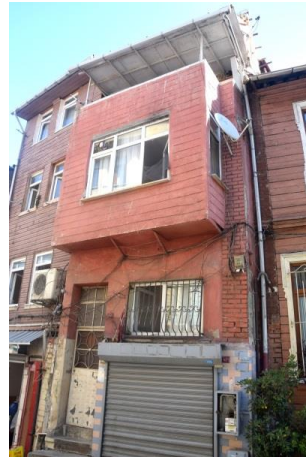
Fotoğraf 180. Yapı No:24 (Güzelaydın, Ağustos 2021)
