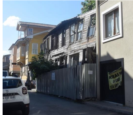
Şekil 63. Yapı No:08 (Güzelaydın, Ağustos 2021)
