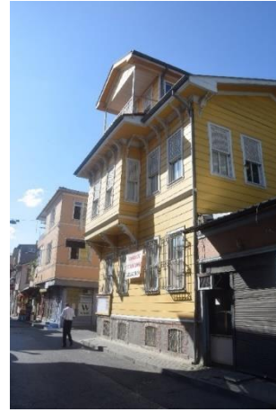
Şekil 4.50 Yakın zamanda restore edilen bir yapı, Yapı No: 10 (Güzelaydın, 2021)
