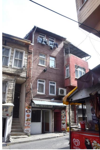
Şekil 173. Yapı No:23 (Güzelaydın, Mart 2022)
