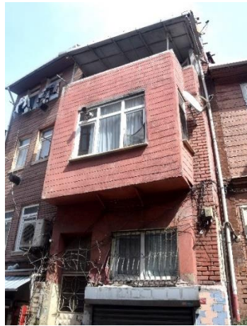
Şekil 4.53 1019 ada 21 parseldeki konutun sıva ile ahşap görünümü verilmiş cephesi ve teras haline getirilen ek kat, Yapı No: 24 (Güzelaydın, 2022)
