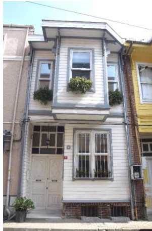
Şekil 99. Yapı No:13 (Güzelaydın, Mart 2022)
