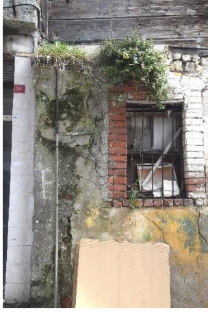
Şekil 4.43 2198 ada 1 parseldeki konutun cephesinde bitki oluşumu, Yapı No: 06 (Güzelaydın, 2022)
