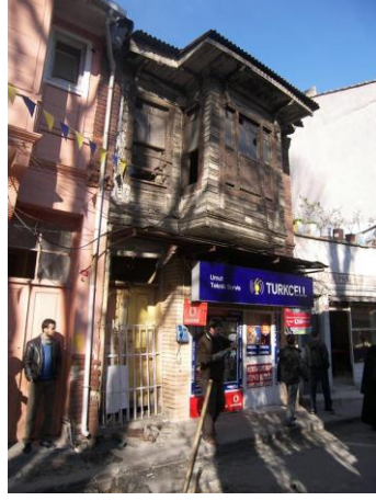
Fotoğraf 226. Yapı No:31 (Fatih Belediyesi CBS, t.b.)
