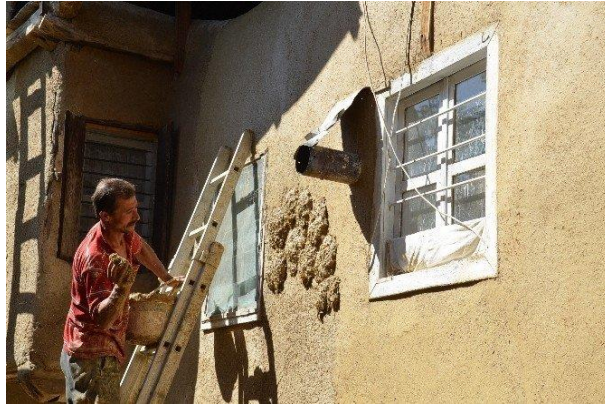
Şekil 1.3 Kerpiç cephede sıva yenileme işlemi (Url-21)
