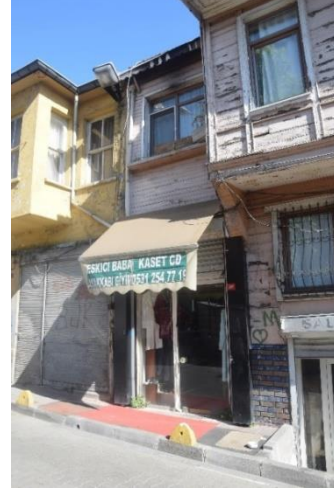
Şekil 4.29 Ek yapı (Yapı No: 30)
