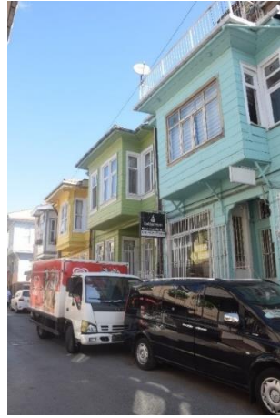
Şekil 4.49 Sokak sağlıklaştırma çalışmasında yenilenen cepheler, Yapı No: 13, 14, 15 (Güzelaydın, 2021)
