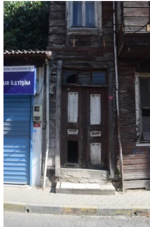
Fotoğraf 198. Yapı No:27 (Güzelaydın, Ağustos 2021)
