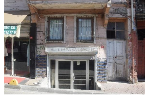
Şekil 4.55 Bölümlenerek dükkan haline getirilmiş ve cephesi değiştirilmiş yarı bodrum kat, Yapı No: 30 (Güzelaydın, 2021)
