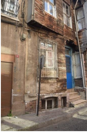
Şekil 14. Yapı No:02 (Güzelaydın, Ağustos 2021)
