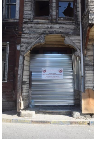
Fotoğraf 208. Yapı No:28
