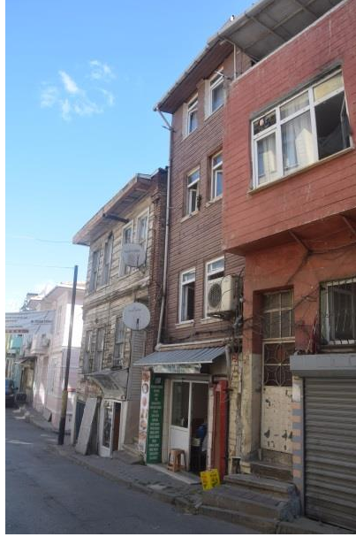
Şekil 172. Yapı No:23 (Güzelaydın, Ağustos 2021)
