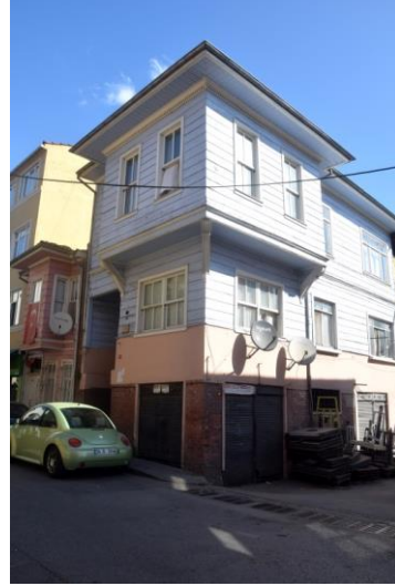
Şekil 90. Yapı No:12 (Güzelaydın, Ağustos 2021)
