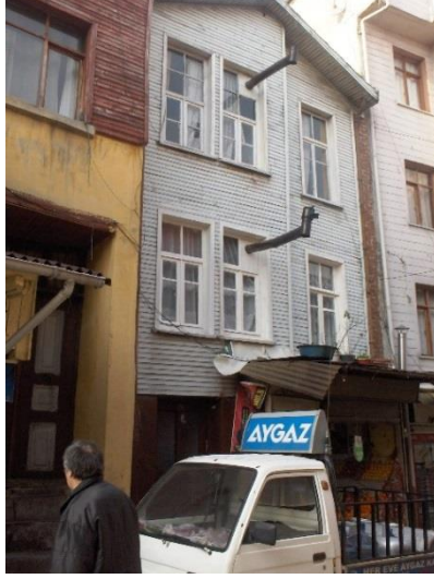
Fotoğraf 181. Yapı No:25 (Fatih Belediyesi CBS, t.b.)
