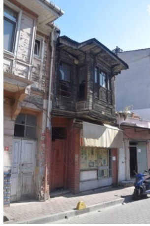
Fotoğraf 232. Yapı No:31 (Güzelaydın, Ağustos 2021)
