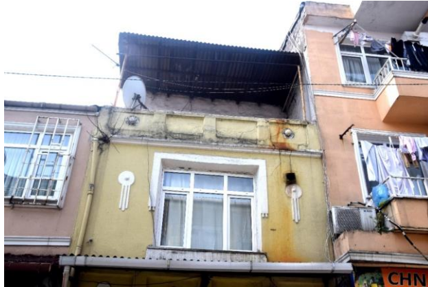
Şekil 114. Yapı No:15 (Güzelaydın, Mart 2022)
