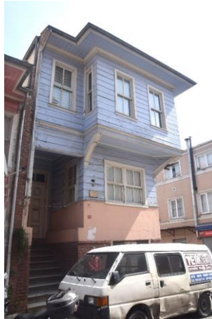
Şekil 91. Yapı No:12 (Güzelaydın, Mart 2022)
