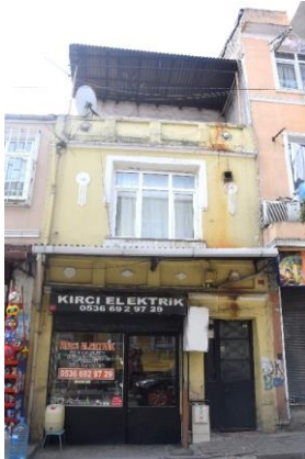
Şekil 113. Yapı No:15 (Güzelaydın, Mart 2022)
