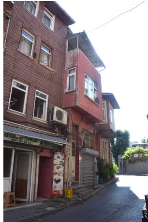
Fotoğraf 179. Yapı No:24 (Güzelaydın, Ağustos 2021)
