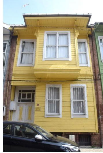
Şekil 108. Yapı No:14 (Güzelaydın, Mart 2022)
