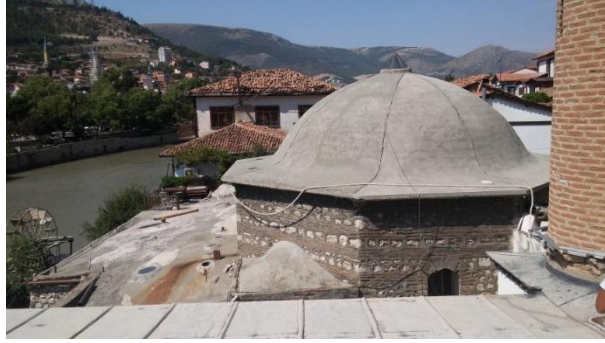
Şekil 3.13 Kurşun malzeme görünümü verilmiş şap ile kaplanmış 1510 tarihli Amasya Yıldız Hamamı (FSMVÜ KURAM Arşivi)
