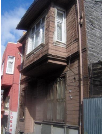
Fotoğraf 185. Yapı No:26 (Fatih Belediyesi CBS, t.b.)
