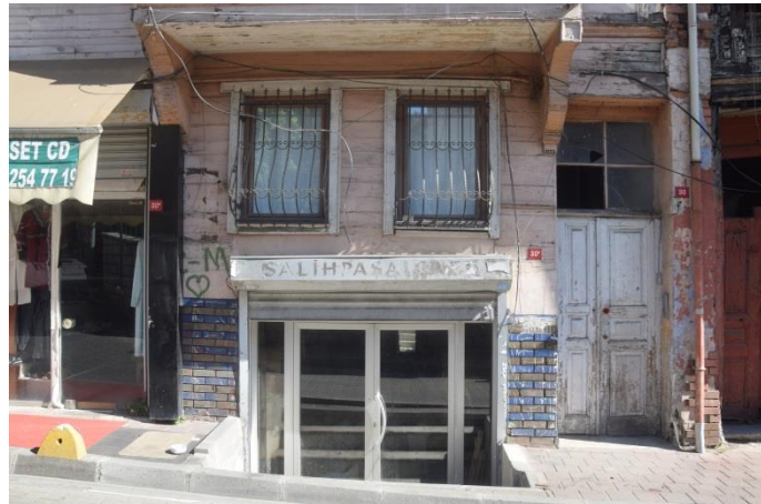
Fotoğraf 225. Yapı No:30 (Güzelaydın, Ağustos 2021)
