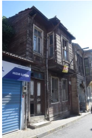
Fotoğraf 197. Yapı No:27 (Güzelaydın, Ağustos 2021)
