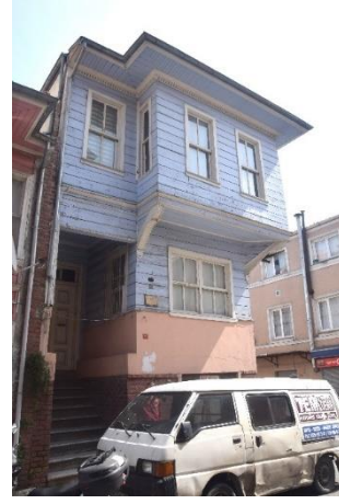
Şekil 4.52 1021 ada 9 parselde bulunan konutun sokak sağlıklaştırma çalışmasında yenilenen cephesinin günümüzdeki durumu, Yapı No: 12 (Güzelaydın, 2022)
