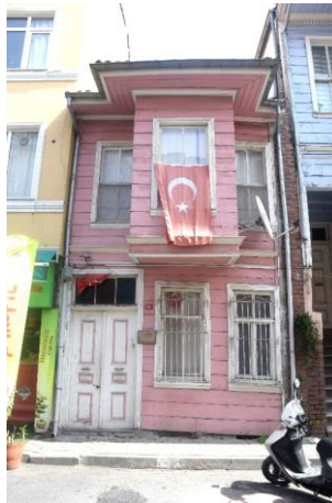
Şekil 81. Yapı No:11 (Güzelaydın, Mart 2022)
