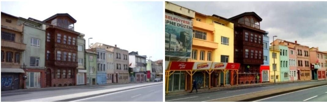
Şekil 3.7 Fatih Belediyesi tarafından Ayvansaray Caddesi’nde yürütülen cephe sağlıklılaştırma çalışmalarının aşamaları (Url-72)
