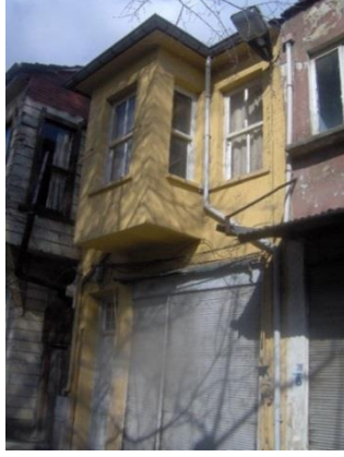
Fotoğraf 211. Yapı No:29 (Fatih Belediyesi CBS, t.b.)
