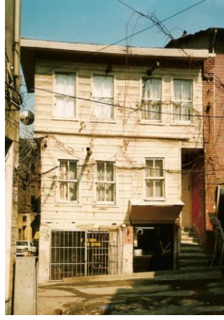
Şekil 157. Yapı No:22 (Kayan, 1999, s.121)
