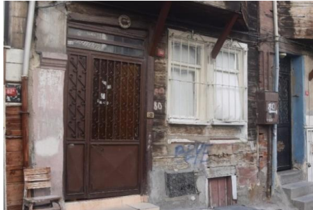
Şekil 4.56 2198 ada 5 parseldeki konutun zemin kat cephesinde değiştirilen kapı ve pencere boşlukları (Güzelaydın, 2022)
