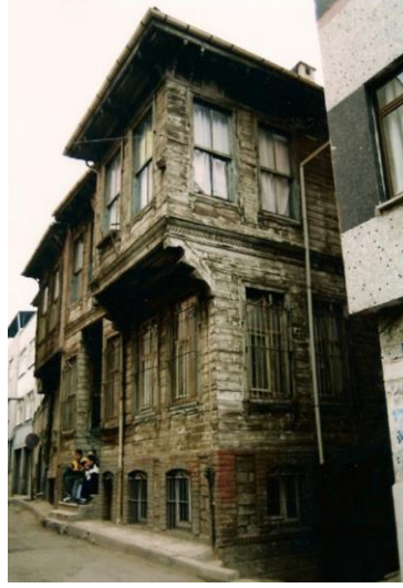
Şekil 17. Yapı No:03 (Kayan, 1999, s.89)
