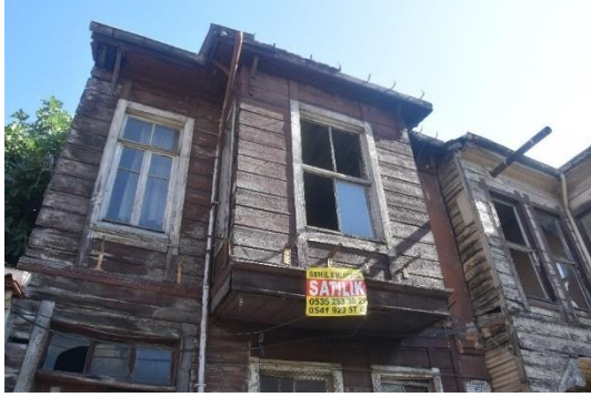
Şekil 4.37 1019 ada 17 parseldeki konutta
