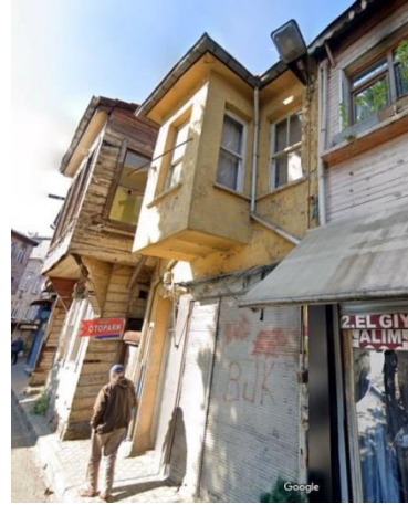
Fotoğraf 214. Yapı No:29 (Güzelaydın, Ağustos 2021)
