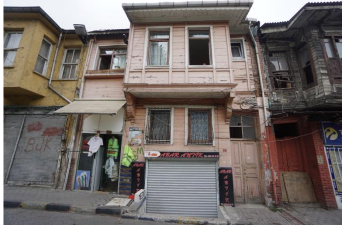
Fotoğraf 218. Yapı No:30
