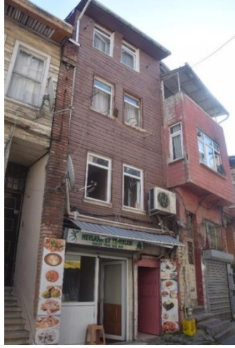
Şekil 4.28 Ek kat (Yapı No: 23)
