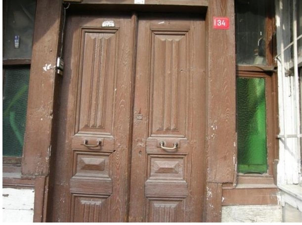
Fotoğraf 202. Yapı No:28 (Fatih Belediyesi CBS, t.b.)
