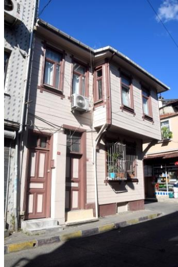
Şekil 138. Yapı No:18 (Güzelaydın, Ağustos 2021)
