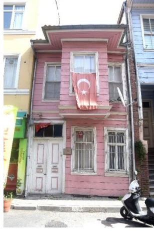
Şekil 4.51 1021 ada 10 parselde bulunan konutun sokak sağlıklaştırma çalışmasında yenilenen cephesinin günümüzdeki durumu, Yapı No: 11 (Güzelaydın, 2022)
