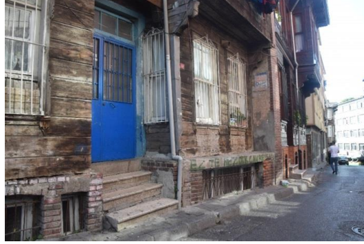
Şekil 4.61 Muhdes çelik kapı ve PVC yağmur suyu iniş borusu, Yapı No: 02 (Güzelaydın, 2022)
