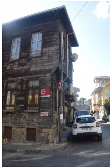
Şekil 4.23 1021 ada 12 parselde bulunan kagir bodrum kat üzeri ahşap iskelet yapı (Yapı No: 7)
