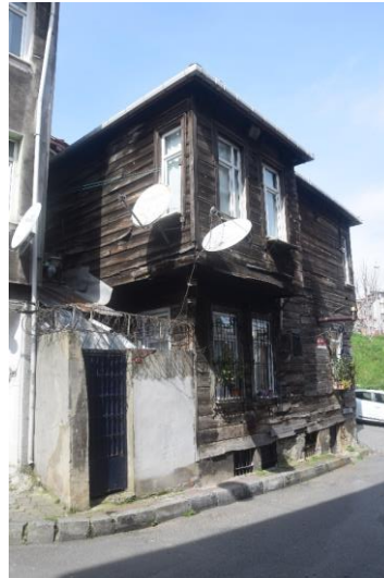
Şekil 7. Yapı No:01 (Güzelaydın, Mart 2022)
