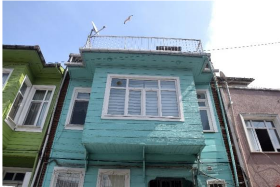
Şekil 130. Yapı No:17 (Güzelaydın, Mart 2022)
