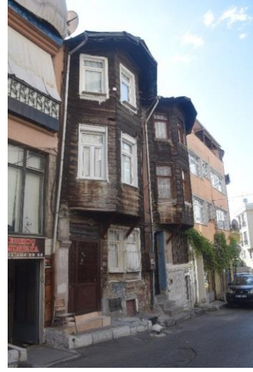
Şekil 32. Yapı No:04 (Güzelaydın, Ağustos 2021)
