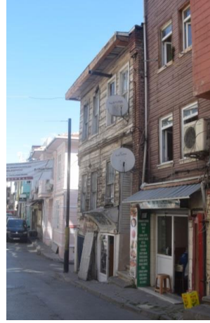
Şekil 163. Yapı No:22 (Güzelaydın, Ağustos 2021)
