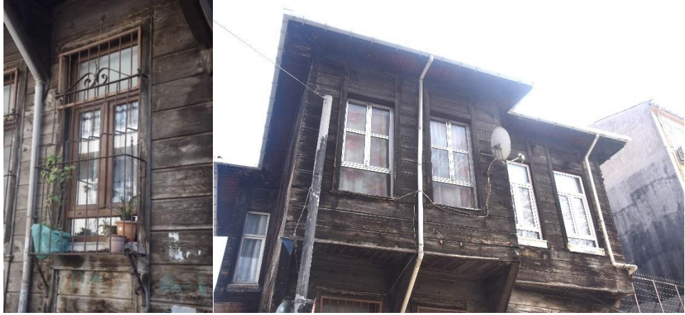
Şekil 4.60 1021 ada 12 parseldeki konutun değiştirilen zemin ve 1. kat doğramaları, Yapı No: 07 (Güzelaydın, 2022)
