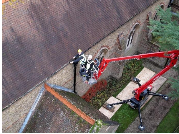
Şekil 2.9 Çatı oluk temizliği (Url-48)
