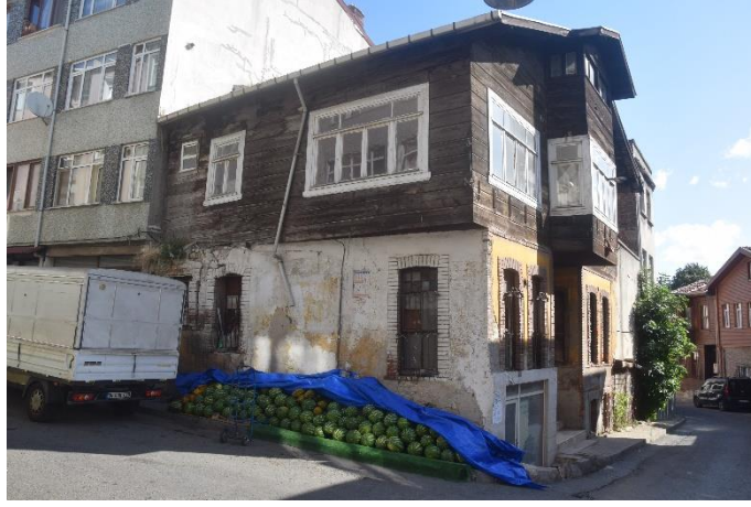
Şekil 48. Yapı No:06 (Güzelaydın, Ağustos 2021)
