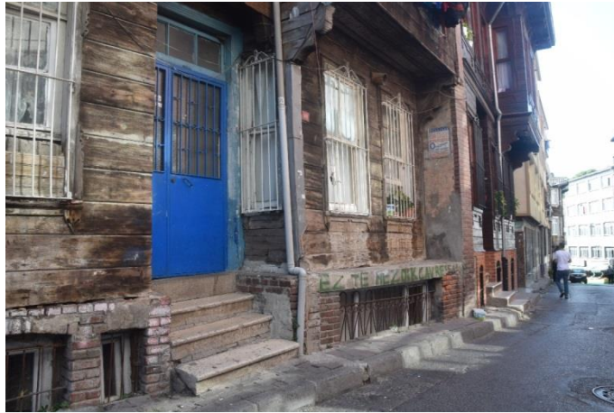
Şekil 16. Yapı No:02 (Güzelaydın, Ağustos 2021)
