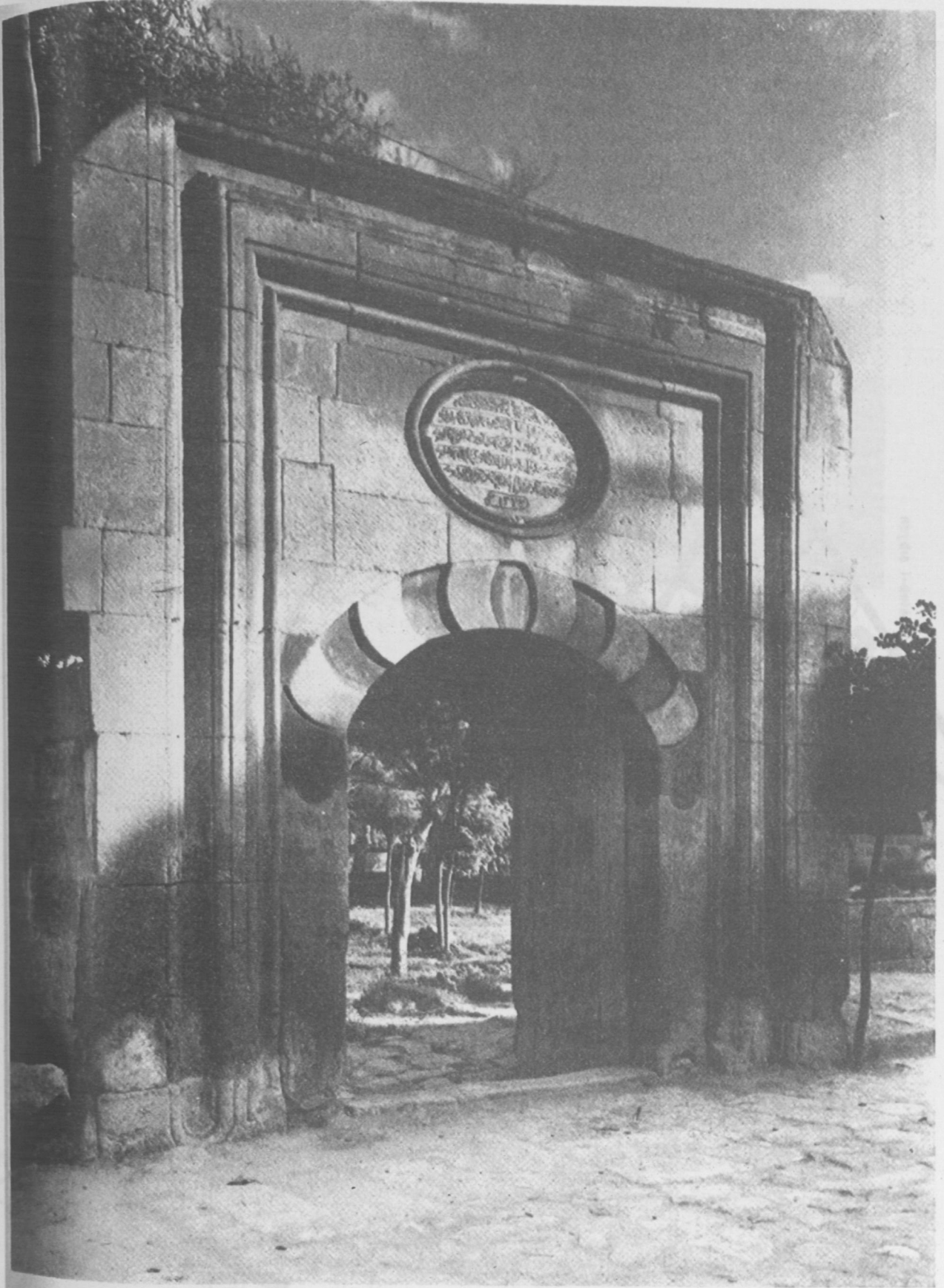
Resim: 16 — Camii avlusunun tamir kitabeli kapısı.
