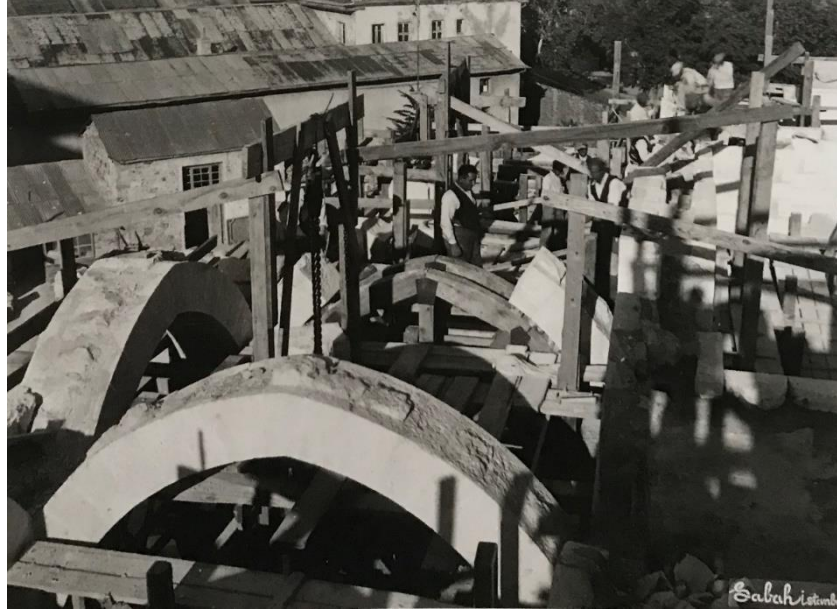
Resim 234: Revak Kemerleri İnşaatından Görünüm
