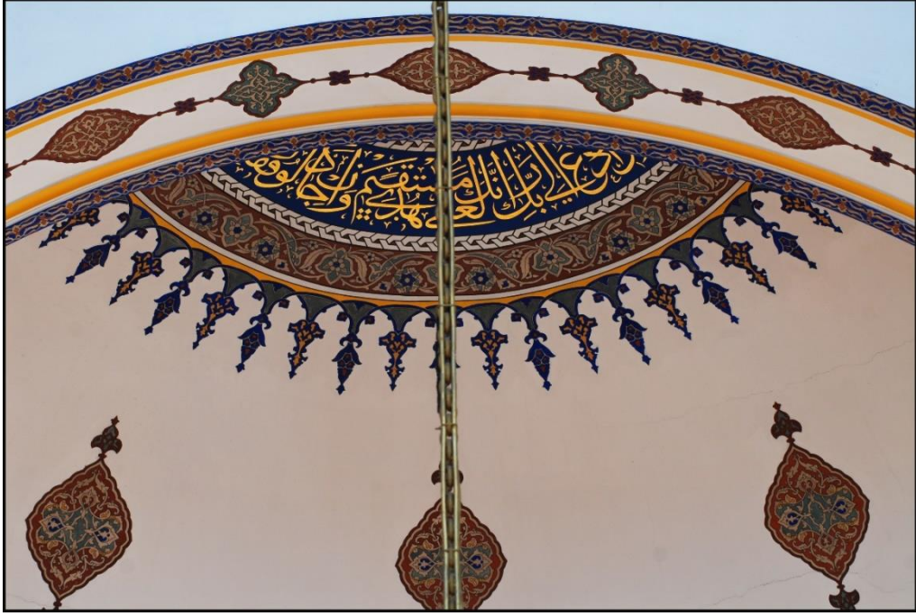
Resim 21: Güney Yarım Kubbe Hattı ve Tezyînatı (F: M. Yılmaz)
