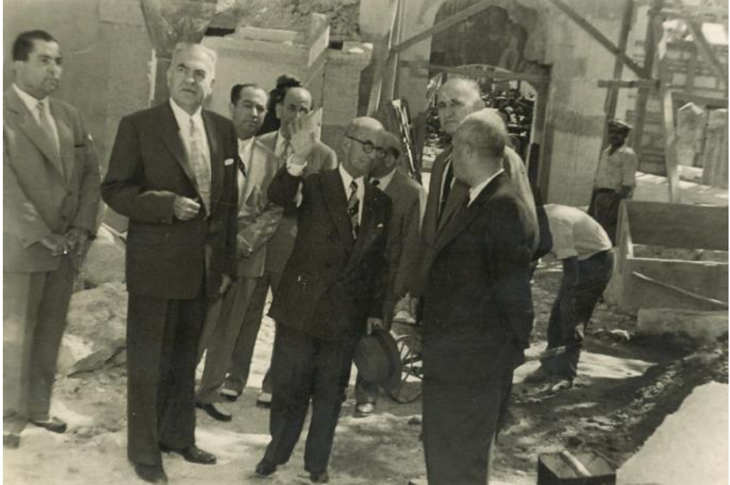
Resim 228: İstanbul Valisi Lütfi Kırdar'ın Şişli Camii'ni Ziyaretinden Görünüm
