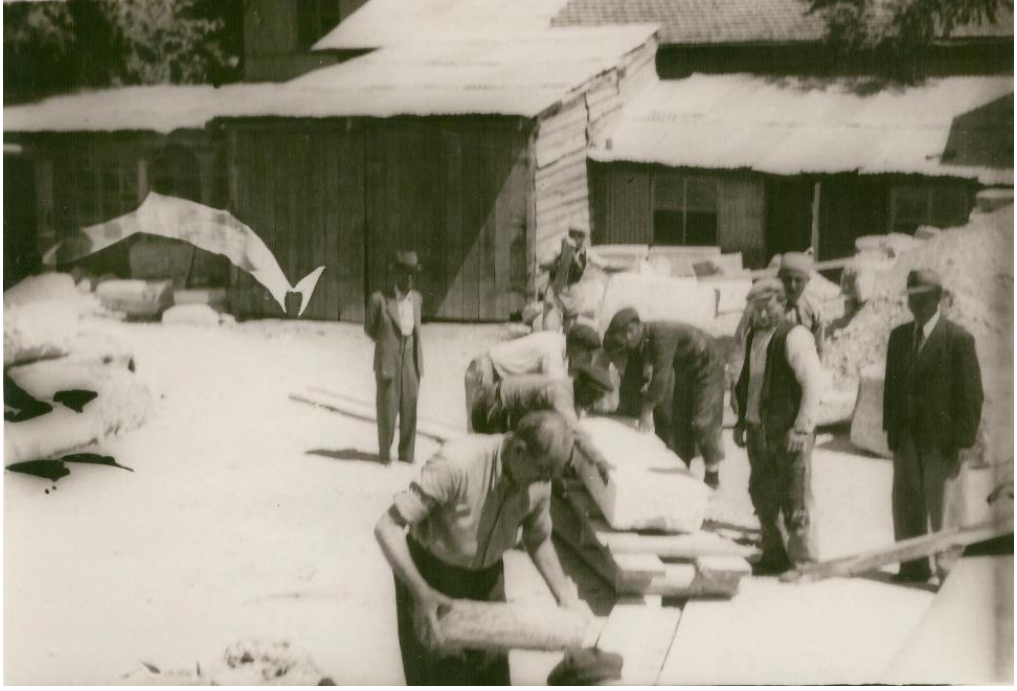
Resim 182: Cami İnşaatında Çalışan İşçiler (ŞCVFA)
