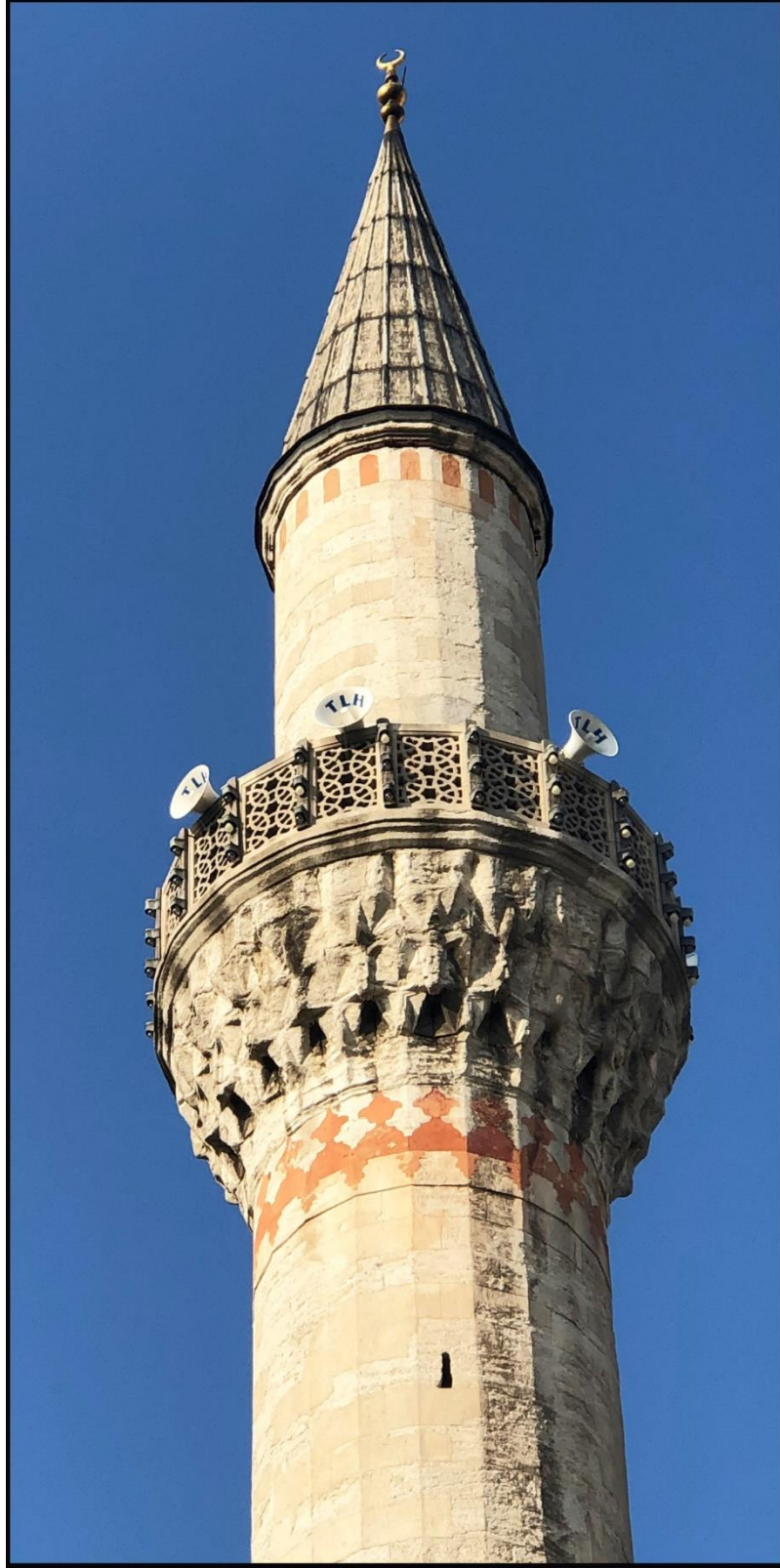
Resim 44: Şişli Camii Minaresi (F: Y. Turgut)
