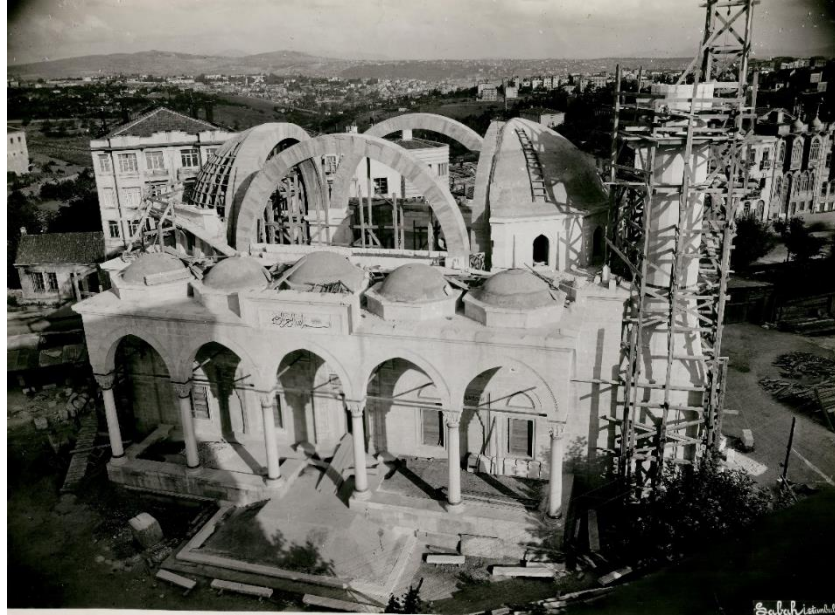
Resim 237: Şişli Camii Kubbe ve Minare İnşaatından Görünüm (ŞCVFA)
