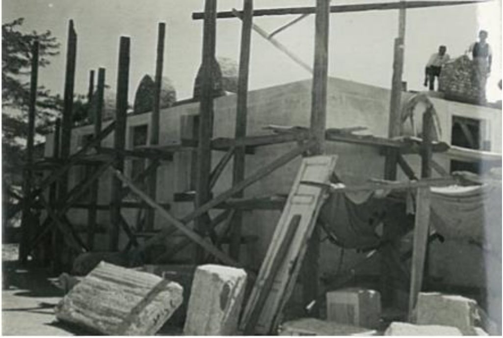
Resim 221: Cami İnşaatından Görünüm
