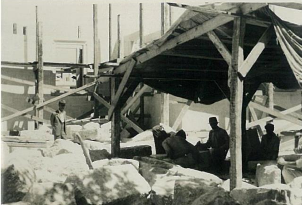
Resim 186: Cami İnşaatında Çalışan İşçiler
