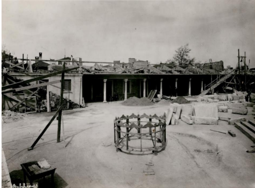
Resim 263: Caminin Şadırvan ve Müştemilat İnşaatından Görünüm (ŞCVFA)
