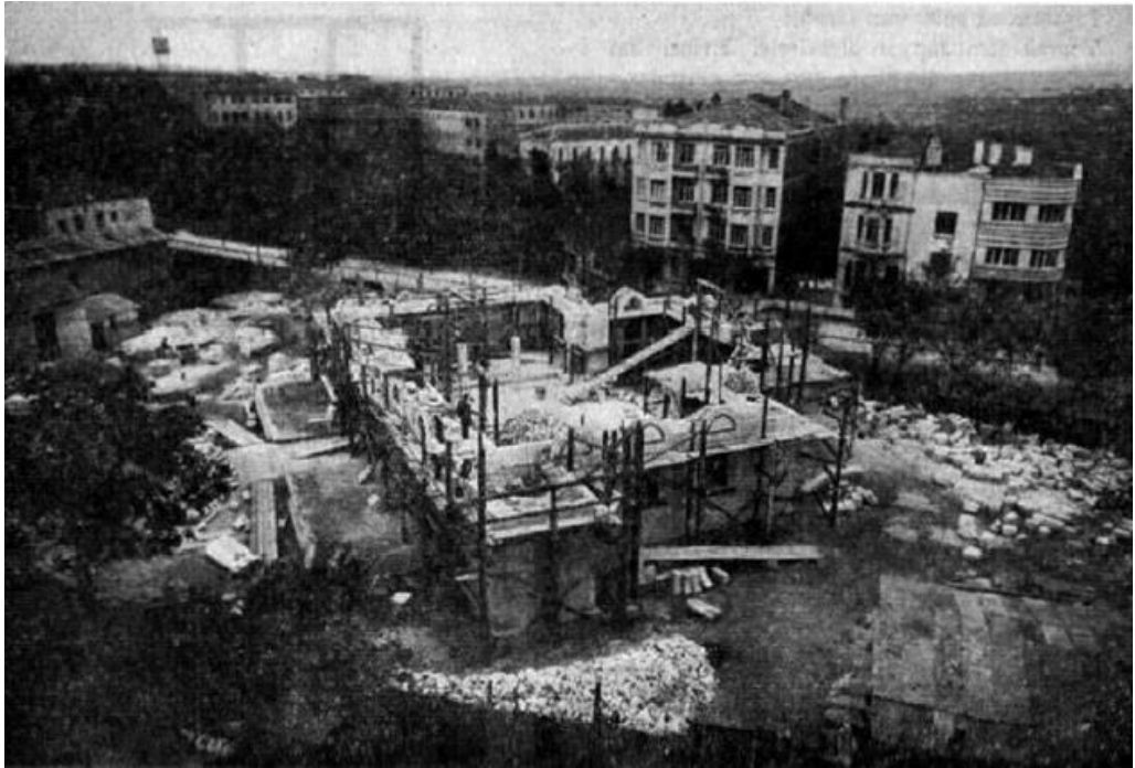
Resim 208: Cami İnşaatından Görünüm
