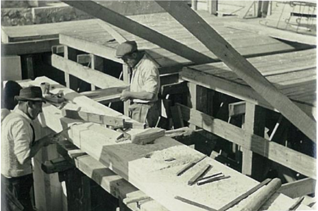
Resim 187: Cami İnşaatında Çalışan İşçiler
