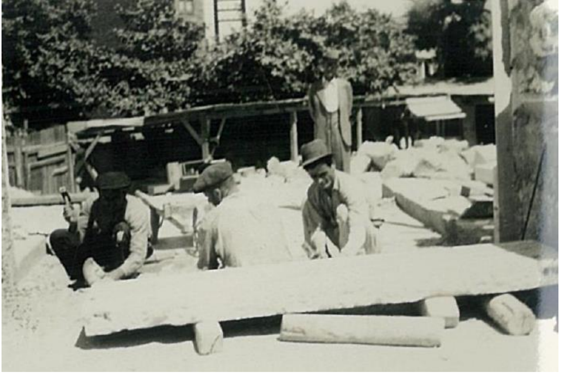
Resim 189: Mimar Egeli İnşaatı Çalışan İşçileri Denetlerken
