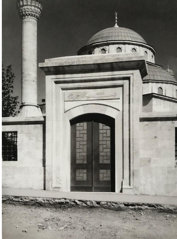
Resim 273: Eski Fotoğraflarda Güney Yöndeki Avlu Giriş Kapısından Görünüm
