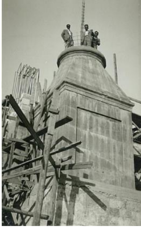
Resim 215: Mimar Egeli'nin de Bulunduğu Minare İnşaatından Görünüm
