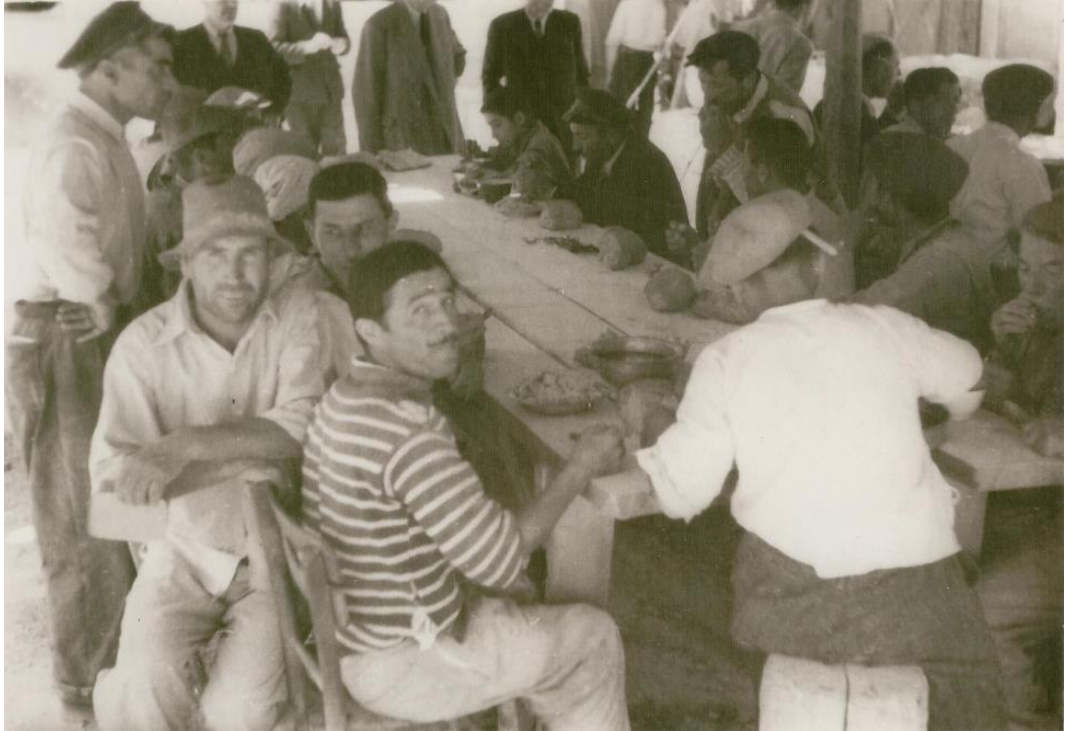
Resim 185: Cami İnşaatında Çalışan İşçiler (ŞCVFA)
