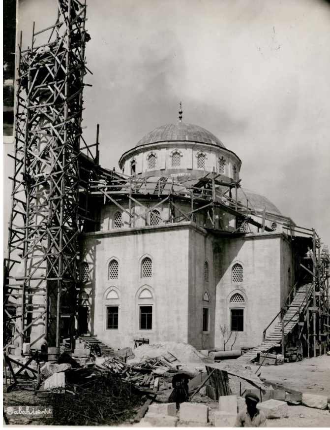
Resim 260: Minarenin İnşaatından Görünüm (ŞCVFA)
