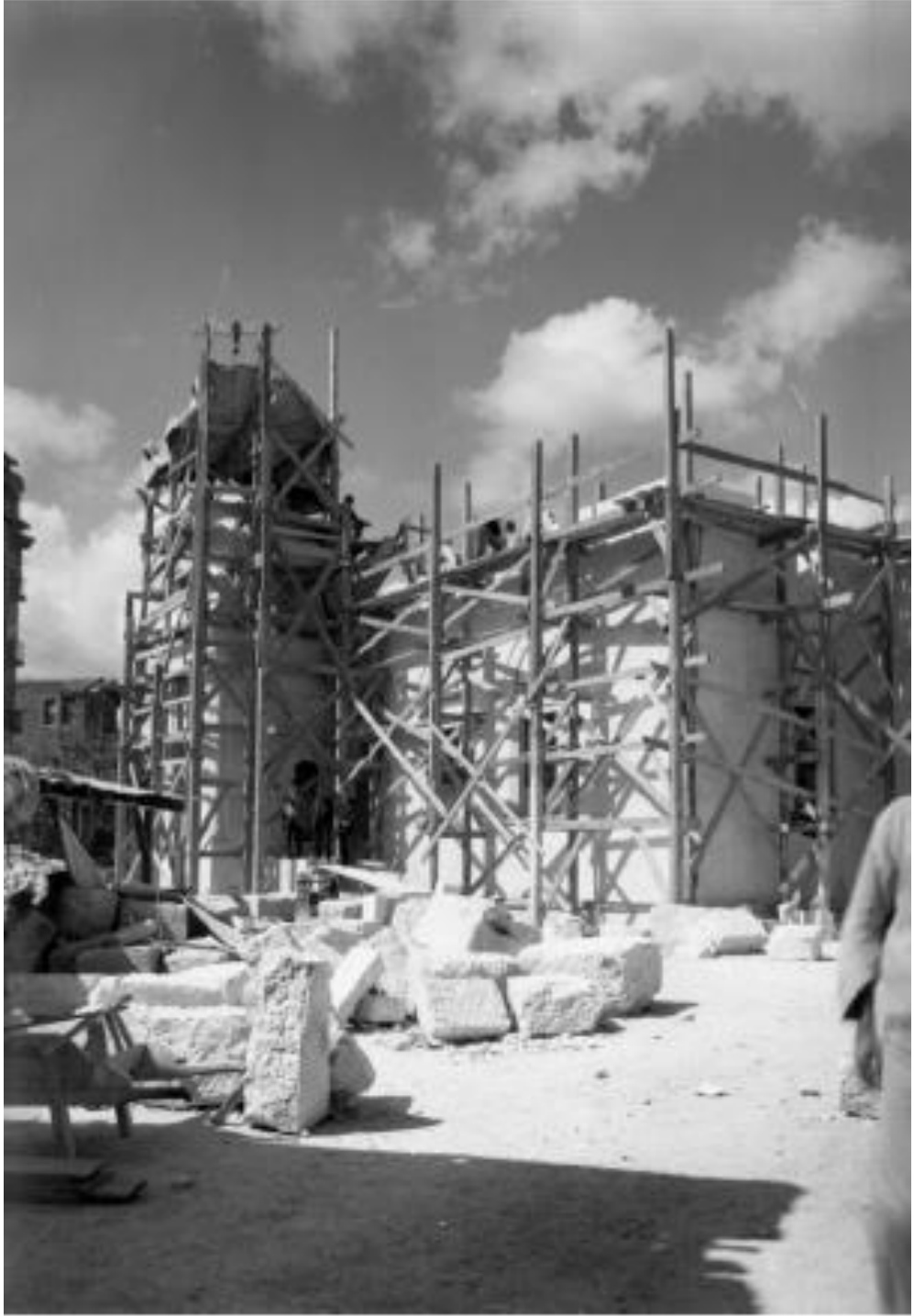
Resim 202: Cami İnşaatından Görünüm
