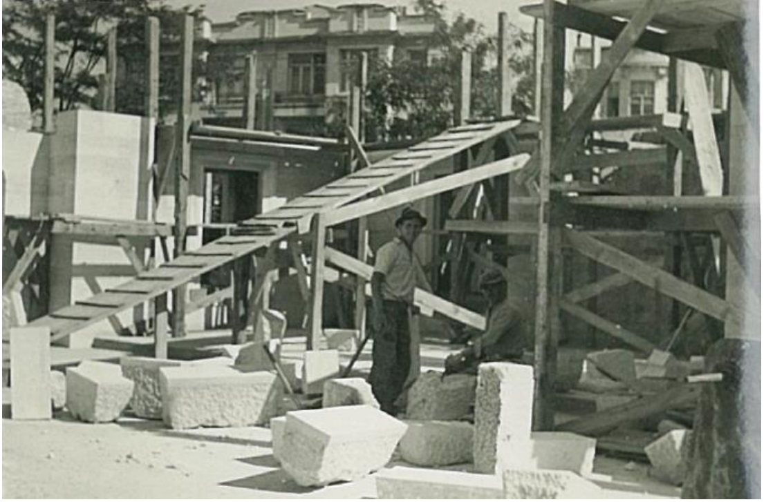
Resim 190: Cami İnşaatında Çalışan İşçiler
