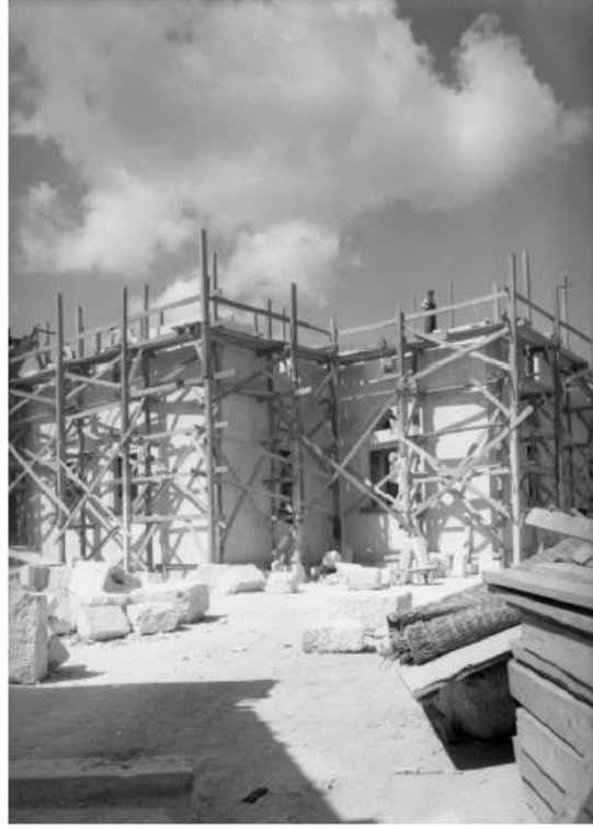
Resim 200: Cami İnşaatından Görünüm
