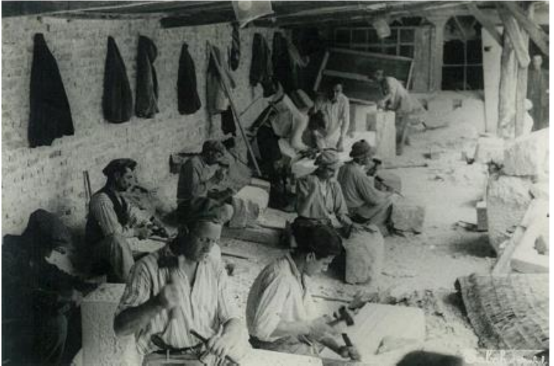
Resim 191: Cami İnşaatında Çalışan İşçiler
