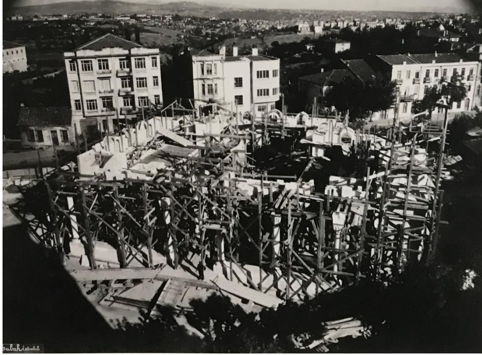
Resim 223: Cami İnşaatının Kuzeyden Görünümü
