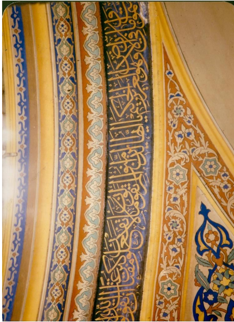
Resim 124: Eski Fotoğraflarda Restorasyondan Önce Kubbe Kasnağındaki Kuşak Yazısı (ŞCVFA)
