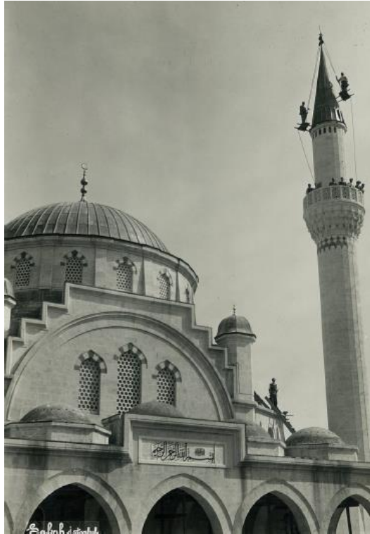
Resim 267: Cami İnşaatından Görünüm
