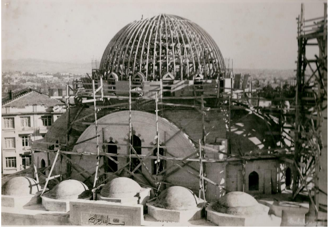
Resim 241: Şişli Camii Ana Kubbe İnşaatından Görünüm (ŞCVFA)
