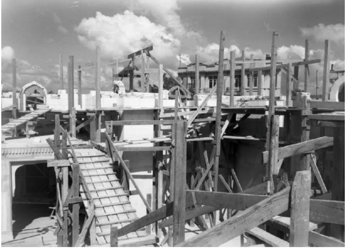
Resim 198: Cami İnşaatından Görünüm
