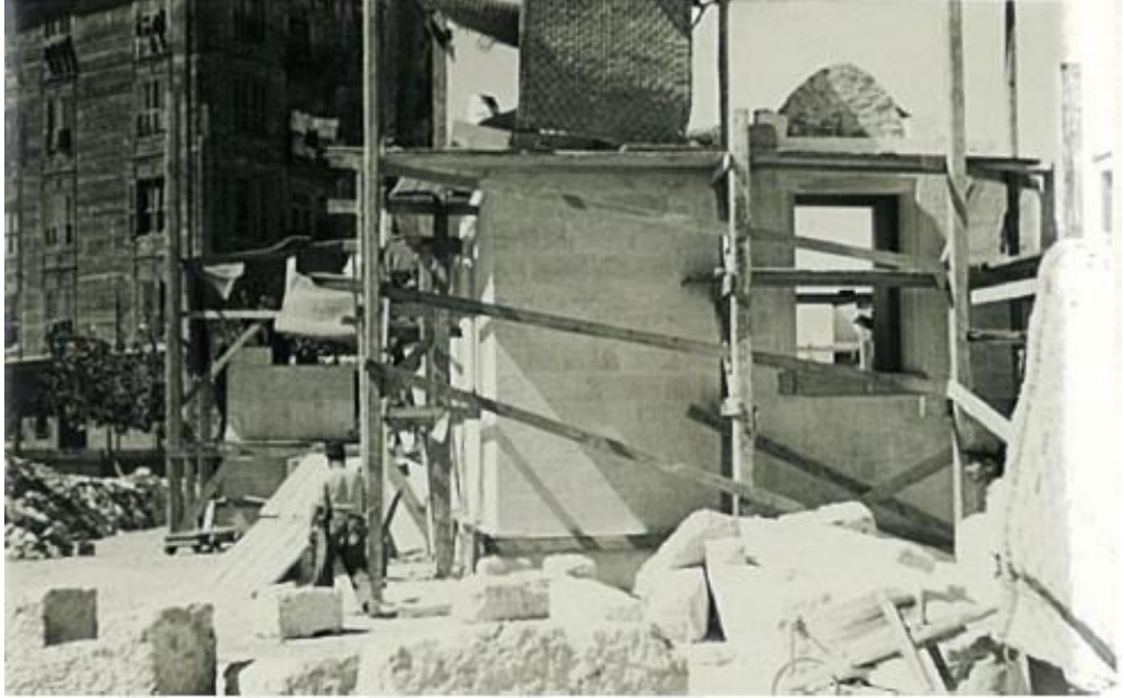
Resim 220: Cami İnşaatından Görünüm
