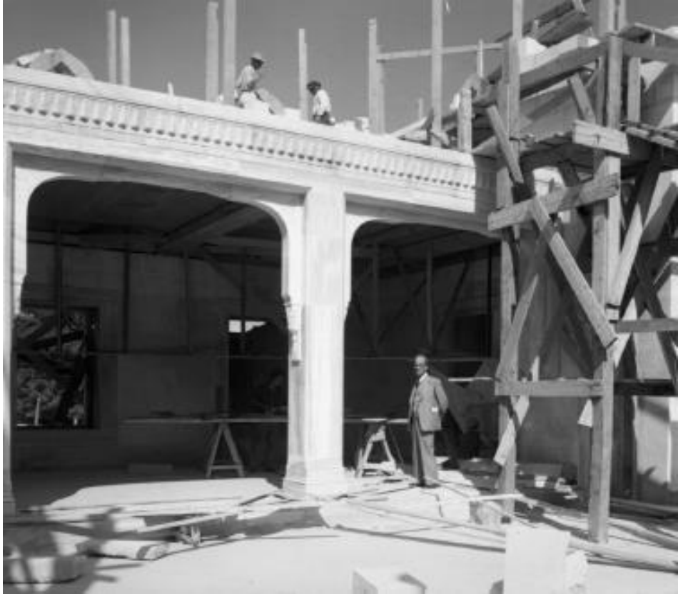
Resim 210: Mimar Vasfi Egeli'nin de Bulunduğu Cami İnşaatından Görünüm (Sümevra Öztürk, Mimar Vasfi Egeli: Hayatı ve Çalışmaları (1890-1962) , YL Tezi, s. 112; ayrıca bkz. Başbakanlık Vakıflar Genel Müdürlüğü Arşivi)
