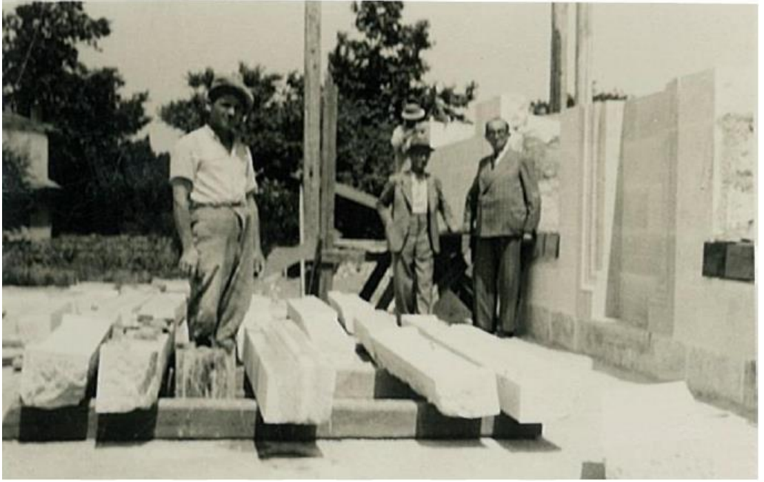
Resim 188: Mimar Egeli'nin de Bulunduğu Cami İnşaatından Görünüm
