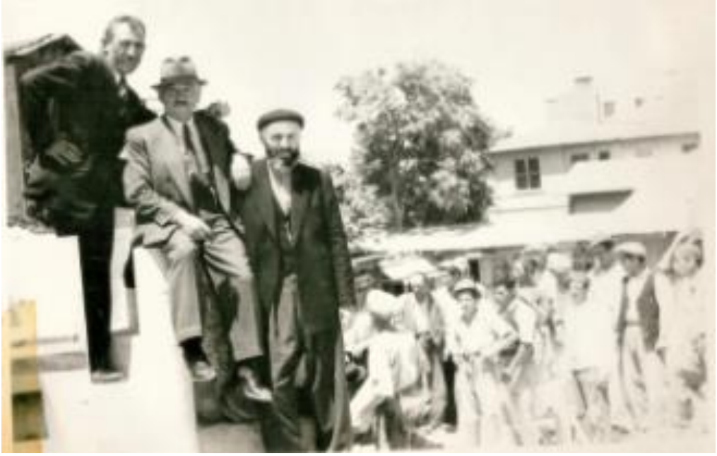
Resim 184: Cami İnşaatında Çalışan İşçiler (ŞCVFA)
