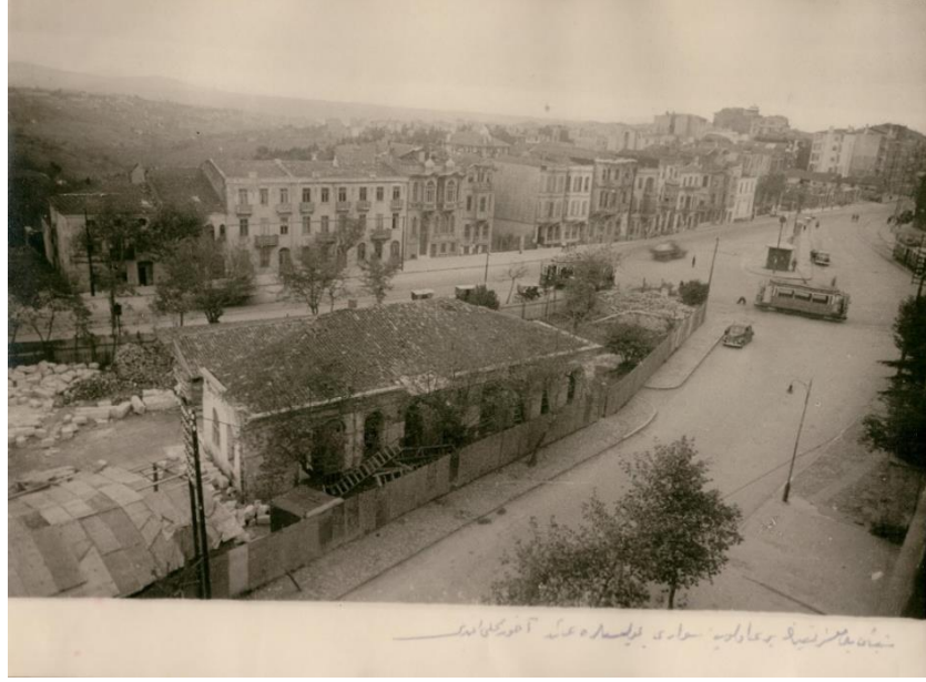
Resim 2: Caminin İnşâsından Önce Yerinde Bulunan Yapı 114 (ŞCVFA)
