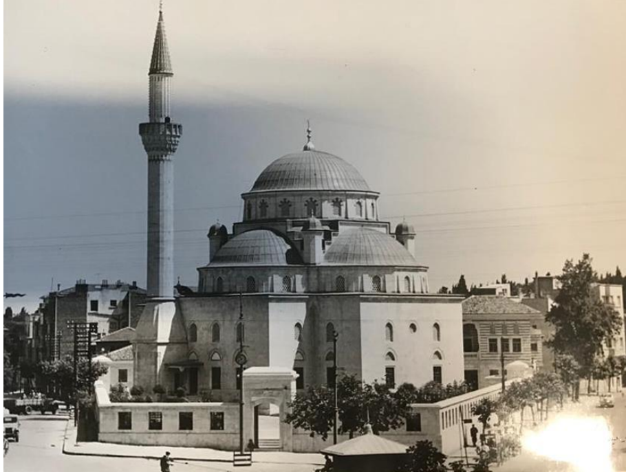
Resim 173: Eski Fotoğraflarda Caminin Güney Cephesinden Görünüm(ŞCVFA)
