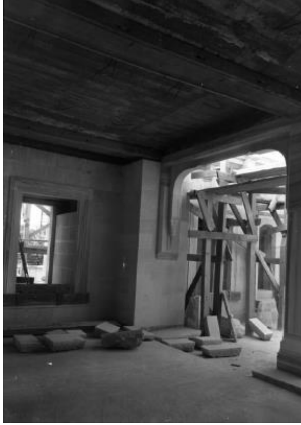
Resim 213: Cami İnşaatından Görünüm
