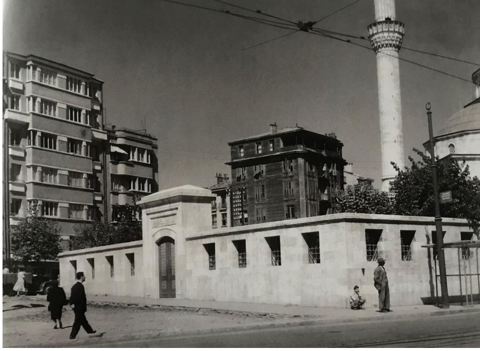
Resim 272: Cami Çevresi ve Avlunun Güney Cephesinden Görünüm
