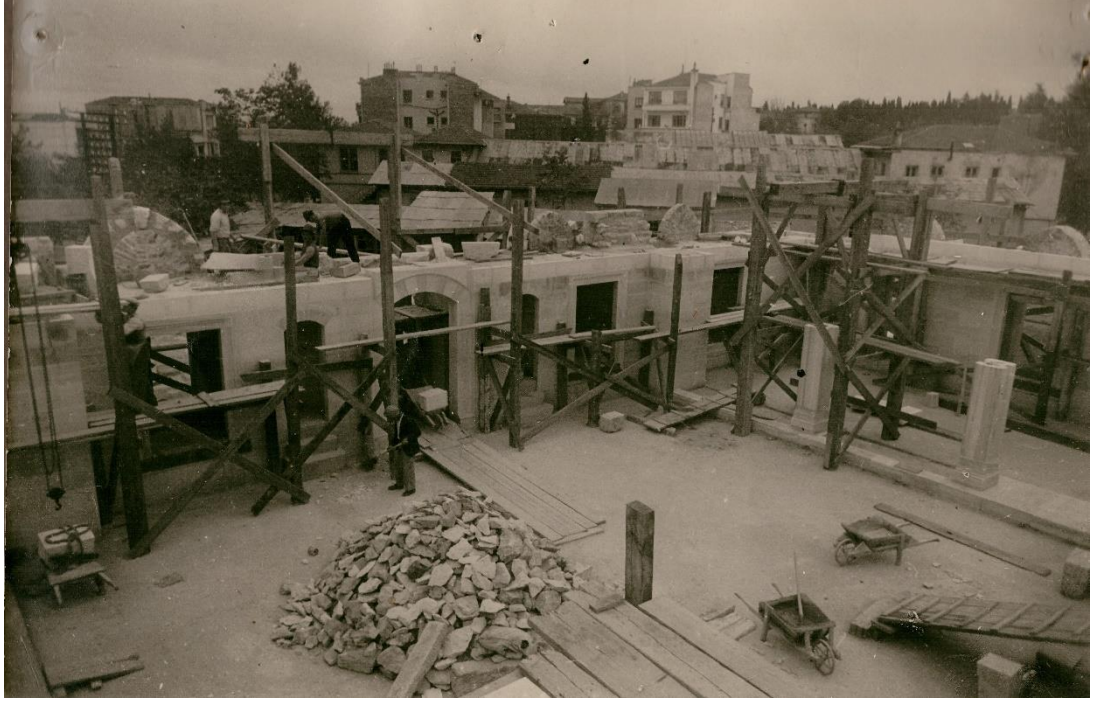
Resim 203: Caminin İnşasında Harimden Görünüm (ŞCVFA)
