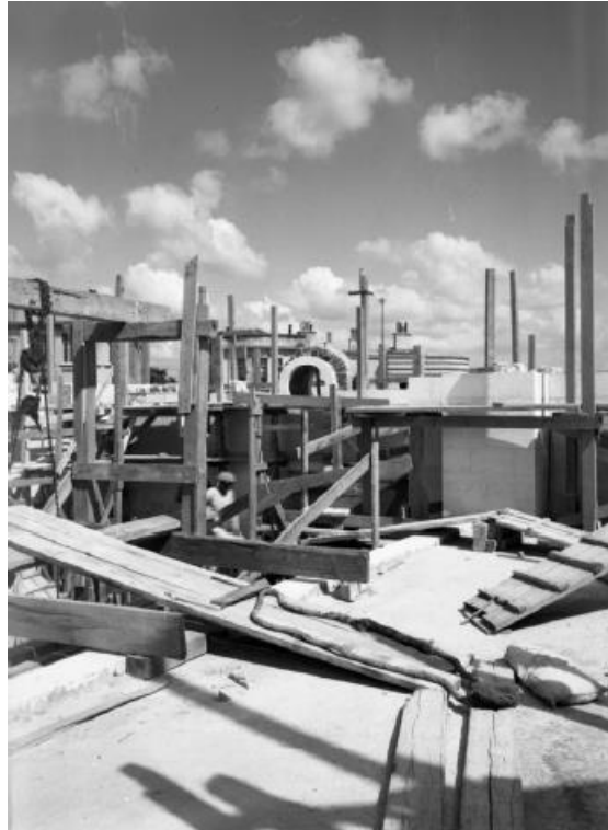
Resim 201: Cami İnşaatından Görünüm
