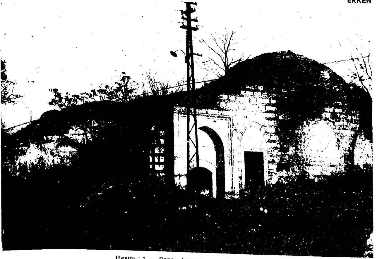
Resim : 1 — Saray hamamı genel görünüş
