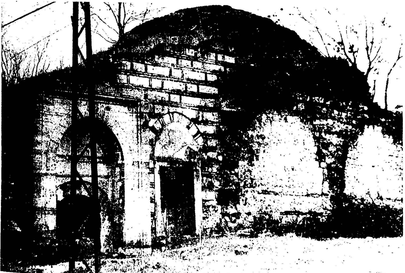
Resim : 2 — Saray Hamamı erkekler kısmı cümle kapısı ve batı cephesi
