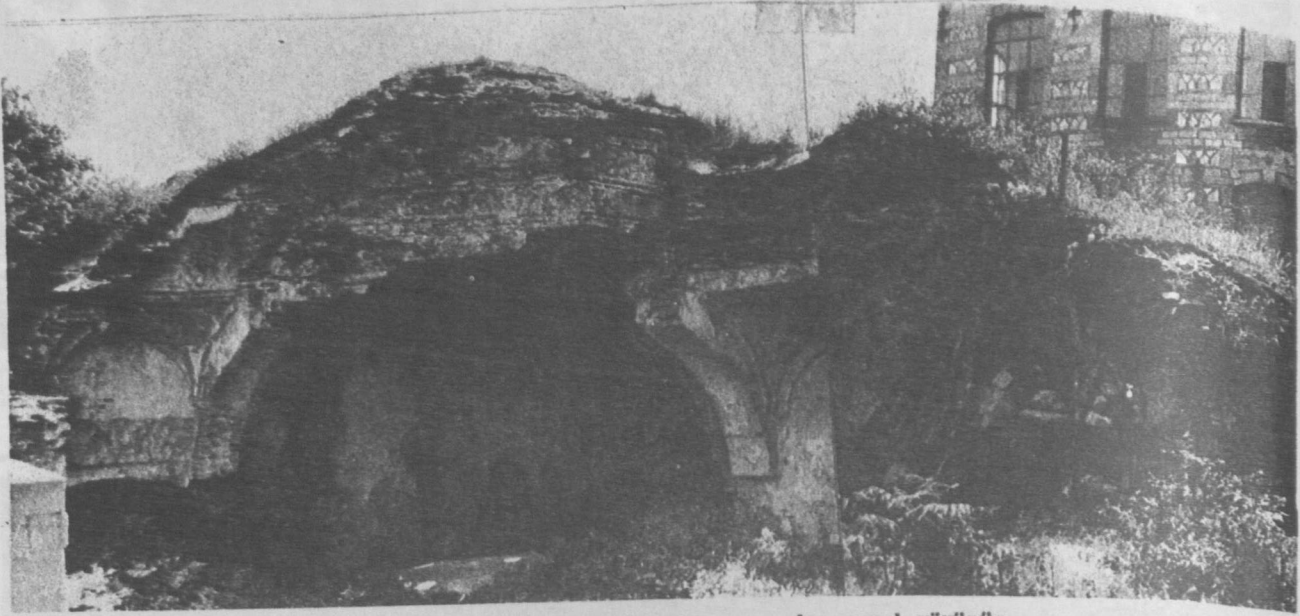
Resim : 26 — Topkapı hamamı sıcaklık kısmından genel görünüş
