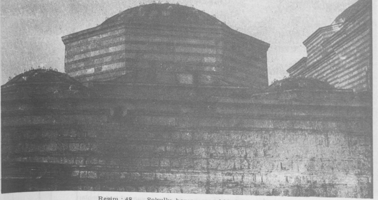
Resim : 48 — Sokullu hamamı sıcaklık kubbeleri
