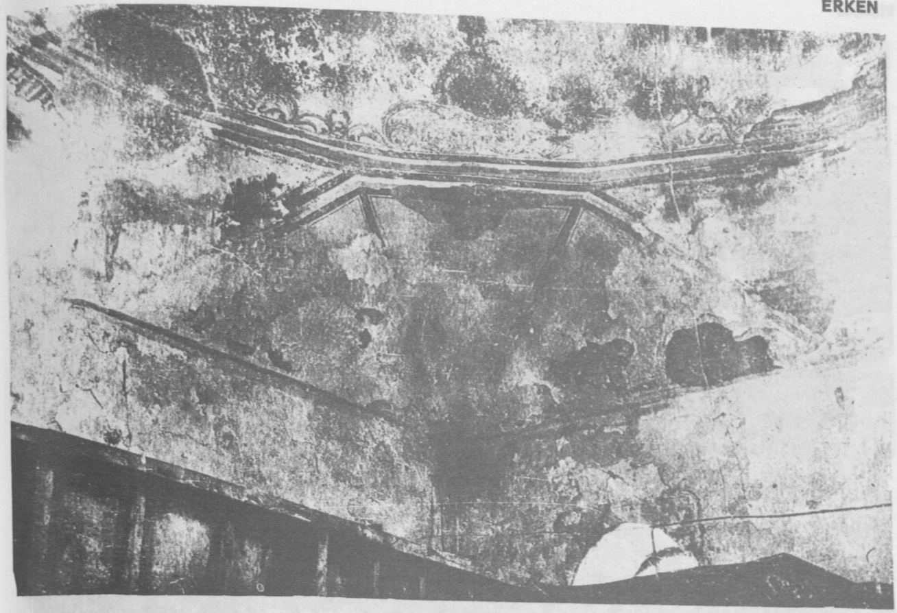
Resim : 24 — Tahtakale hamamı kadınlar kısmı soyunmalığı kubbe intikali
