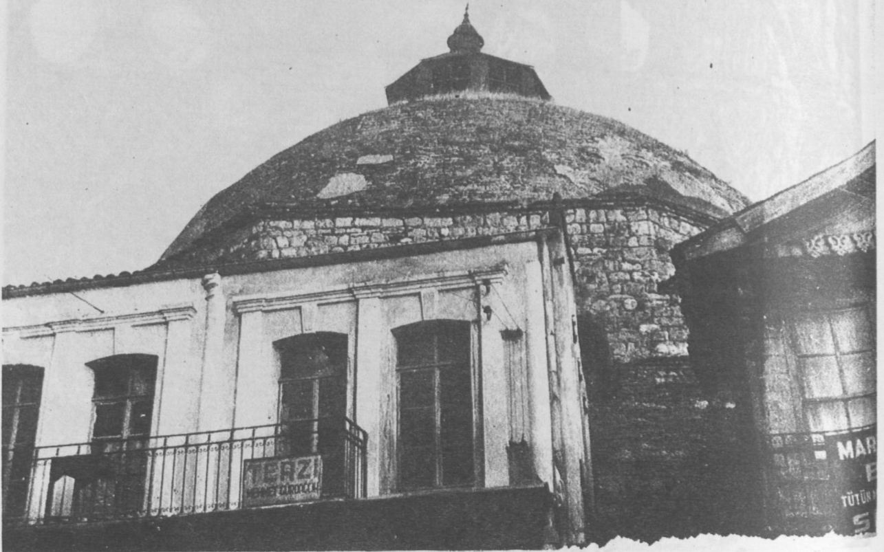
Resim : 19 — Tahtakale hamamı erkekler kısmı soyunmalığı kubbesi
