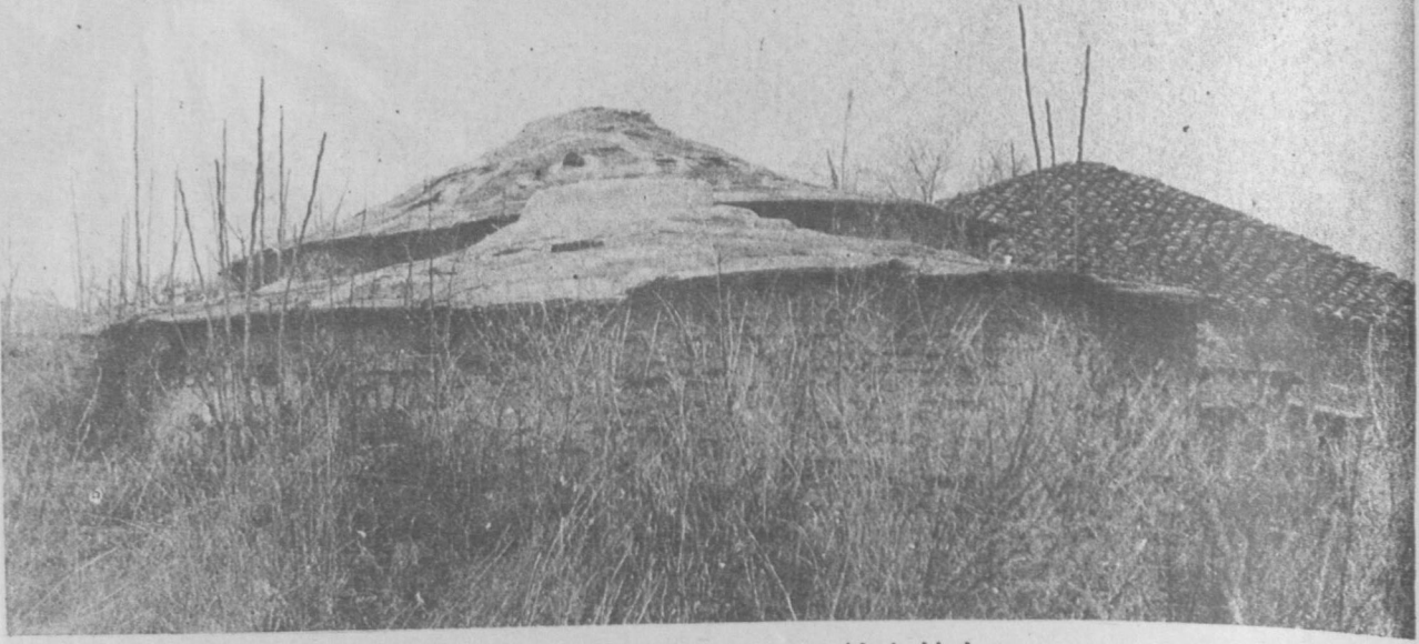
Resim : 42 -- Aptullah hamamı sıcaklık kubbeleri
