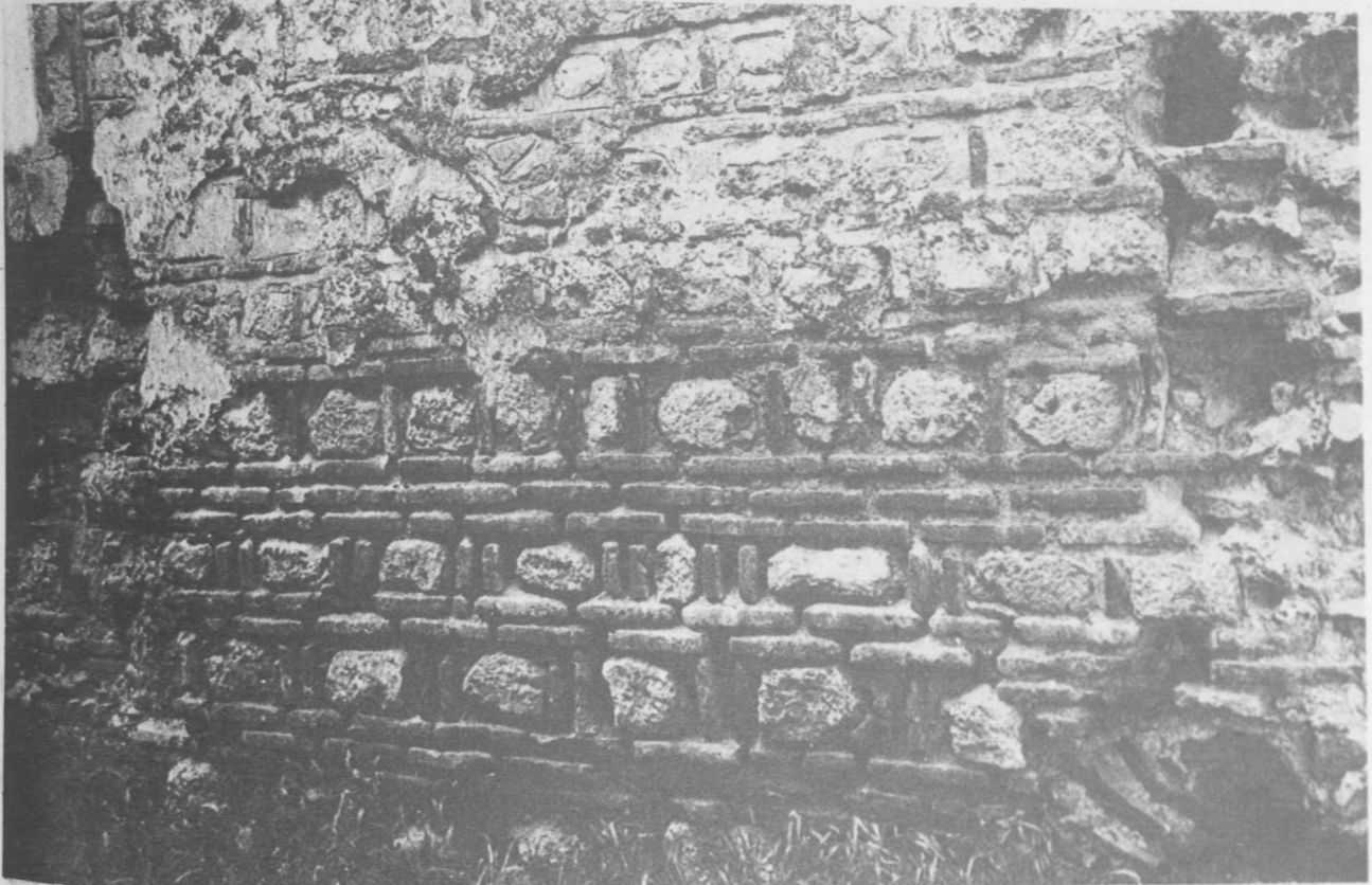
Resim : 37 — Beylerbeyi hamamı duvar detayı
