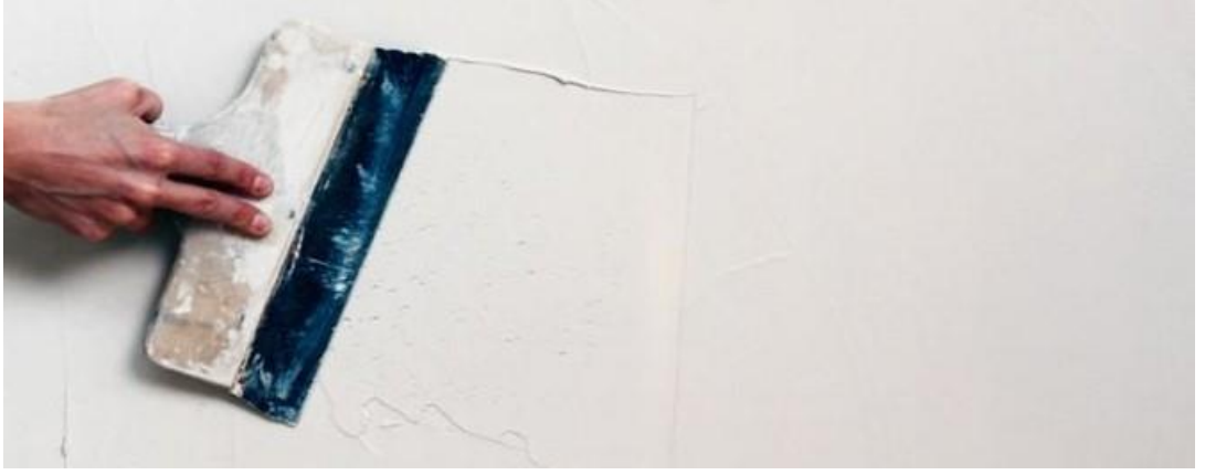
Resim 15. Edirnekâri yapılacak yüzeye astar çekilmesi.
