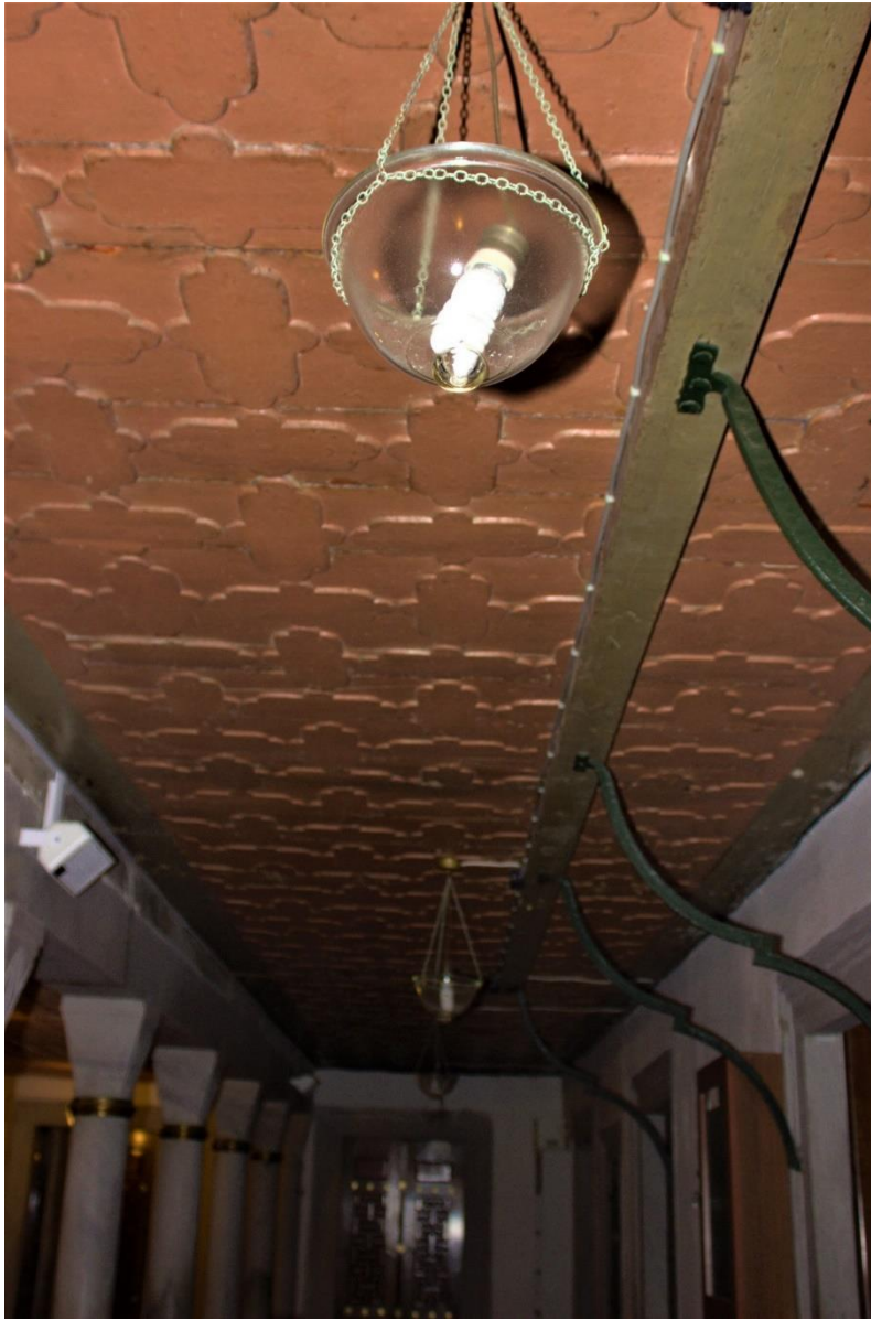
Resim 84. Camiye batı kapısından girince sağda kible duvarına dek uzanan mahfil edirnekârileri.
