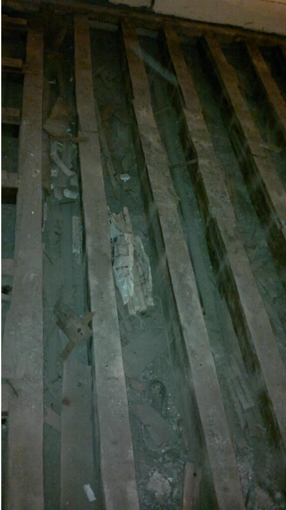
Resim 36. Kılıç Ali Paşa Camiinin mahfil tavanının üst örtü sisteminin kalkmış hali.
