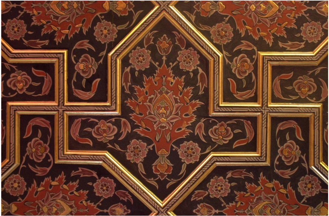
Resim 62. Çıtakâri ve kaset içlerinden detay görünümü. (Restorasyon sonrası)
