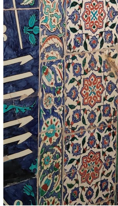
F. 142 Beylerbeyi Camii mihrap duvarı
