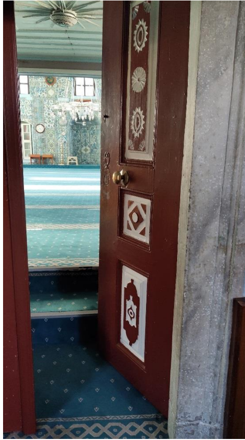
F. 7 Harime açılan kapı ve ahşap tavan detayı
