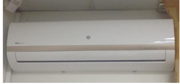
Şekil 3.16: Duvar Tipi Split Klima Dış Ünite Detayı ve İç Ünite Görseli (Baymak Klima, 2017).
