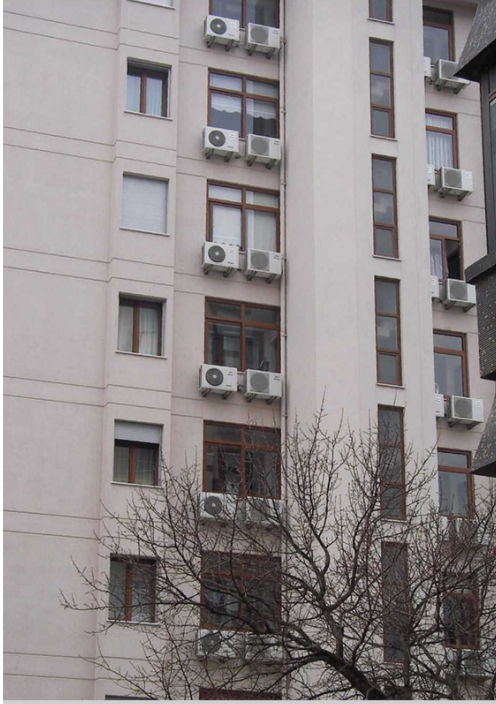
Düzenli Mini Split Dış Ünite Yerleşimi
