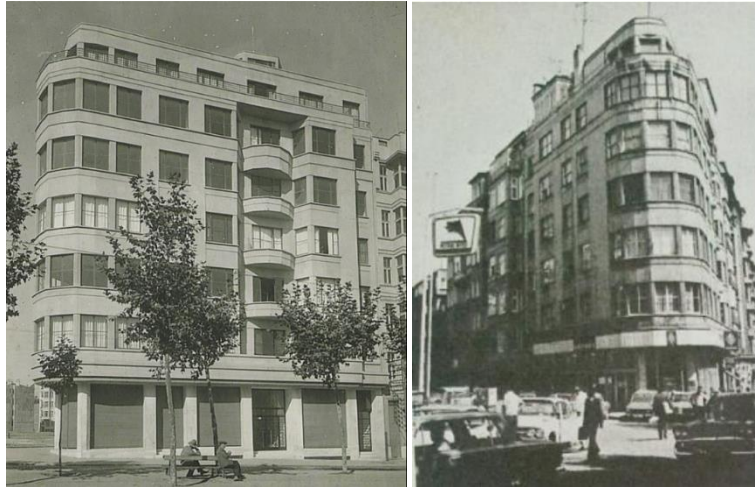
Şekil 2.5: Ceylan Apt Dış Cephe Görünüşleri (Aslanoğlu, 2010).
